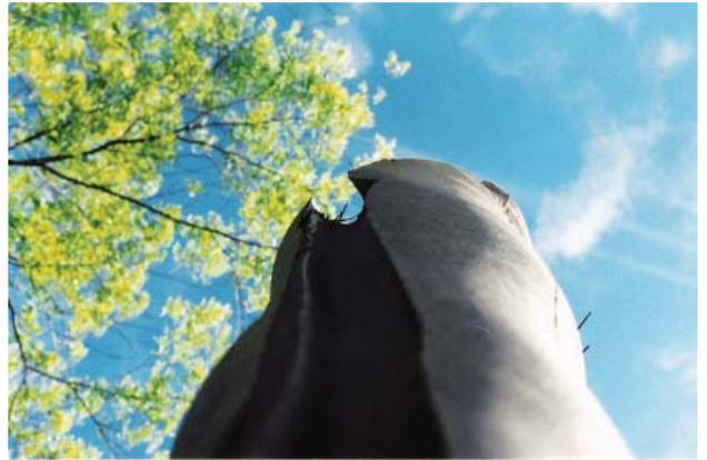
Imagen 11. Parapetos de hormigón en moldaje flexible. Travesía a Misiones, Argentina.
