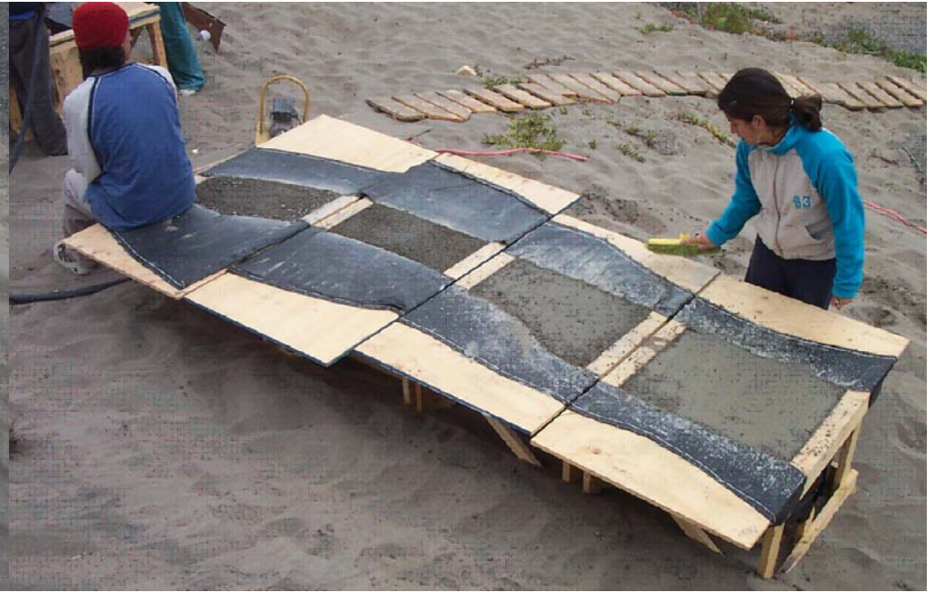
Moldaje flexible, llenado y listo para ser desmoldado.
