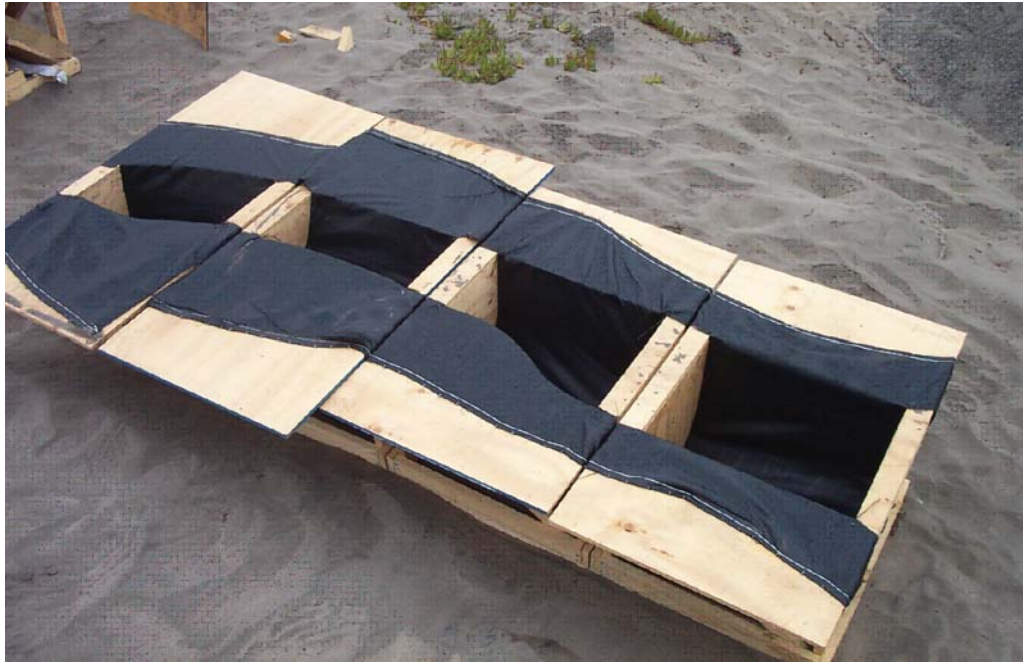
Moldaje flexible previo al vaciado con hormigón.
