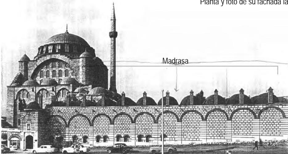
Cada *iwán* posee su propia cúpula y chimenea. La primera proviene de un orden divino, ya que representa la cercanía a lo divino. La chimenea por otra parte, tiene una función climática, ya que, junto con la gran altura de suelo a cielo, produce una ventilación forzada, permaneciendo fresco el interior.
