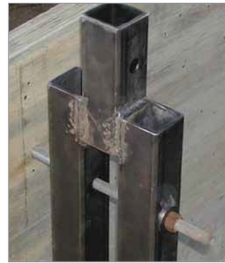
Unión lámina de terciado y separador.
