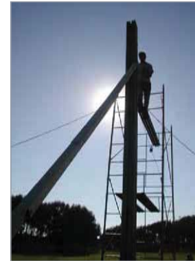
se levantan los pilates a través de puntales y poleas
