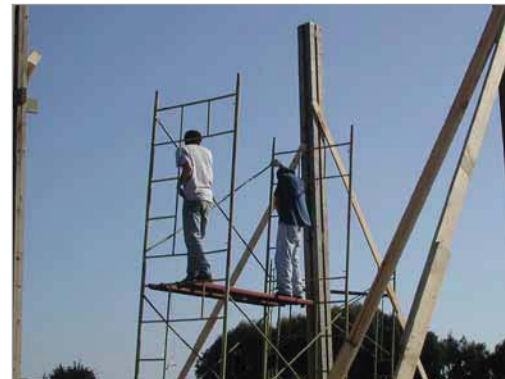
refuerzo de pilares con diagonales enterradas.
