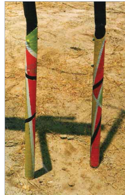
Pilares de la obra.
