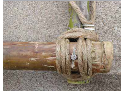
Amarre cuadrado, clavo y corchete para fijar las uniones del módulo.
