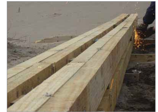
terminaciones antes del montaje.
