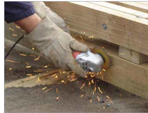
corte del excedente de hilo metalico.
