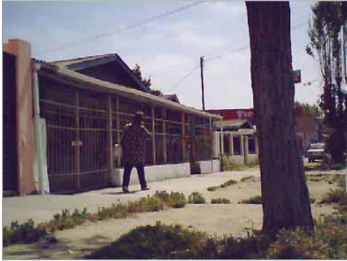
Exterior actual de la sede, hermetico al socio que espera. (Calle Chorrillos, Quilpue.)
