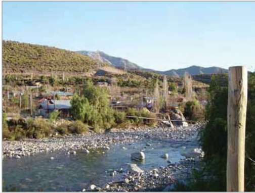
Vista lateral puente colgante .
