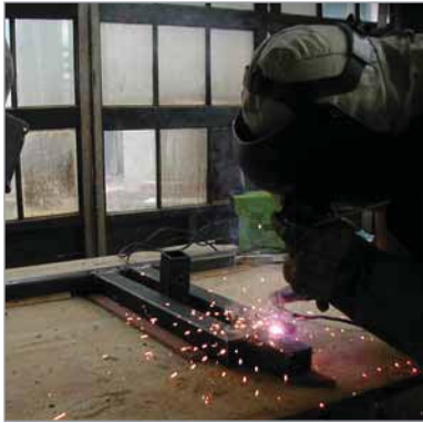
Soldadura de separadores de la viga.
