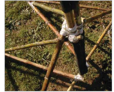
Visagra que une los módulos para conformar la rueda.
