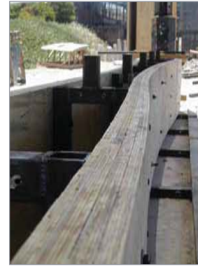
Construcción de la curva.
