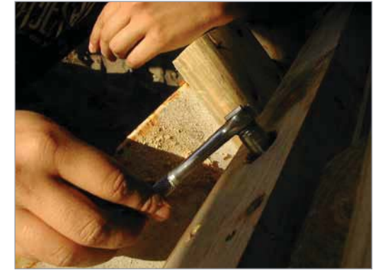
desarme de pilar
