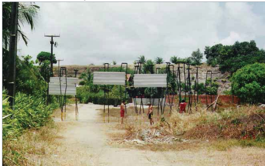
Obra finalizada, vista antes del regreso.
