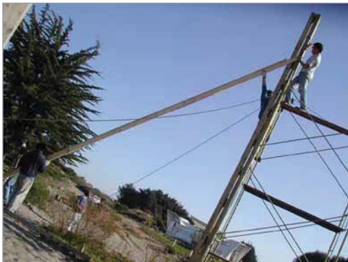
se sostiene el pilar mientras se fija la base con hilos y pernos
