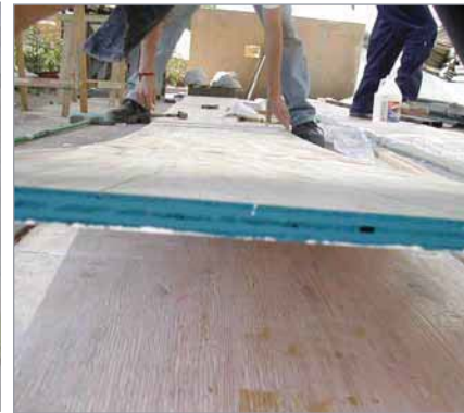
Encolado del traslape de planchas.
