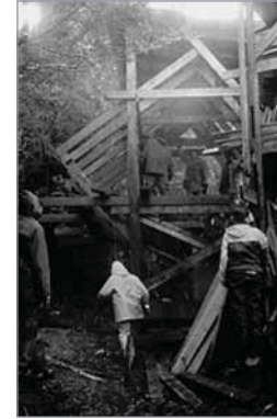
Obra travesía Llancahué, 2003.
