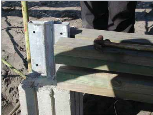
apoyo del pilar en su base
