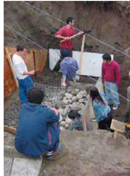
7/ Al unísono se comienza a levantar la otra columna de gaviones para ir rellenando el resto de los módulos en forma progresiva y escalonada como en una pirámide.
