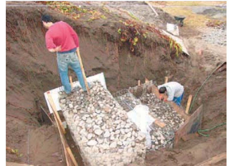
7/ Al unísono se comienza a levantar la otra columna de gaviones para ir rellenando el resto de los módulos en forma progresiva y escalonada como en una pirámide.
