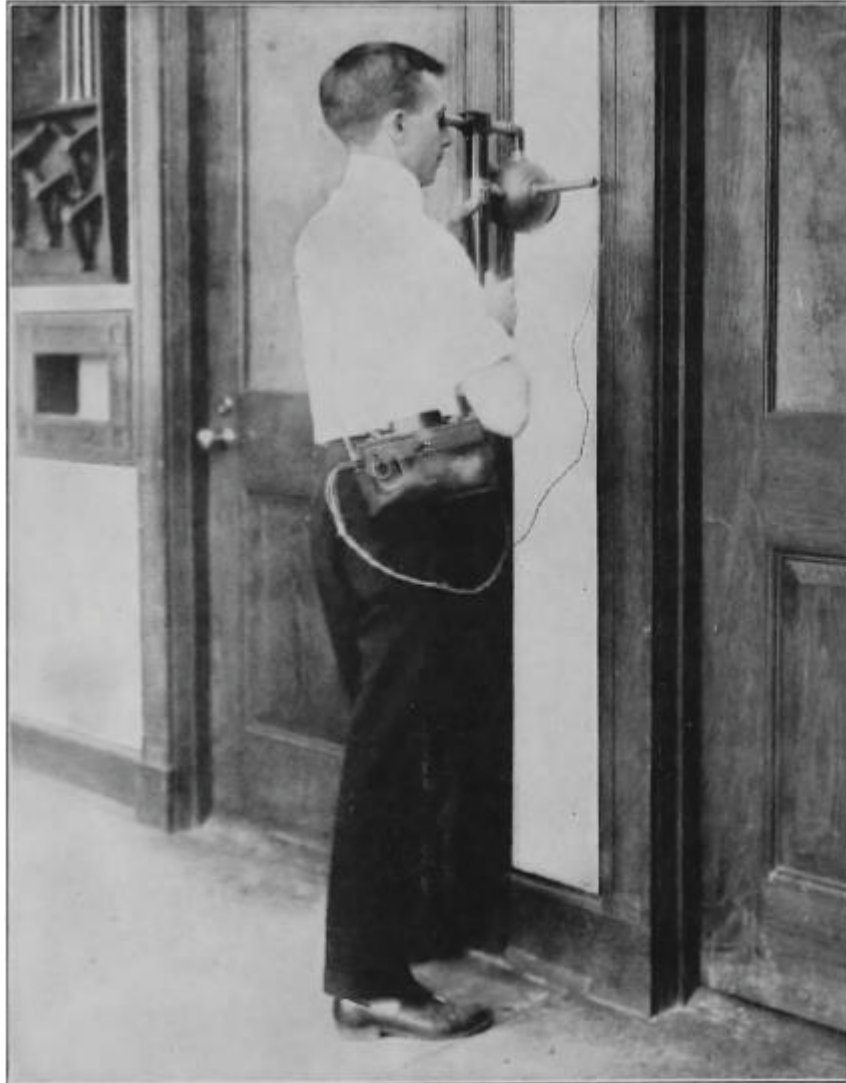
Figura 3-2: Método de utilización del instrumento para medir el factor de reflexión de una pared
