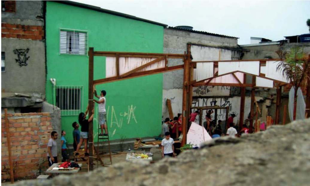
Img.31|Trabajos en la obra de Heliopolis Archivo personal
