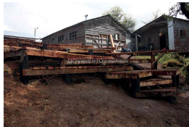
Img.34 y 35 | Trabajos en obra en Pailad Archivo personal
