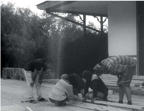
Img. 34 y 35 | Trabajos en Gualliguaica Archivo personal
