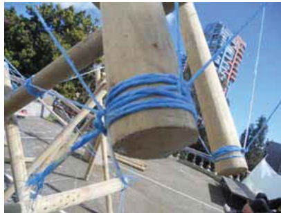
Unión barra-tensor.
