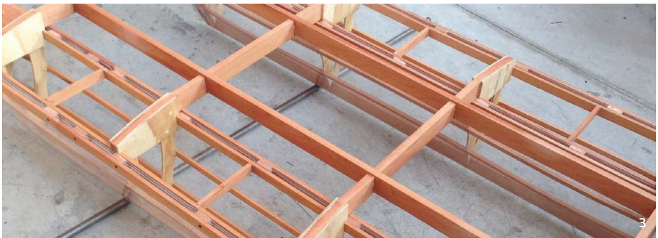
Fig1.- Las vigas de unión y de apoyo que juntan los dos cascos
