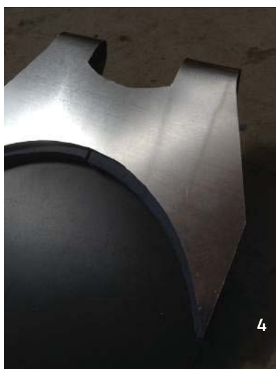
Fig4.- Detalle de la envoltura de aluminio Fig5.- Despiece de la aleta Fig6.- Armado de la aleta con remaches
