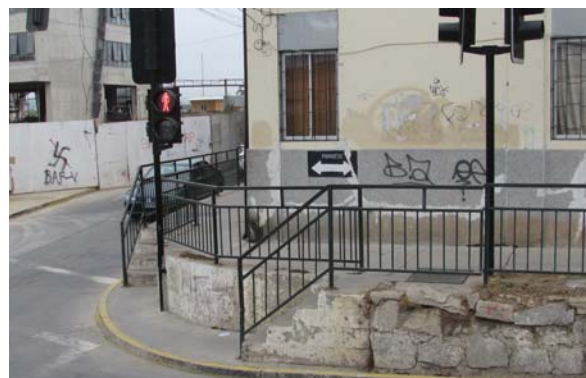
fig. 128 Cruce peatonal sin accesibilidad Universal, no existe rampa de acceso , ni rebaje de solera.
