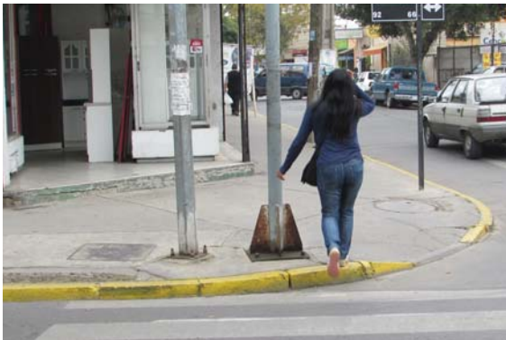
fig. 131 Obstaculización con mobiliario urbano , el rebaje de solera esta en la esquina y no concuerda con la dirección del tránsito.
