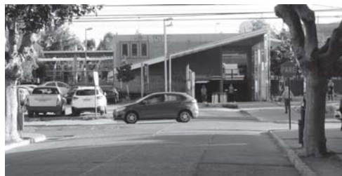
fig. 124 Acceso Norte Estación, desde la Ciudad (fotografía autoría propia)
