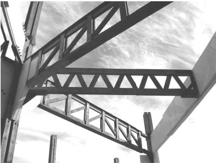
ejemplos de cerchas en la vestal, al mismo modo que en la galería, vigas howe diagonales (de pilar a pilar) y warren ortogonales (de pilar a vigas maestras)
