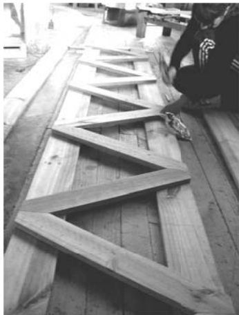
construcción de las seis vigas warren en el taller de los diseños
