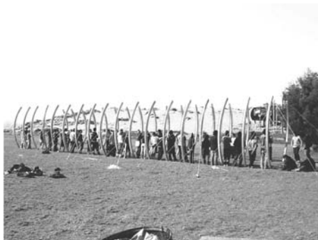
taller de segundo año en el levanta- miento de las cuadernas, de a dos afirman una, un tercero es- taca el viento
