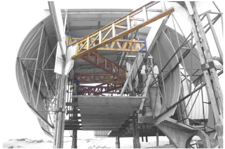
ejemplos de cerchas en la vestal, al mismo modo que en la galería, vigas howe diagonales (de pilar a pilar) y warren ortogonales (de pilar a vigas maestras)
