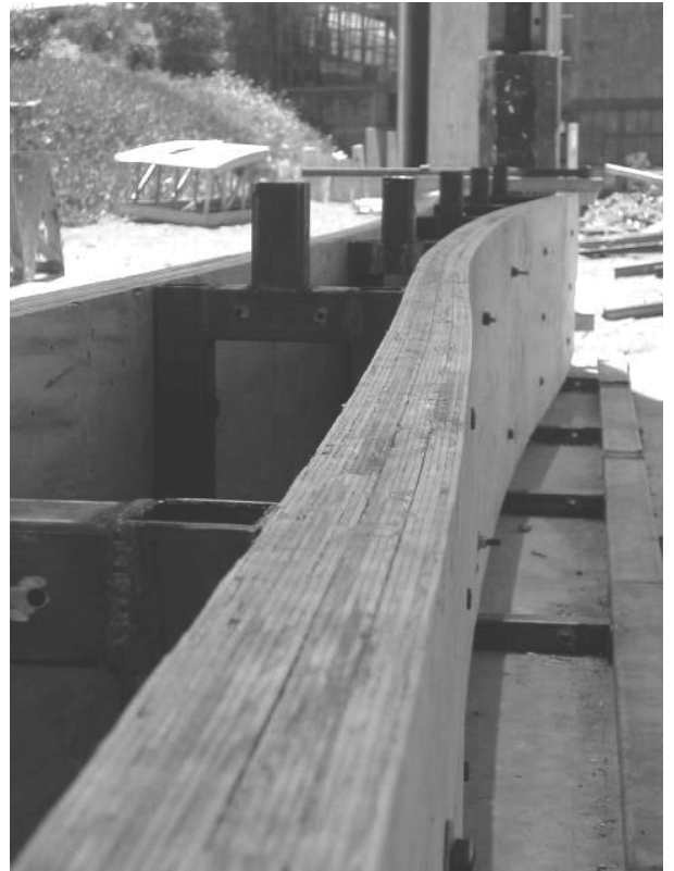
los separadores y sus tres tamaños dan la curva de la viga maestra además de ser los soportes de los tirantes que sujetan el suelo
