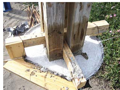
las piezas se ensamblan en la coronación fijándose exactamente en los 4 ángulos y nivelando la llanta en su estructura
