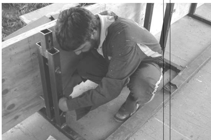
Separadores. En el taller del año anterior se fabricó una matriz de hierro para el armado de la Viga Maestra. Se presentan los separadores para sobreponer luego las partes laminadas y apenarlas a estos.
