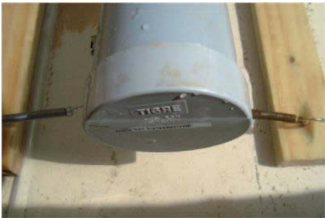
Figura 248. Detalle fijación anclajes
