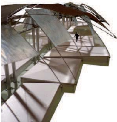
Fig 259. Suelos y techos alzados en marea alta
