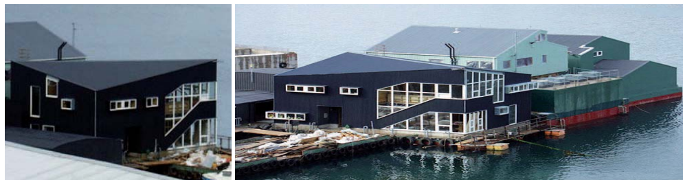
Figura 158. Vista de la casa en atraques de construcción. www.plataformaarquitectura.cl
