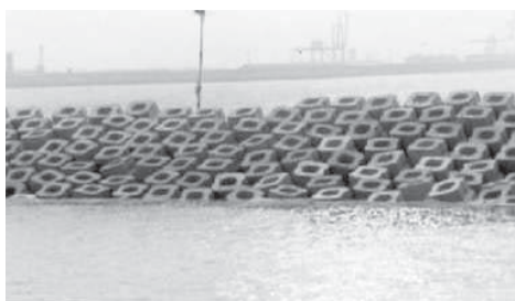
Fig 269. Coraza con Unidades Tipo Halo
