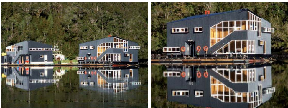
Figura 161. Vista de las casas terminadas. www.plataformaarquitectura.cl
