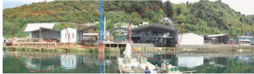
Figura 156. Vista de los galpones de construcción desde el agua. Registro fotográfico magister
