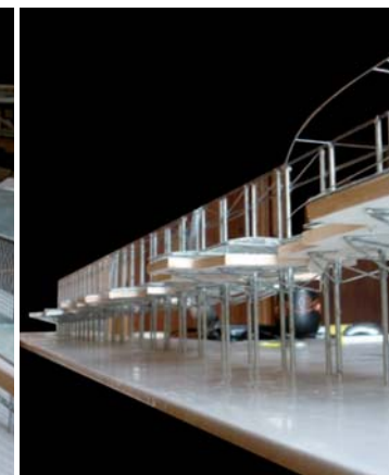
Figura 231. Estructura piramidal apoyo plataformas
