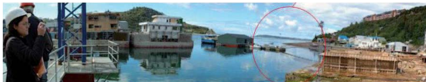
Figura 157. Vista patio construcción y ubicación de plataformas en el agua para construcción de superestructura . Registro fotográfico magister
