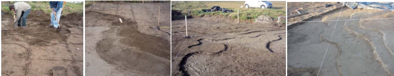
Figura 233. Registro fotográfico construcción modelo en terreno. Las imágenes muestran el trazado y modelamiento de la batimetría del suelo marino de Concón
