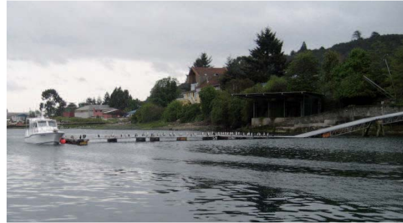
Figura 165. Muelle Oxxean Puerto Montt. Registro fotográfico del autor.
