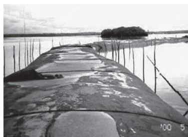
Fig 270. Geotubos rellenos de arena de 3.5m de ancho
