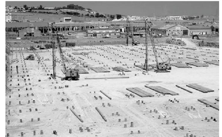
Fig. 145, 146, 147 y 148. Fotografías de lo particular a lo general de perforación, camisa de acero, pilote instalado y estructura existente para inicio de la superestructura y panorámica del predio compactado.
