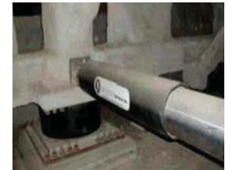
Fig. 158. combinación disipador y amortiguador sísmico de base.
