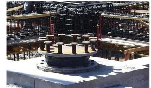
Fig. 151. Amortiguador instalado y listo para recibir la superestructura.
