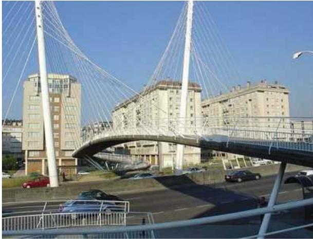
Fig. 97 y 98. Imagen Google, pasarela peatonal sobre autopista, combina estructura soporte convencional en los extremos y cables portantes en la parte central colgante.
