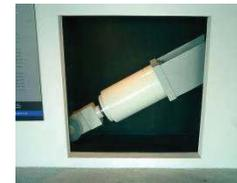
Fig. 93, 94, 95. Estructura metálica conforma el edificio, a la que se suman triangulaciones metálicas con amertiguadores hidráulicos en los extremos.
