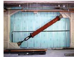
Fig. 157. Amortiguador hidráulico telescópico.
