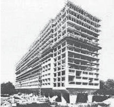
Fig. 87. Se construye sobre pilotes, elevando el edificio sobre el terreno, logrando una rasante libre y transparente al aproximarse.
