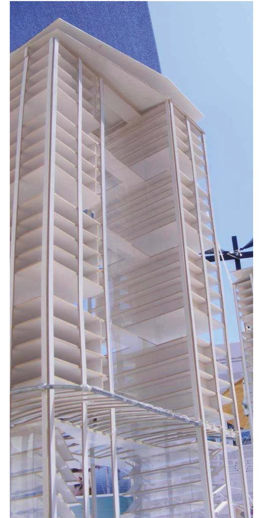
Fig. 262. Maq. esc. 1:200, edificio pórtico. Es posible distinguir, el núcleo ciudadano en la parte baja y los 4 niveles habitacionales, vinculados por las plazas elevadas.
