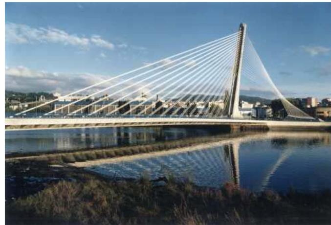
Fig. 100. Imagen google, pasarela peatonal oval. Atirantada desde dos pilares portantes anclados a suelo y vinculados a estructura de hormigón central.
