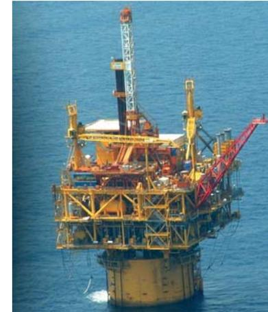
Imagen 152. Platadorma “devil’s tower” en el golfo de México, es un tipo de plataforma Spar.
