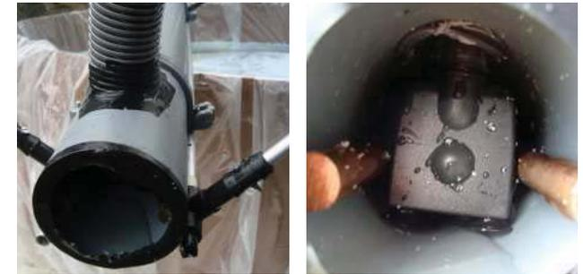
Imagen 210. Instalación de la bomba y los pesos al interior del PVC y manguera de conexión eléctrica y de mangueras.
