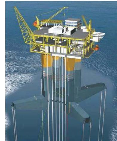
Imagen 153. Modelo 3D de una plataforma Tension-leg.
