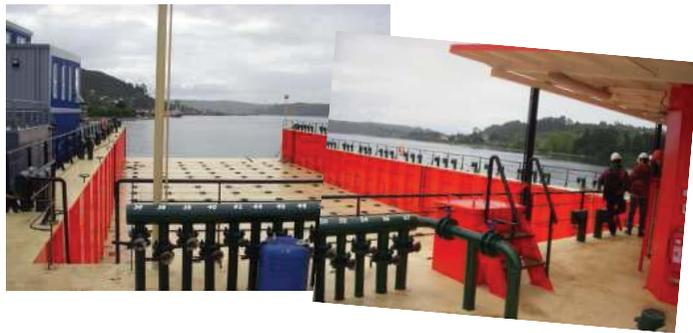
Imagen 163. Válvulas de control de acceso de agua a los compartimientos de lastre.
