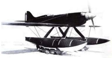
Imagen 173. hidroavión italiano que consiguió una velocidad de 709 km/h en 1934, tiene doble hélice de rotación contraria y un motor de 24 cilindros.
