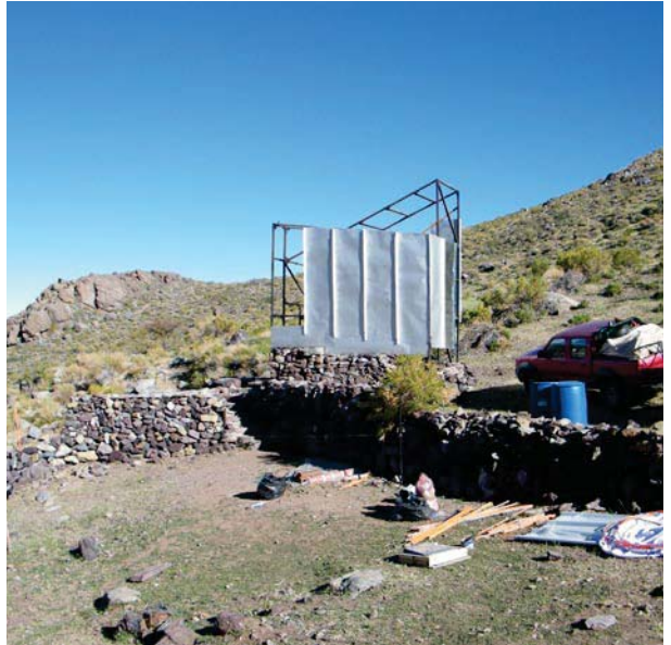
Estado de la obra el día de llegada. Sobresale por el brillo del sol en las latas.
