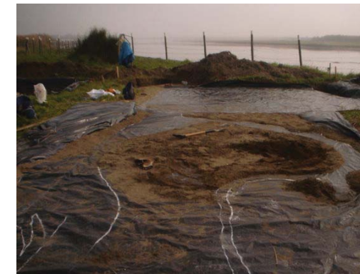
Se traza con tiza el plano sobre el cual se trabajará. Fotos de registro de faenas.
