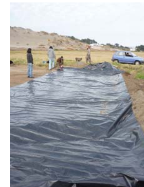
Se impermeabiliza todo el lugar de trabajo con polietileno negro sellado con cinta de embalaje. Fotos de registro de faenas.
