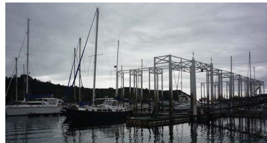
Fotos de la marina construida por medio de muelles flotantes.
