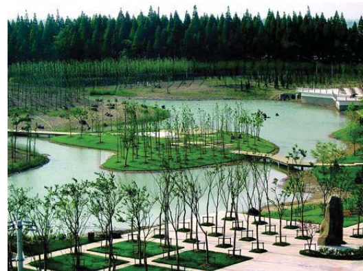
Humedal artificial que se encarga de limpiar las aguas .
