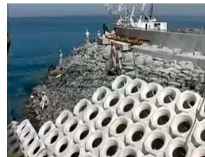
Protección con cubos huecos en la construcción del rompeolas del edificio Burj Al Arab en Dubai. http://www.youtube.com/watch?v=Oyn4Iefr8PE&feature=related
