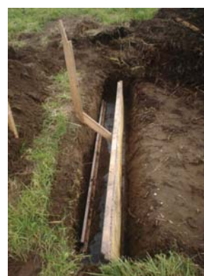
Excavación en los extremos del modelo para ubicar las paletas generadoras de oleajes, son dos excavaciones de 50 cms de profundidad. Fotos de registro de faenas.
