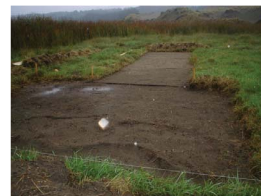
Pendiente compactada y terminada. Fotos de registro de faenas.
