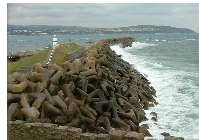
Protección para la bahía Douglas, http://www.manxscenes.com/01&2/nov%2002/princess%20alexander%20pier.htm
