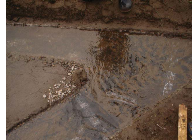
Se abre la compuerta para dejar evacuar el agua.
