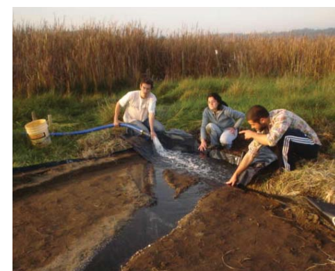
Se construye una piscina de desborde. Fotos de registro de faenas.
