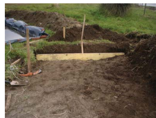
Excavación en los extremos del modelo para ubicar las paletas generadoras de oleajes, son dos excavaciones de 50 cms de profundidad. Fotos de registro de faenas.
