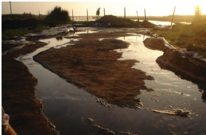
A la derecha de la foto se puede ver como las inundaciones llegan hasta la cota 10 de la línea del tren.
