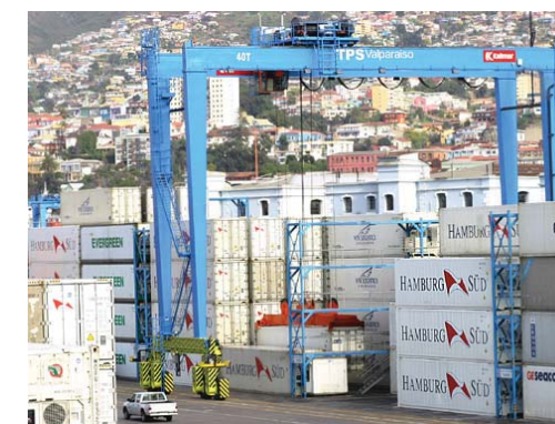
Grúa RTG en el puerto de Valparaíso, https://www.tps.cl/prontus_tps/site/artic/20051003/pags/20051003125041.html
