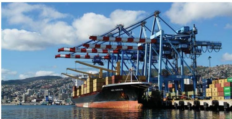
Infraestructura portuaria ,Puerto de Valparaíso, año 2009.
