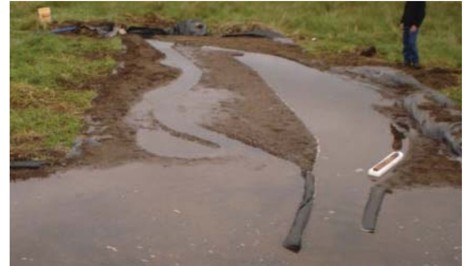
Luego de abrir la compuerta se puede apreciar como bajan las inundaciones de la ribera del canal norte.
