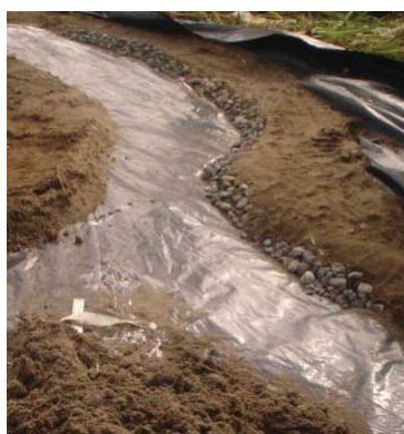
Sobre el polietileno se comienza a modelar con arena, los bordes se contienen con piedras sin perder la proporción con la realidad, además se agregan elementos como puentes que ayudan a mantener la escala en los videos. Fotos de registro de faenas.
