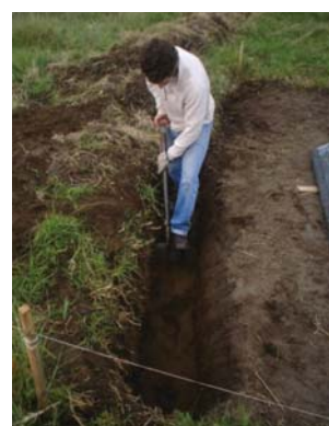
Excavación en los extremos del modelo para ubicar las paletas generadoras de oleajes, son dos excavaciones de 50 cms de profundidad. Fotos de registro de faenas.
