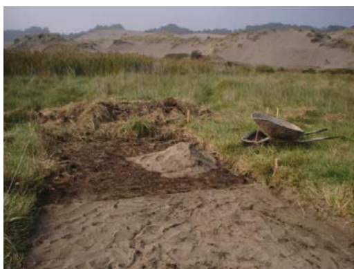
Relleno con arena para lograr la pendiente de la caja del río de 0.1^\circ . Fotos de registro de faenas.
