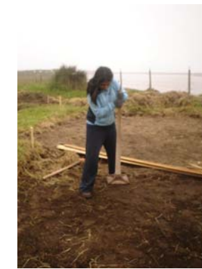
Nivelación del terreno con nivel de agua, compactación del terreno mediante el compactador manual. Fotos de registro de faenas.
