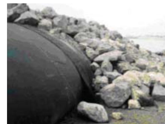
Usos de los geotubos, en la primera imagen se utilizaron para la construcción de una isla en la que se ubica una planta de reciclaje de aguas, además se pueden recubrir con rocas para su protección, http://my.opera.com/giapnhu84/blog/ung
