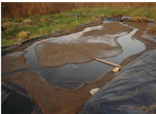
Situación actual de la desembocadura, antes y después del llenado. se pueden apreciar elementos como los puentes y la pequeña desembocadura que actualmente tiene .
