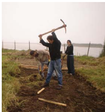
Extracción de pastelones mediante picota y azadón. Fotos de registro de faenas.
