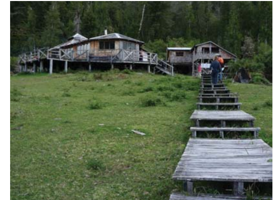
Loft de restauro en Vodudahue.
