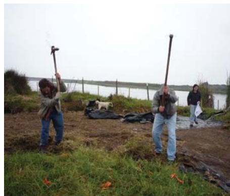
Extracción de pastelones mediante picota y azadón. Fotos de registro de faenas.
