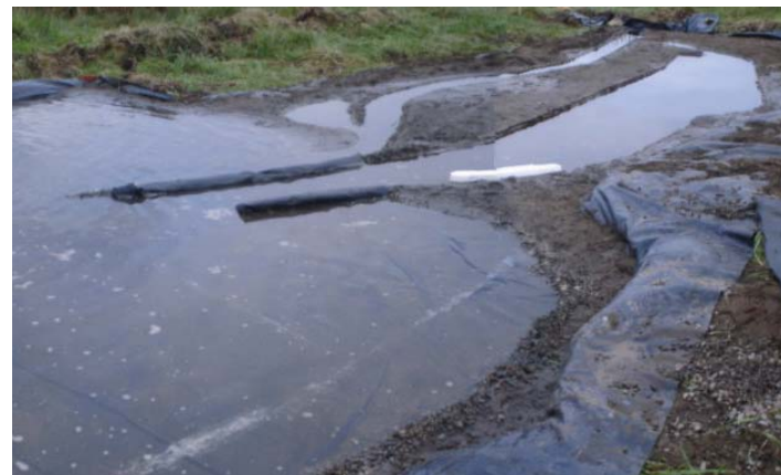
Pruebas del Oleaje sur-oeste, se logra de manera efectiva un agua calma al interior del canal portuario.
