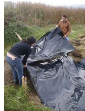
Se impermeabiliza todo el lugar de trabajo con polietileno negro sellado con cinta de embalaje. Fotos de registro de faenas.
