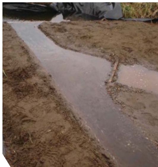
Compuerta separadora de los canales de agua.
