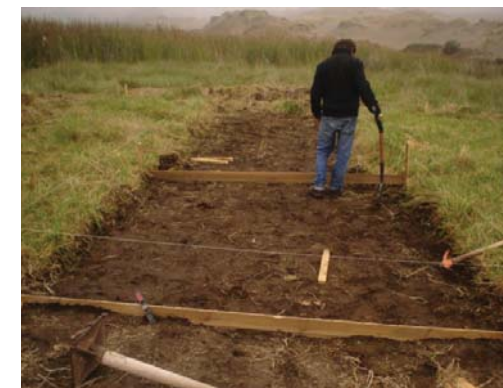
Nivelación del terreno con nivel de agua, compactación del terreno mediante el compactador manual. Fotos de registro de faenas.
