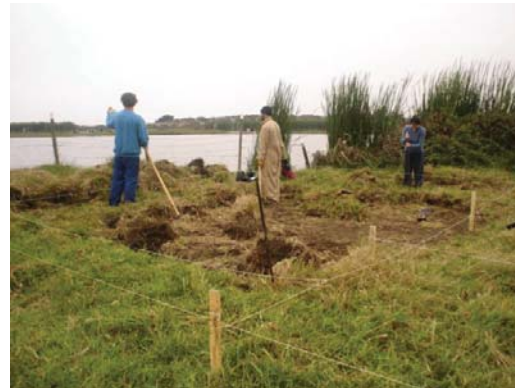
Trazado inicial, en las fotos se puede ver la cercanía a las dunas y al estero, de los cuales se extrae material para la realización del modelo y las pruebas. Fotos de registro de faenas.
