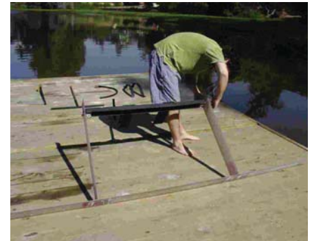
Apriete perfil _I_I_ a estructura
