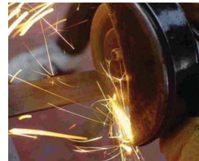
Corte de las vigas
