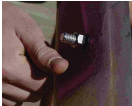
Apriete perfil _I_I_ a estructura
