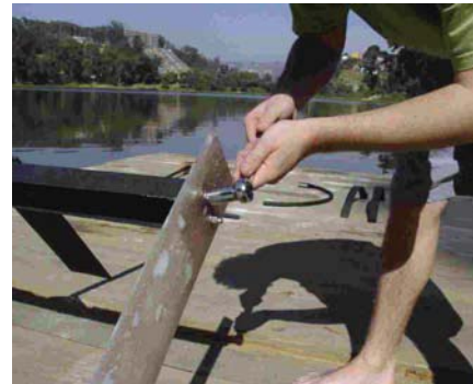
Apriete perfil _I_I_ a estructura
