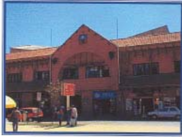
Foto N° 9: El Edificio Consistorial se encuentra frente a la Plaza de Armas de Quillota. Fue remodelado en estilo colonial, recordando así la condición de la más antigua ciudad española, como se le denomina en la época de la conquista.
