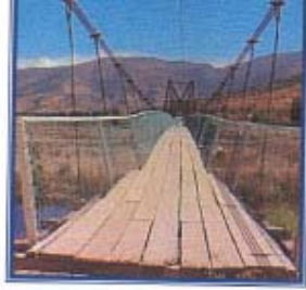
Foto N° 16: Puente Colgante Lo Rojas , el cual cruza las riberas del río Aconcagua. Se encuentra ubicado en la comuna de La Cruz, a la altura del Paradero 16 y es de uso peatonal. Se presenta como un llamativo atractivo para los turistas que visitan el área, los que se encantan con lo pintoresco del lugar.
