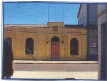
Foto N° 8: En los alrededores de la Plaza de Armas se encuentran interesantes construcciones que recuerdan el pasado colonial de la comuna, las que configuran el Centro Fundacional.
