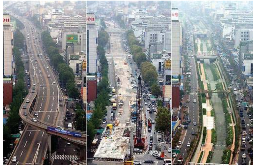
Vista de la rehabilitación de área verde
