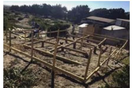
Proceso constructivo de la construcción del cerco de niveletas, hincado de pilotes y fijación de vigas principales.
