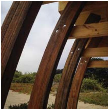
Las costillas se fijan con tirafondos a las vigas que descargan los esfuerzos sobre los pies derechos de 2x5" cepillado.
