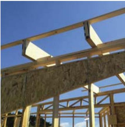
Se levantan las vigas y se fijan provisoriamente por arriba.
