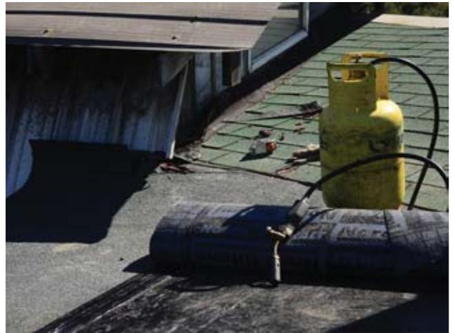
Faena de fijación de la membrana asfáltica.
