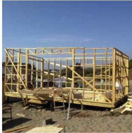
Término del levantamiento de tabiques y comienzo de la creación de los vanos y estructura saliente de la cama.
