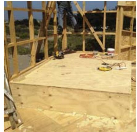
Forro de la estructura de la cama para darle terminación y arriostrar a la estructura saliente.
