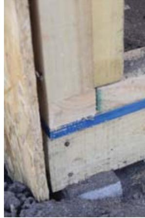
Detalle de unión tabique, viga y apoyo.
