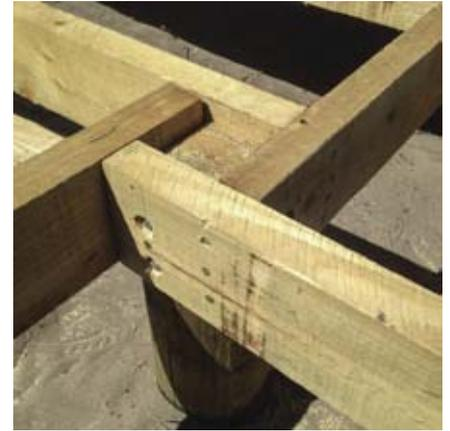
Encuentro de las vigas en pilares interiores, sistema de descalce que arriostra la estructura.
