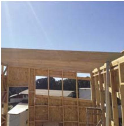
Vista de las vigas y su variación de altura en base a la inclinación que conforma la cubierta paraboloides.
