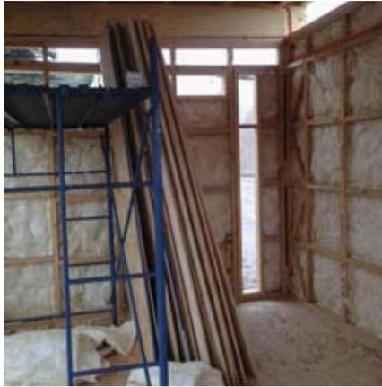
Con el forro exterior se coloca lana de vidrio en los muros para poder forrar hacia el interior.
