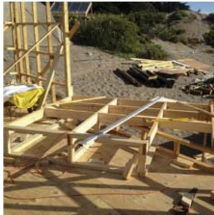
Estructura de la cama armada in situ sobre tabique levantado.
