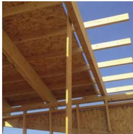
Faena de instalación de costaneras y planchas OSB de la cubierta.
