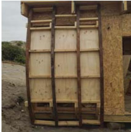
Caneo entre las costillas para evitar el movimiento en dirección horizontal y para poder atornillar la terminación interior.
