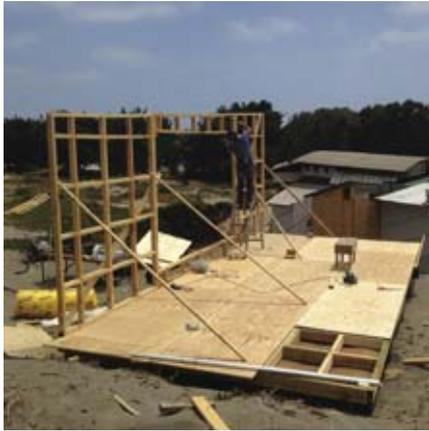
Levantamiento y ensamble completo del primer tabique que fue construido en cuatro piezas: dos tabiques laterales, dintel y alféizar.
