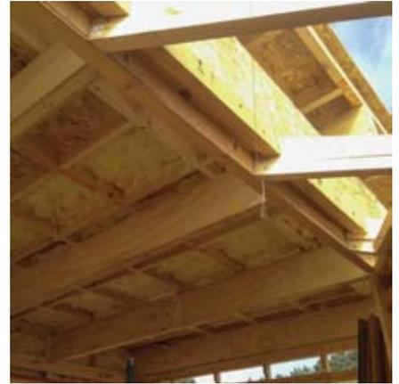
Se canea entre las costaneras para poner el aislante y posteriormente las planchas del cielo.
