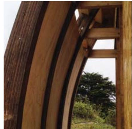
Aparición del vacío generado por las costillas que se utilizará para instalar un colgador de ropa para el closet.
