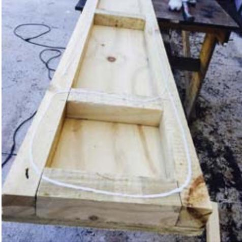
Encolado para unificar la estructura de las vigas de cajón.
