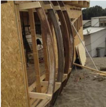
Aparición de la curva en la fachada con la instalación de las costillas.
