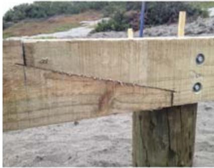
Ensamble del encuentro entre dos vigas perimetrales del tablero de piso.
