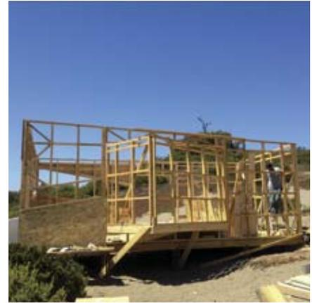
Se consolida la estructura de la cama, se apuntala a los pilares y se levantan los tabiques faltantes.
