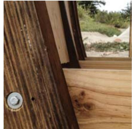
Detalle de la fijación con tirafondo y la sucesión de costillas con el forro interior.
