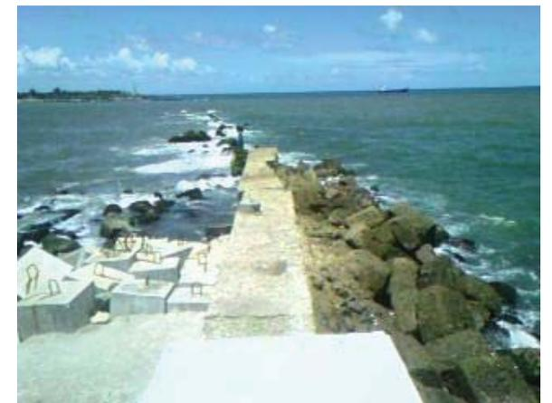
Fig.109: Ejemplo de enrocado que se pretende utilizar con el fin de reforzar la estructura del muelle peatonal.
