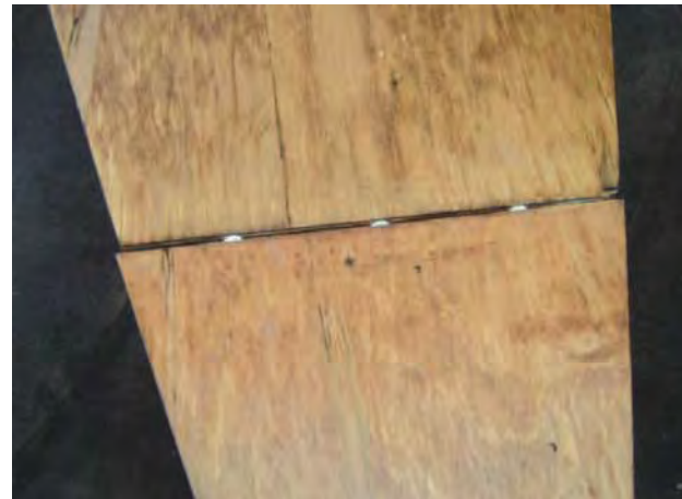
139-141. Forma de anexas la pieza punta de los paneles base (solución constructiva para alcanzar la altura propuesta).
