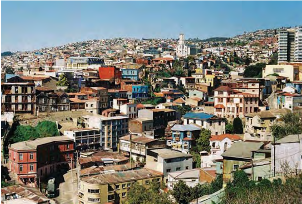
9. Vista panorámica de los cerros de Valparaíso, coronada por la torre de la Iglesia de Nstra. Sra. del Carmen.
