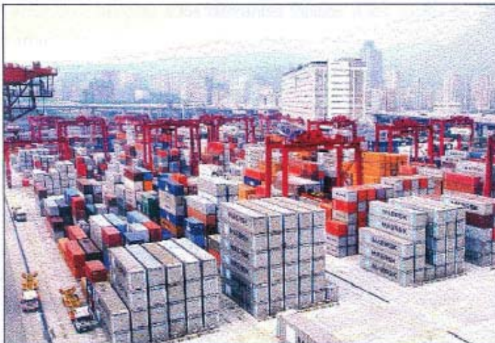
Paso 4: acopio automático del contenedor por las Grúas transtrainer del patio de acopio.
