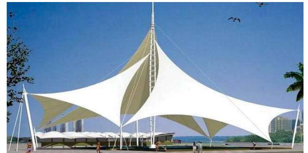
*Las estructuras de Frei Otto toman los principios físicos por los que se rige la estructura de la burbuja, distribuyendo uniformemente las tensiones a través de elementos elásticos*
