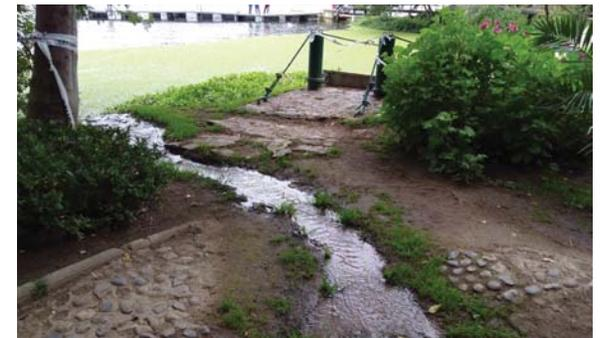
Deterioro e irregularidad en el estado de los suelos y en el direccionamiento de los cursos de desagüe a la laguna.
