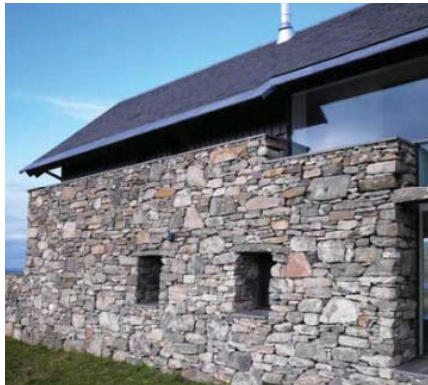
Hay un margen entre la ruina y el techo como si estuviera suspendido, valorando la estructura de piedra. Se construye dentro del espesor del muro.
