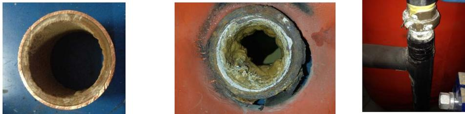
Fig. 2.1: Ejemplo de incrustaciones calcáreas en componentes sala de calderas.
