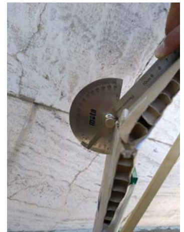
Posicionamiento de espejos y medición de abertura de la pieza triangular.
