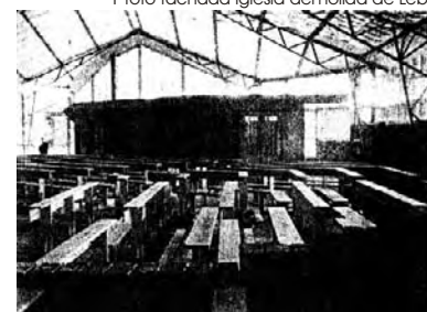
2 foto interior iglesia demolida de Lebu
