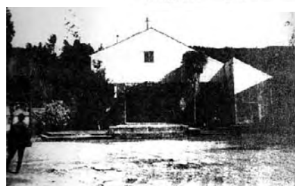
3 foto de la fachada
