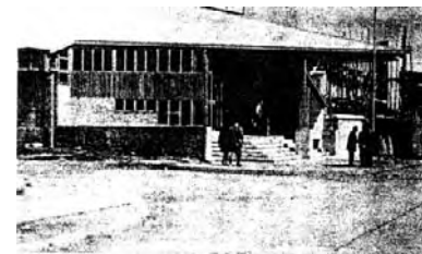
1 foto fachada Iglesia demolida de Lebu
