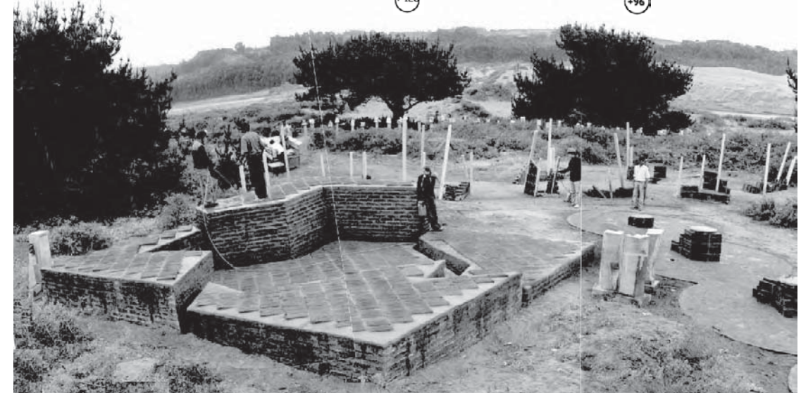
foto obra terminada
