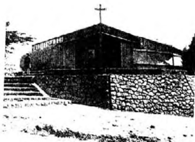
4 foto de la fachada
