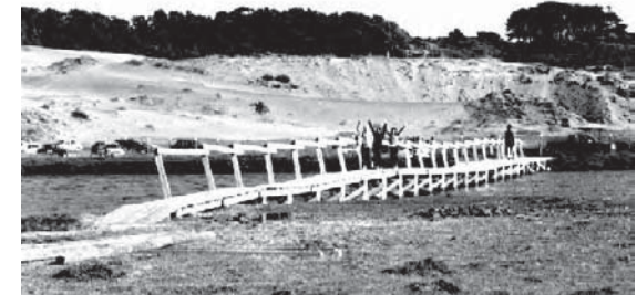
fotos puente terminado
