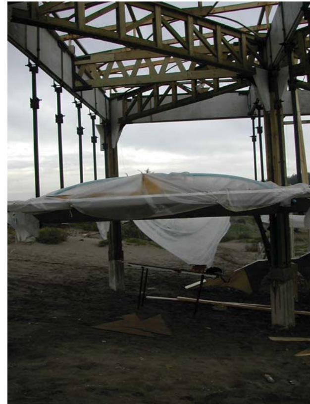
VISTA GENERAL DUNA-PISO MODULAR-TIRANTES Y SISTEMA DE VIGAS
