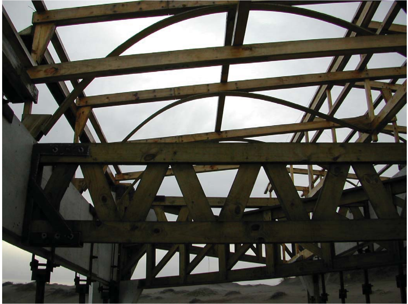
VISTA GENERAL / ESTRUCTURA DE CERCHAS PARA CUBIERTA
