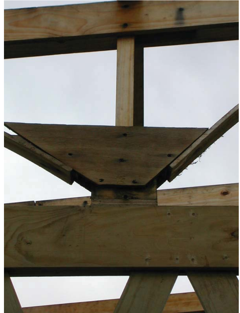
ENCUENTRO / VIGA PERIMETRAL Y VIGAS DE CUBIERTA
