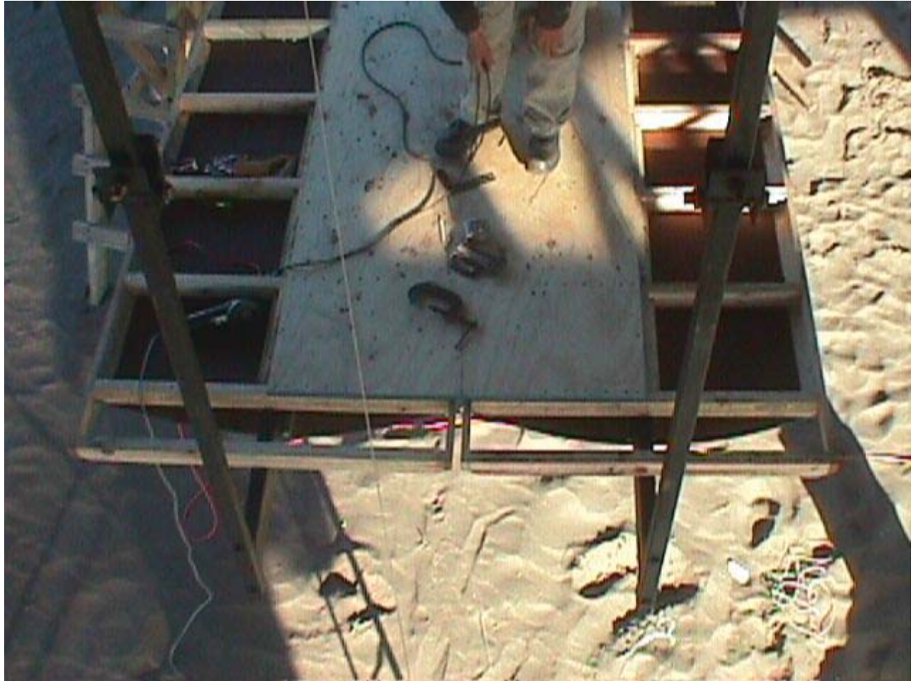
VISTA GENERAL DE MÓDULOS Y TIRANTES
