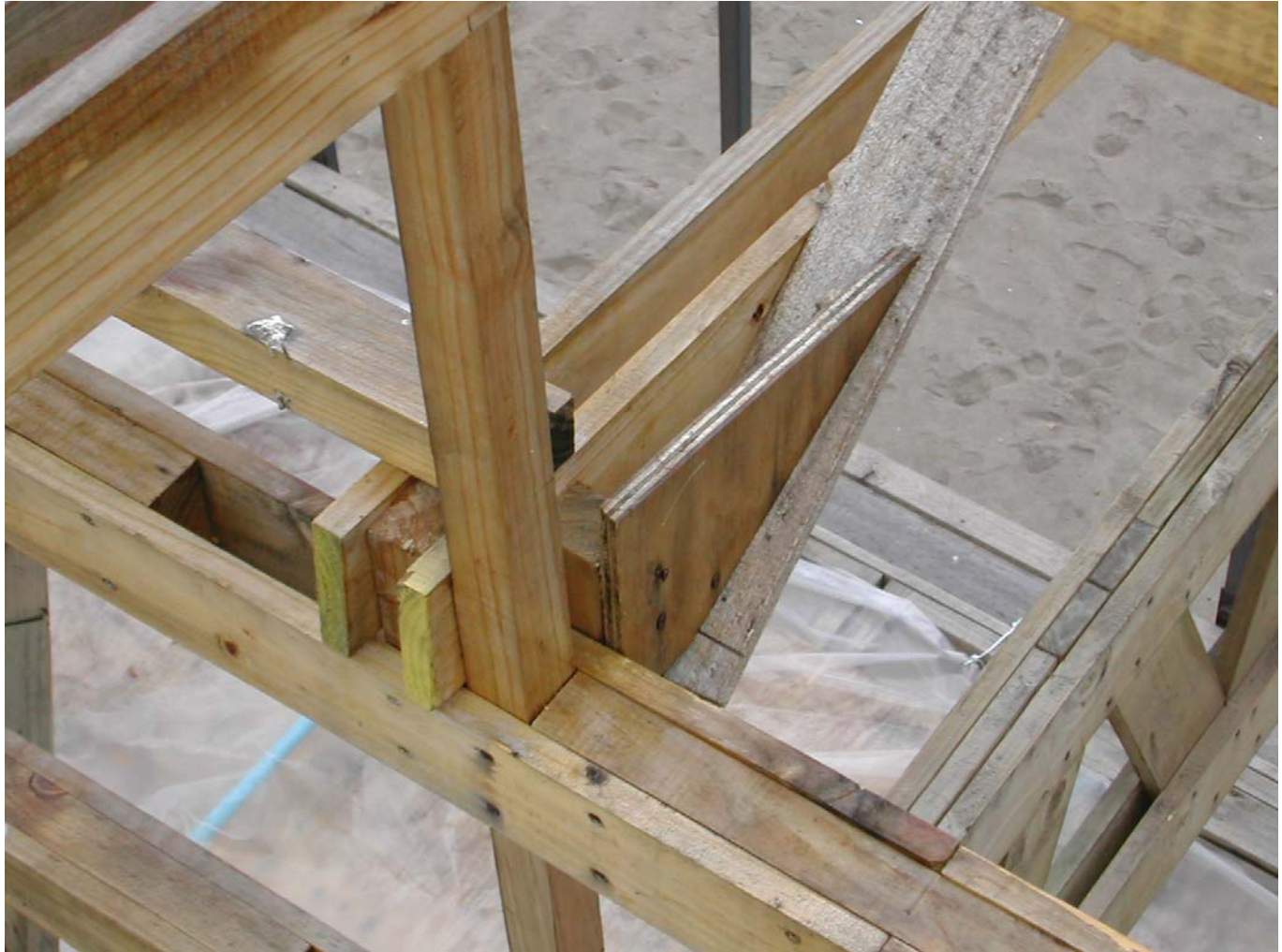
ENCUENTRO / VIGA PERIMETRAL Y VIGAS DE CUBIERT
