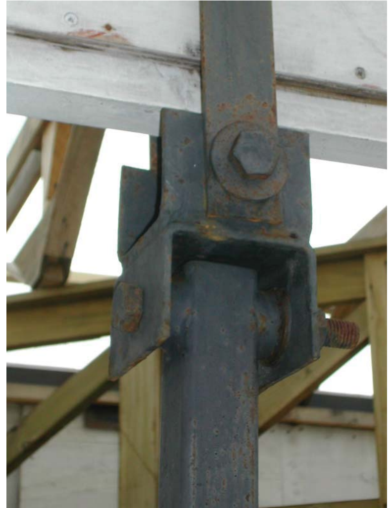
DETALLE ROTULAS O CONECTOR SISTEMA DE TIRANTES
