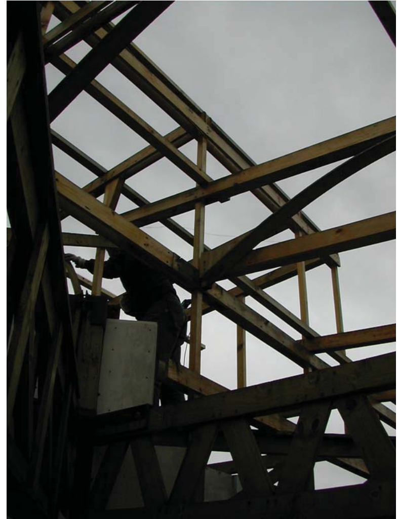
VISTA GENERAL / ESTRUCTURA DE CERCHAS PARA CUBIERTA
