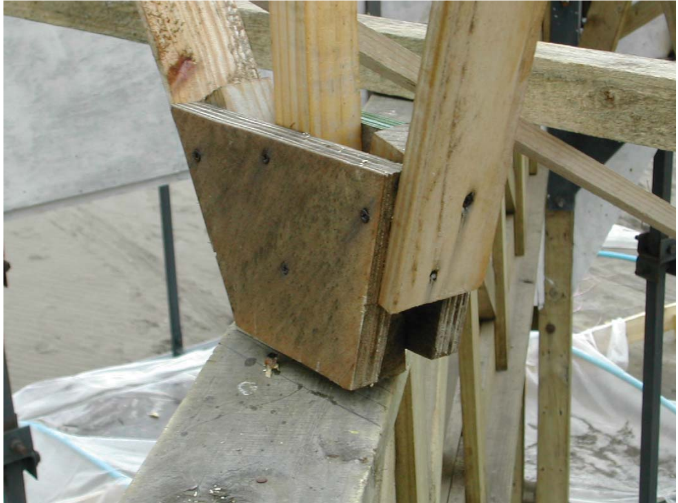
ENCUENTRO / VIGA PERIMETRAL Y VIGAS DE CUBIERTA
