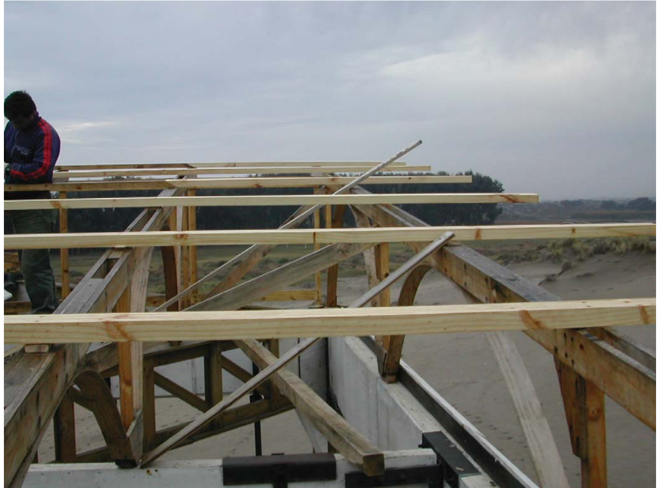
VISTA GENERAL / ESTRUCTURA DE CERCHAS PARA CUBIERTA
