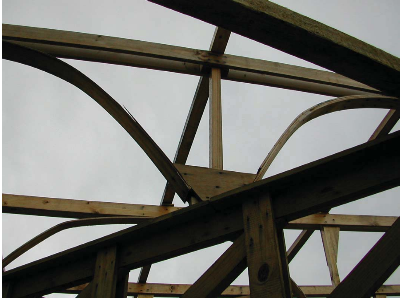
ENCUENTRO / VIGA PERIMETRAL Y VIGAS DE CUBIERTA
