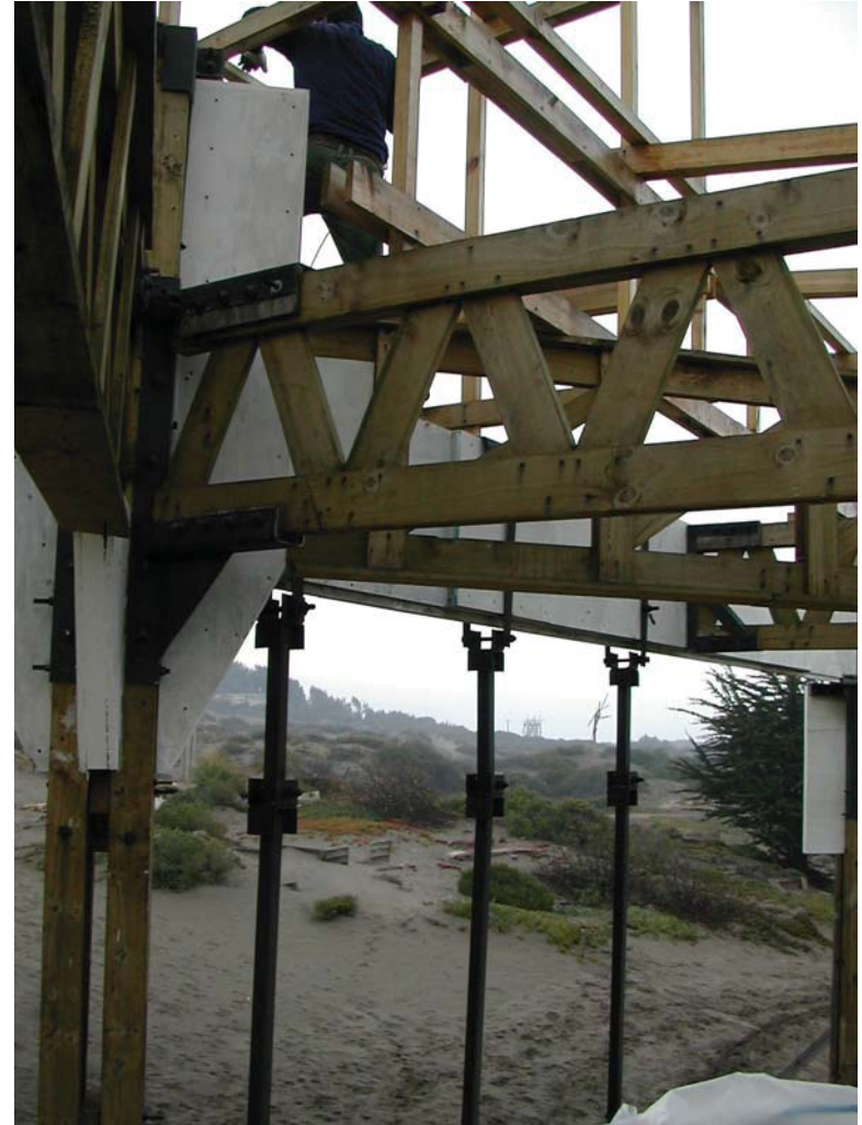
DETALLE TIRANTES Y SISTEMA DE VIGAS
