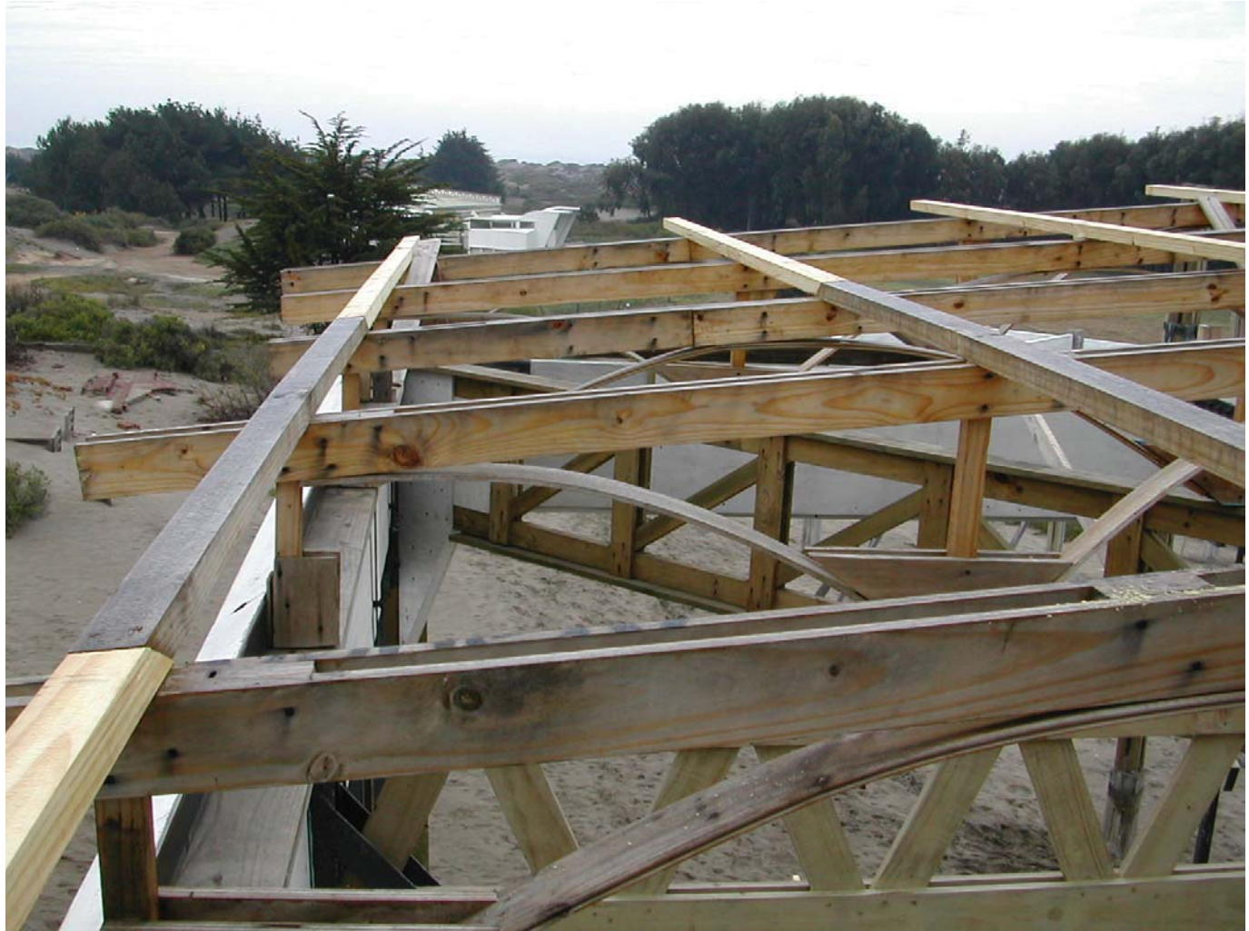
VISTA GENERAL / ESTRUCTURA DE CERCHAS PARA CUBIERTA
