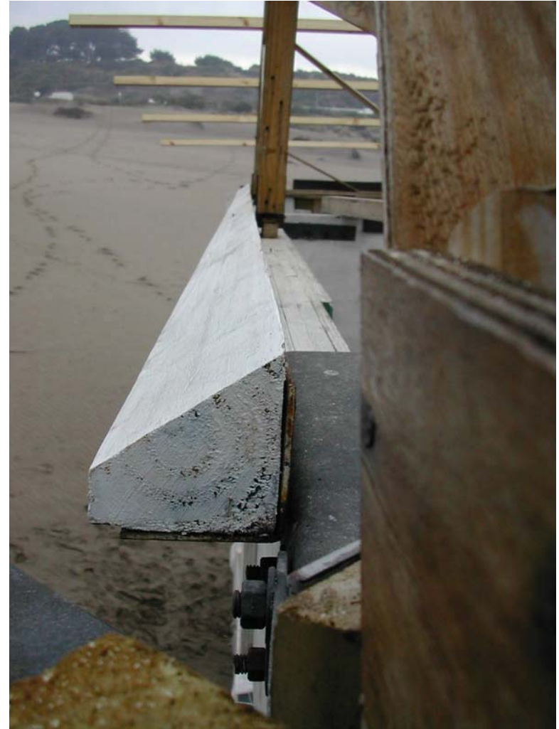
VISTA GENERAL / ESTRUCTURA DE CERCHAS PARA CUBIERTA
