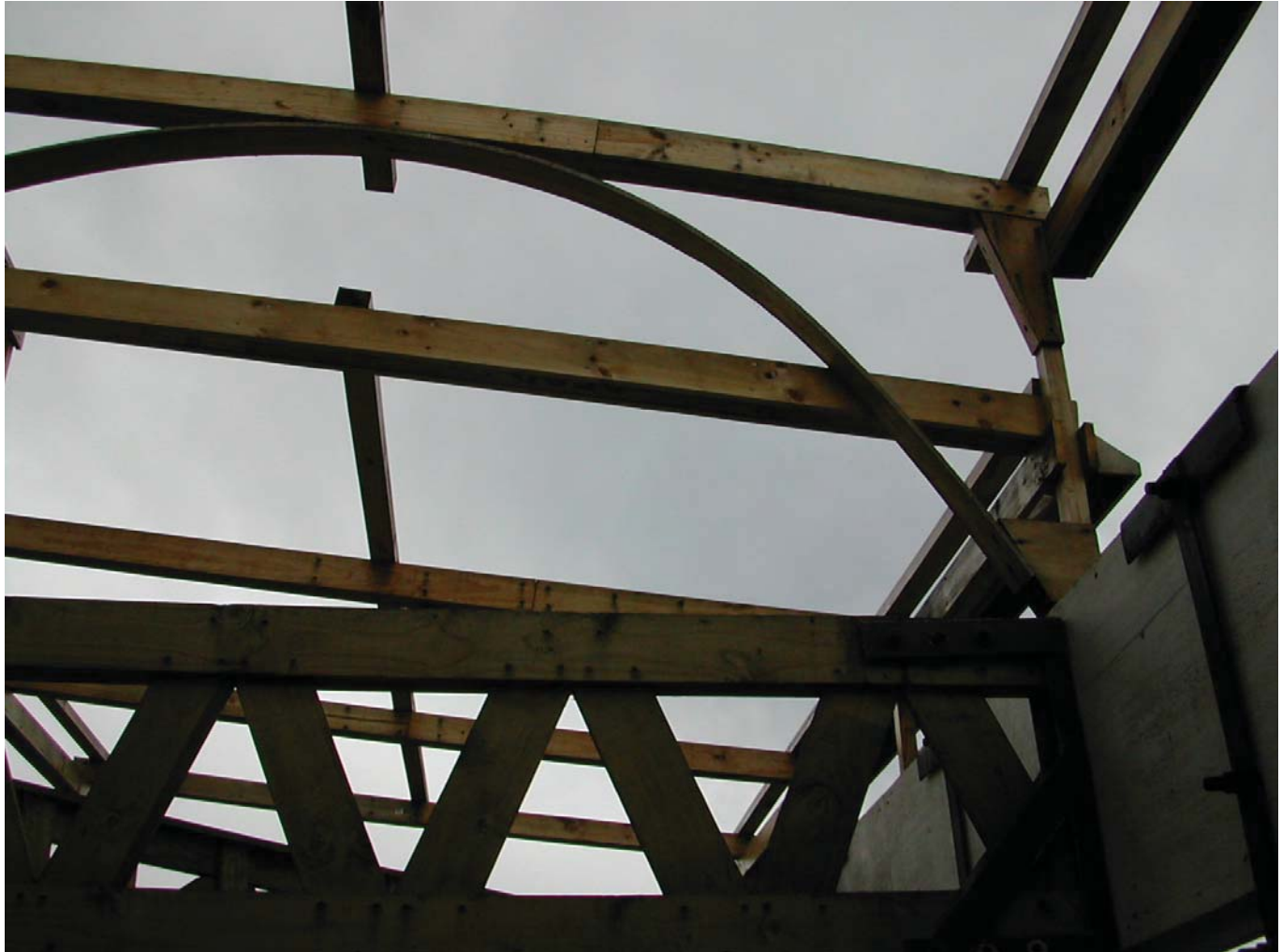
VISTA GENERAL / ESTRUCTURA DE CERCHAS PARA CUBIERTA
