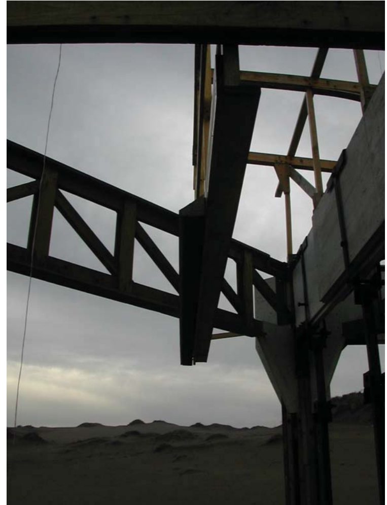
VISTA GENERAL / ESTRUCTURA DE CERCHAS PARA CUBIERTA
