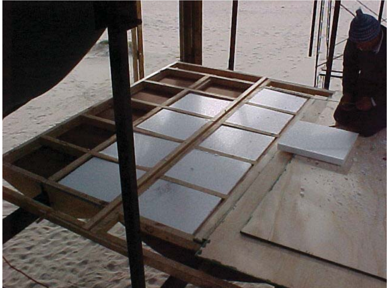
VISTA GENERAL DE MÓDULOS DE PISO
