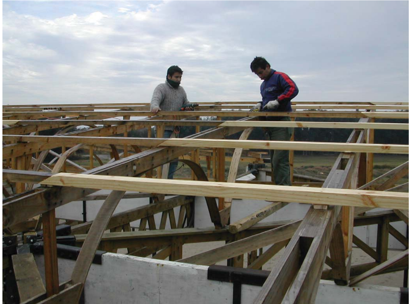
VISTA GENERAL / ESTRUCTURA DE CERCHAS PARA CUBIERTA
