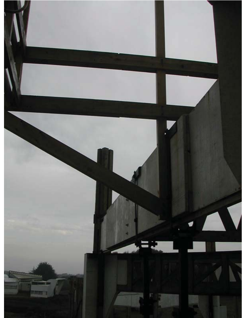
DETALLE ENCUENTRO / PILAR-VIGA CENTRAL Y VIGA PERIMETRAL
