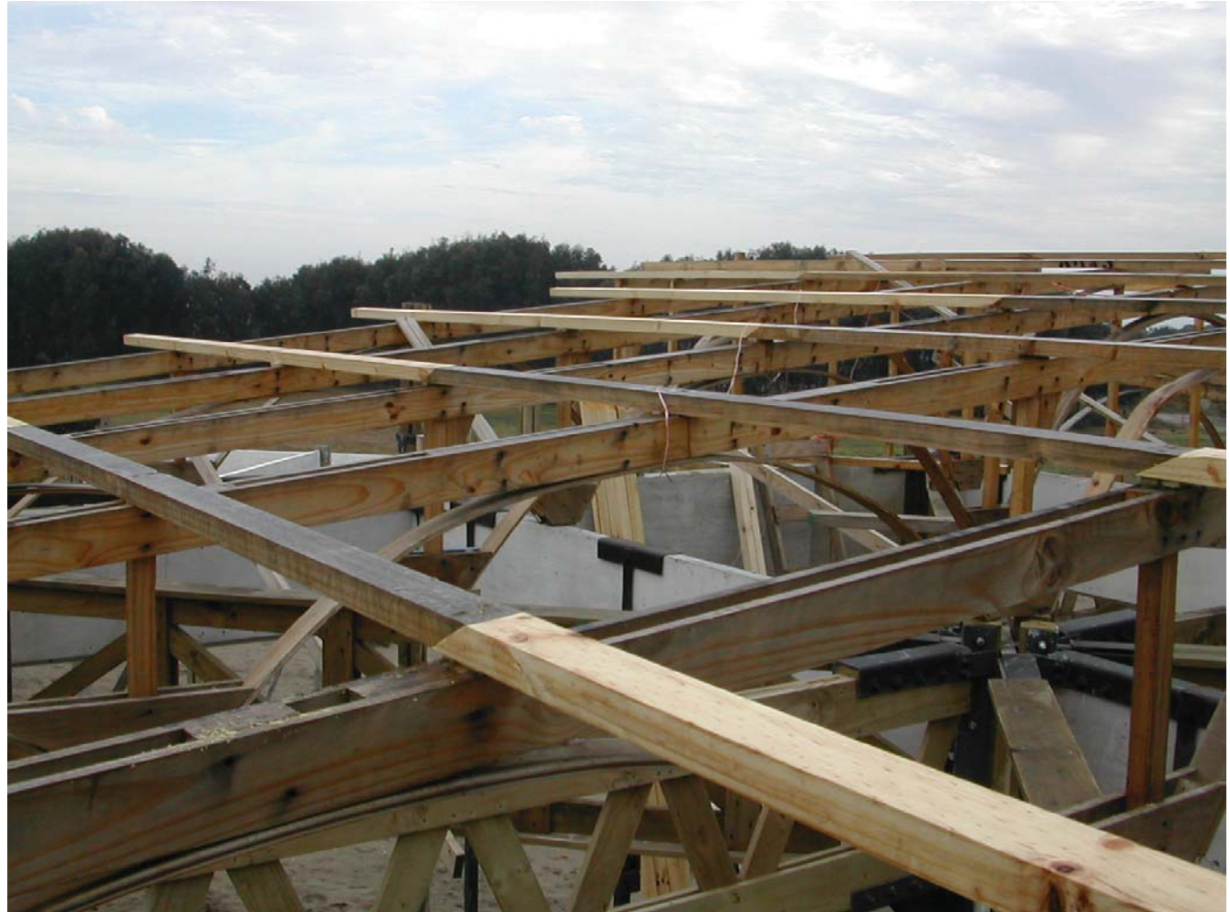
VISTA GENERAL / ESTRUCTURA DE CERCHAS PARA CUBIERTA
