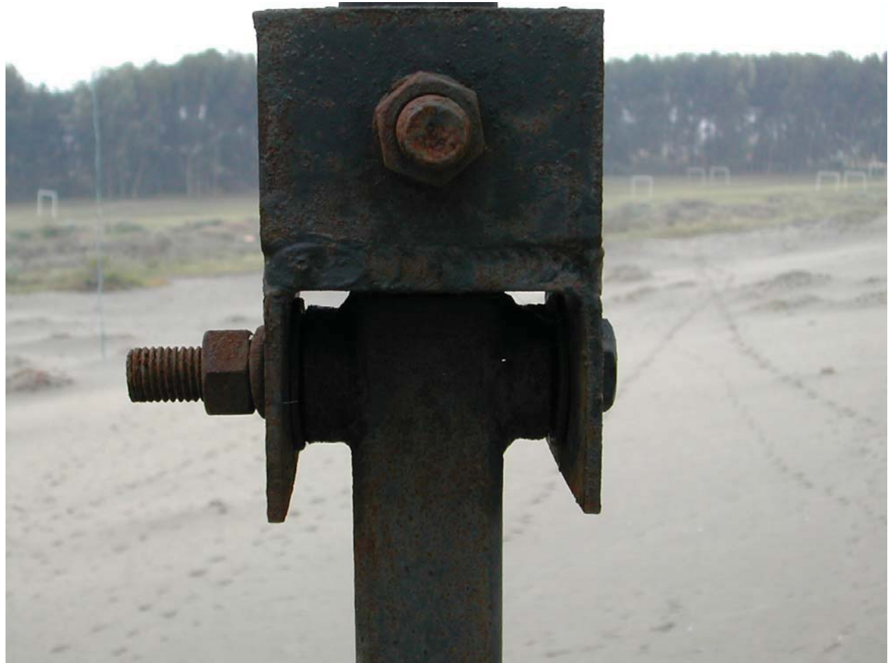
DETALLE ROTULAS O CONECTOR SISTEMA DE TIRANTES
