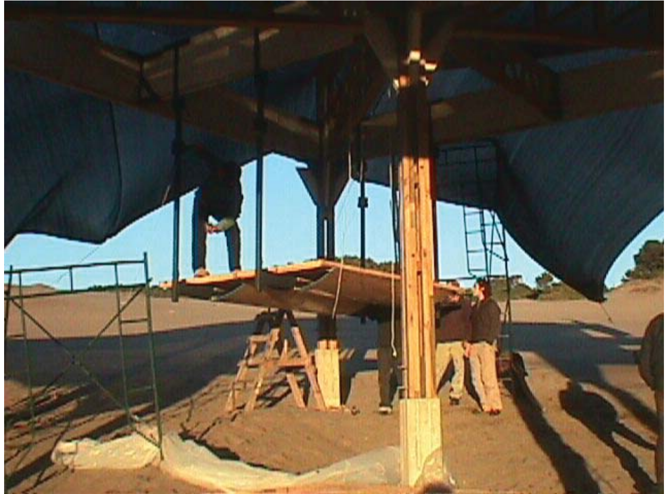
VISTA GENERAL MÓDULOS DE PISO
