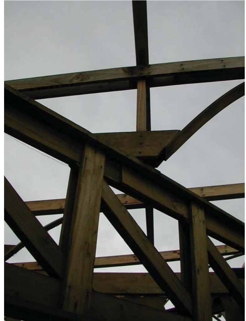
ENCUENTRO / VIGA PERIMETRAL Y VIGAS DE CUBIERT
