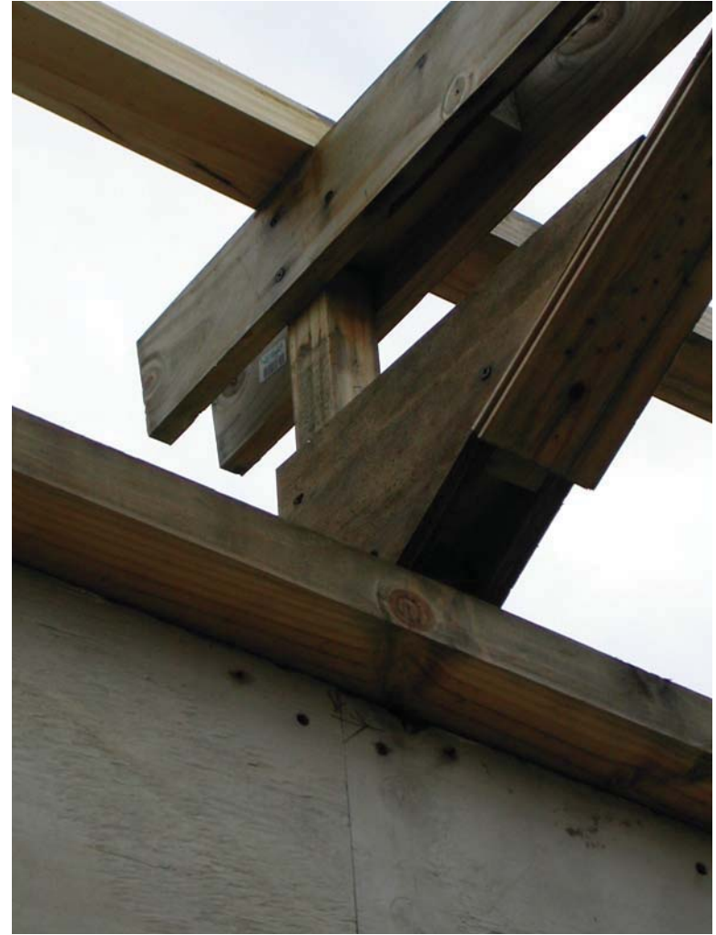
ENCUENTRO / VIGA PERIMETRAL Y VIGAS DE CUBIERTA
