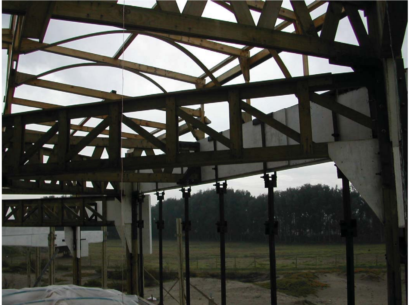
DETALLE TIRANTES Y SISTEMA DE VIGAS
