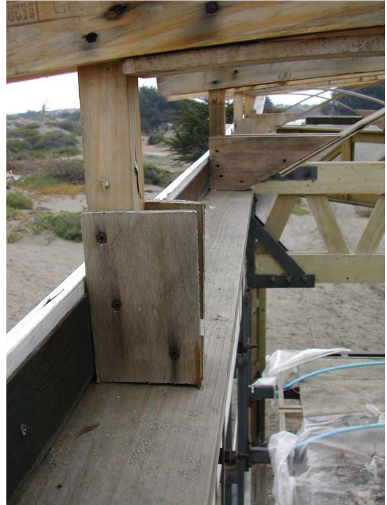
ENCUENTRO / VIGA PERIMETRAL Y VIGAS DE CUBIERTA
