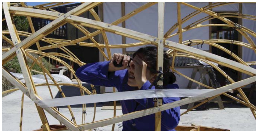
Se propone el avistamiento desde el interior. Se traza con masking tape.
