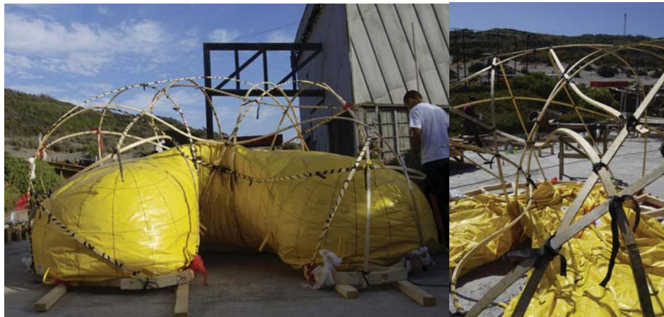
Cada vez que se agrega una tulipa es necesario inflar el globo para que la tulipa de la curvatura de la matriz.
