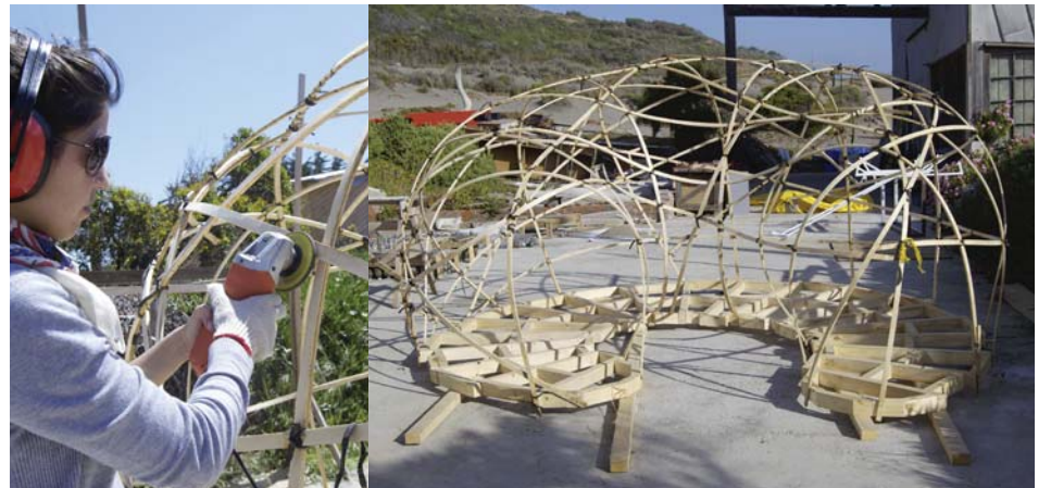
El residuo del caucho y el pegamento se lija con una galleta y lija de disco para madera.
