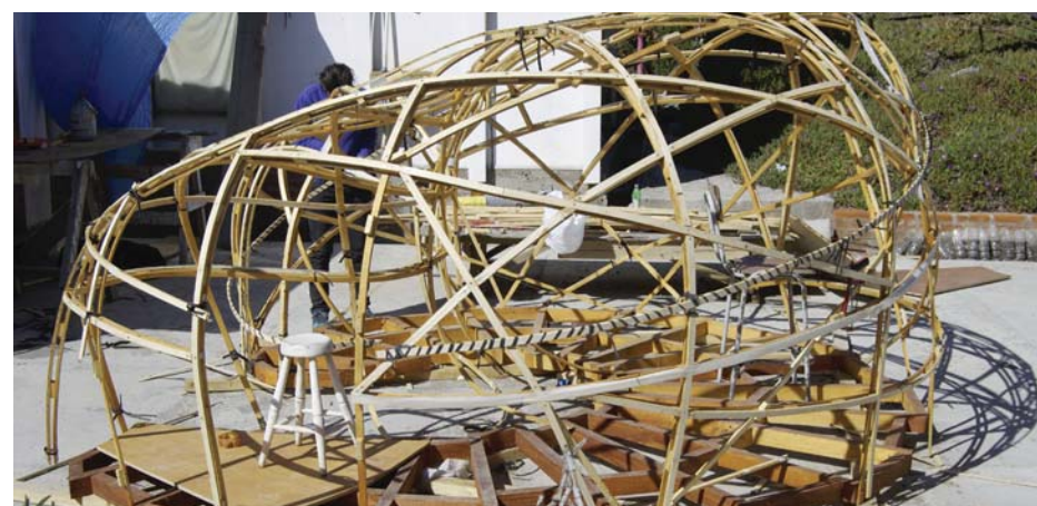
Se agregan las tulipas necesarias para conformar las ventanas.
