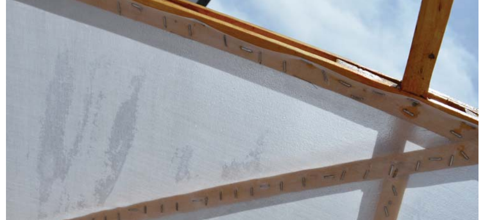
Las grapas puestas en forma perpendicular a la tulipa se fija mejor el paño a la madera ya que tiene el apoyo superficial de la tulipa.
