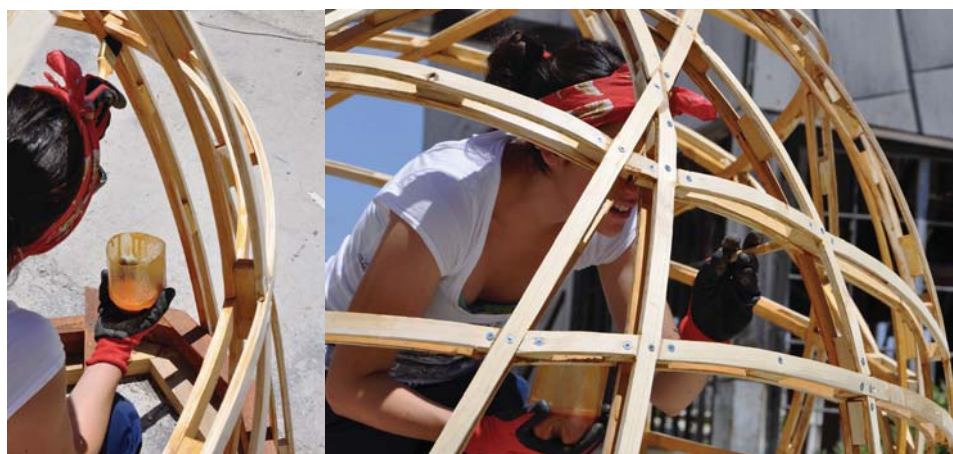
Se barniza por el interior, exterior y entre medio de la viga.
