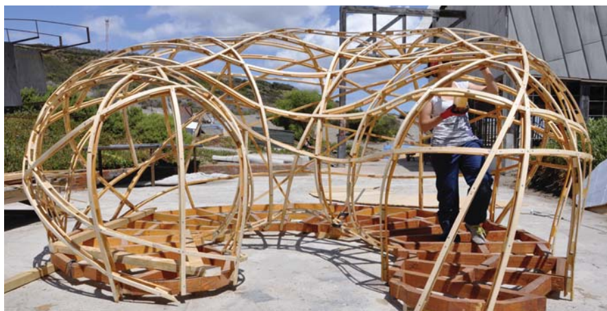
Se revisan los últimos detalles de la estructura; tornillos, taquitos, fijación al piso, etc, antes de barnizar.
