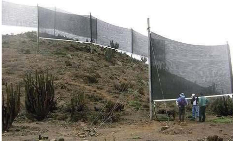
b. El módulo de atrapa-nieblas es generalmente de 12 m de largo por 4 m de ancho, en doble paño, todo el sistema soportado y tensionado con cables al piso
