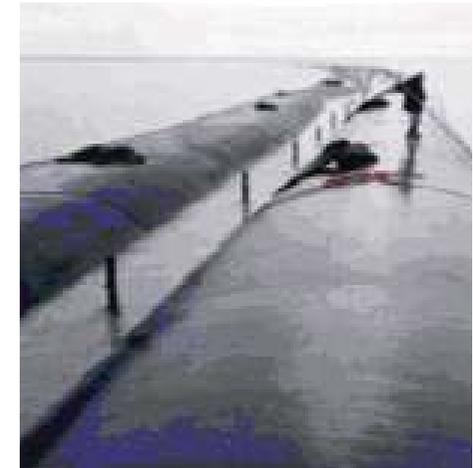
Geotubo, usado para la generación de molos de baja profundidad molo
