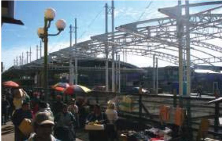
Estructura metálica en base a unidades que se sustentan sobre pilares que sostienen cerchas curvas lo que armara el cielo translucido del mercado.
