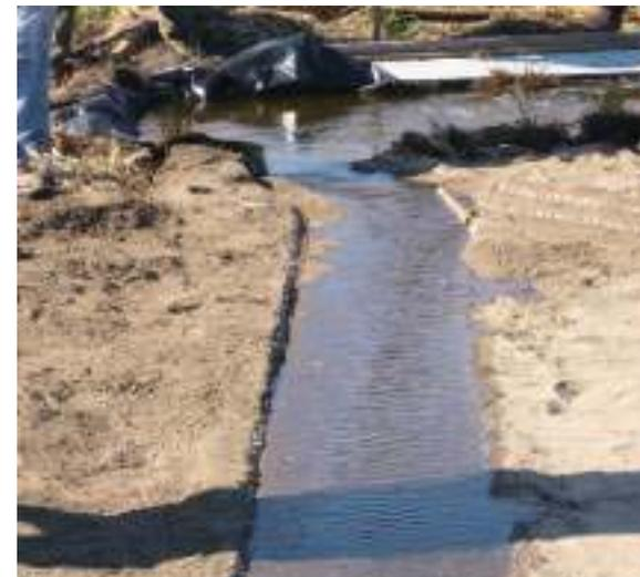
Al abrir las dos compuertas el agua se evacua en paralelo por los dos canales.
