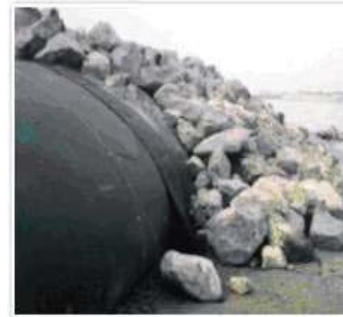
Geotubo ,revestido con enrocado
