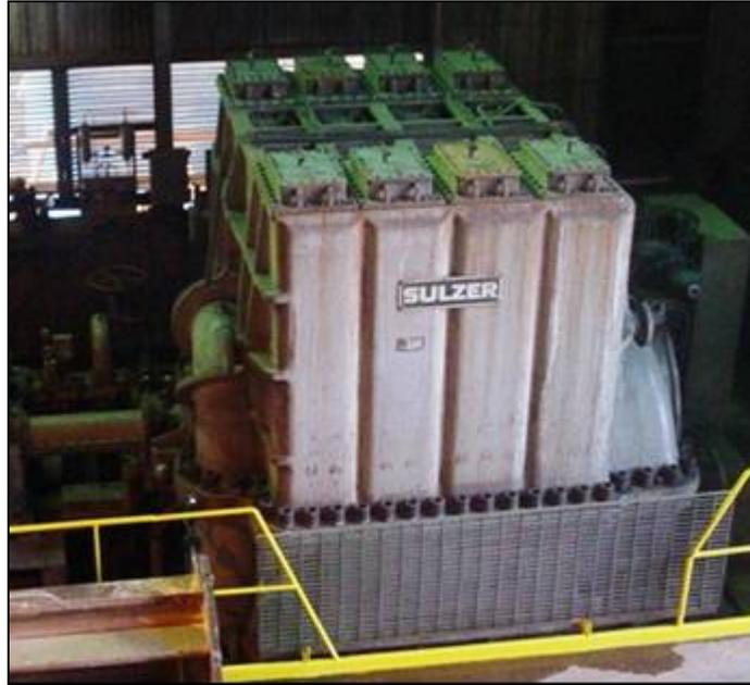
**Figura 2.4** Compresor Sulzer C.01
