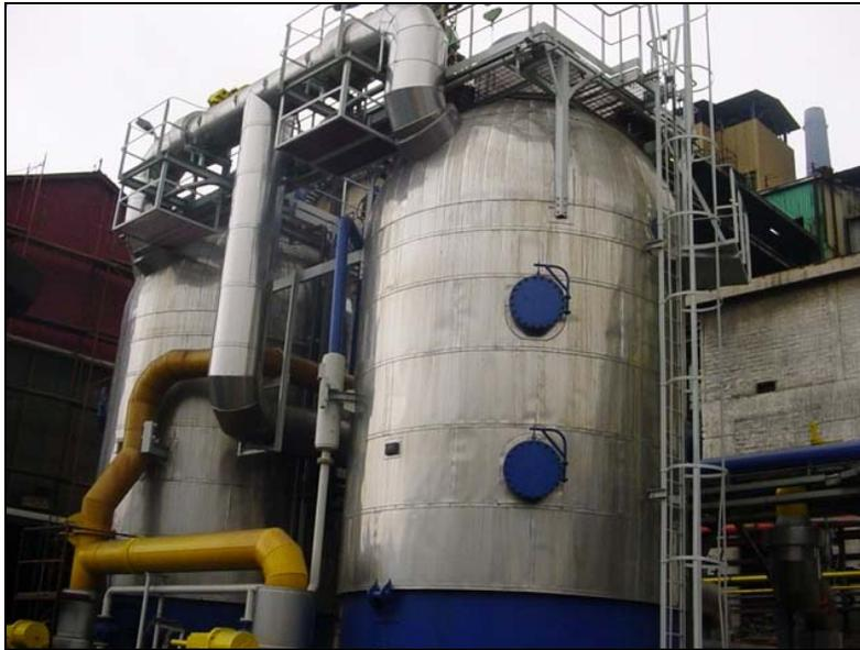
**Figura 2.7** Botellas de Purificación, Planta de Oxígeno N°2
