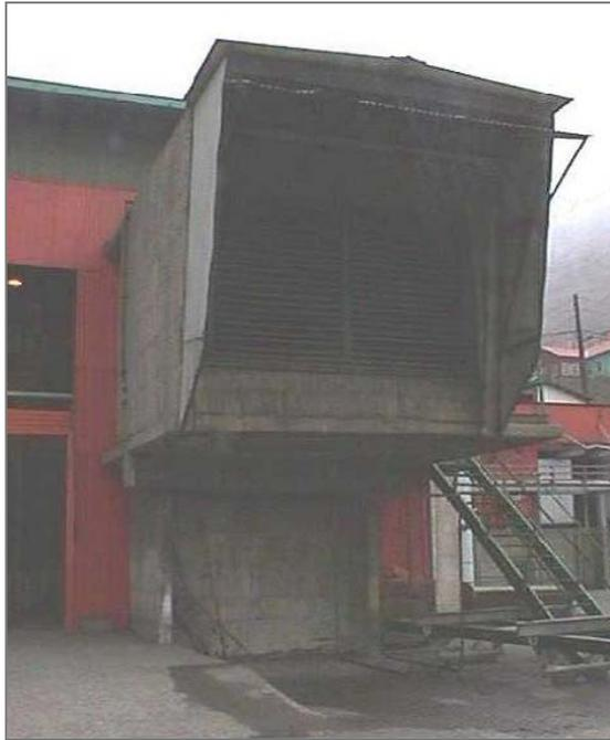
**Figura 2.3** Filtro Entrada Compresor F.01
