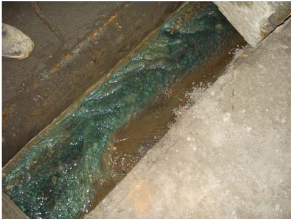
Figura 9: Punto Toma de Muestra Drenaje Nivel de Ventilación Sub-6 (punto 2)
