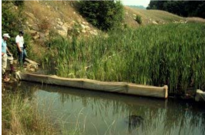
Figura A.6: Humedal anaeróbico
