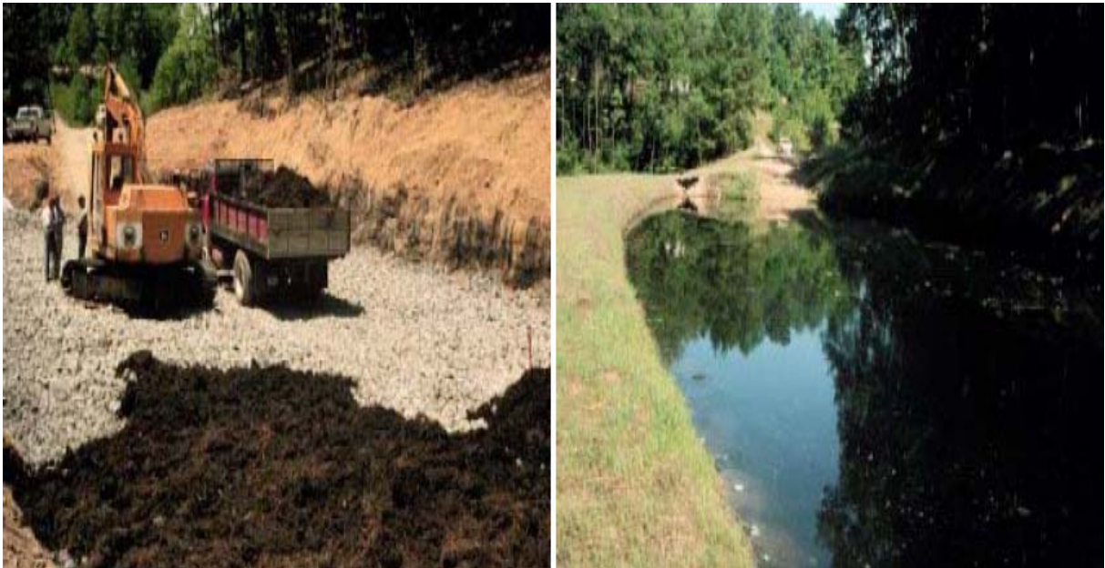
Figura A.17: Construcción de un SAPS
