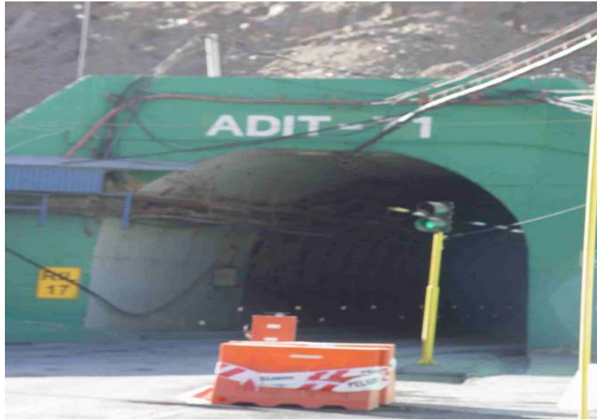
Figura 2: Acceso a la Mina por Adit 71 y Salida del Drenaje
