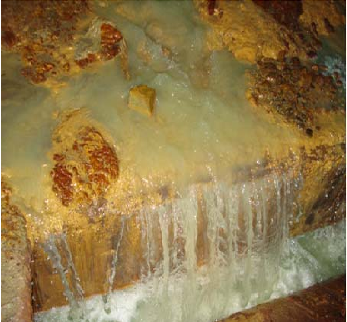
Figura D.4: Fotografía cuneta de Conducción Adit 71
