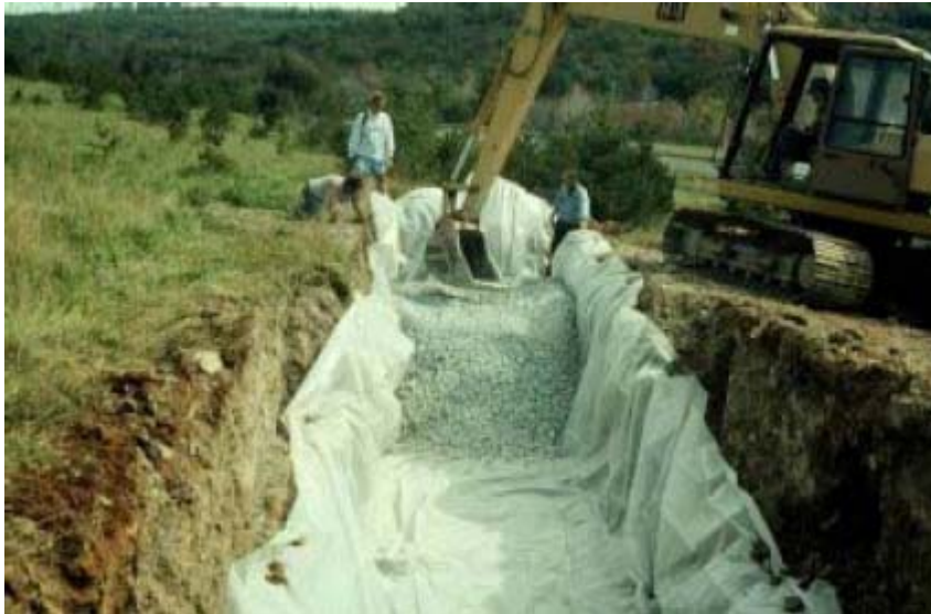
Figura A.9: Construcción de un Drenaje anóxico en Caliza
