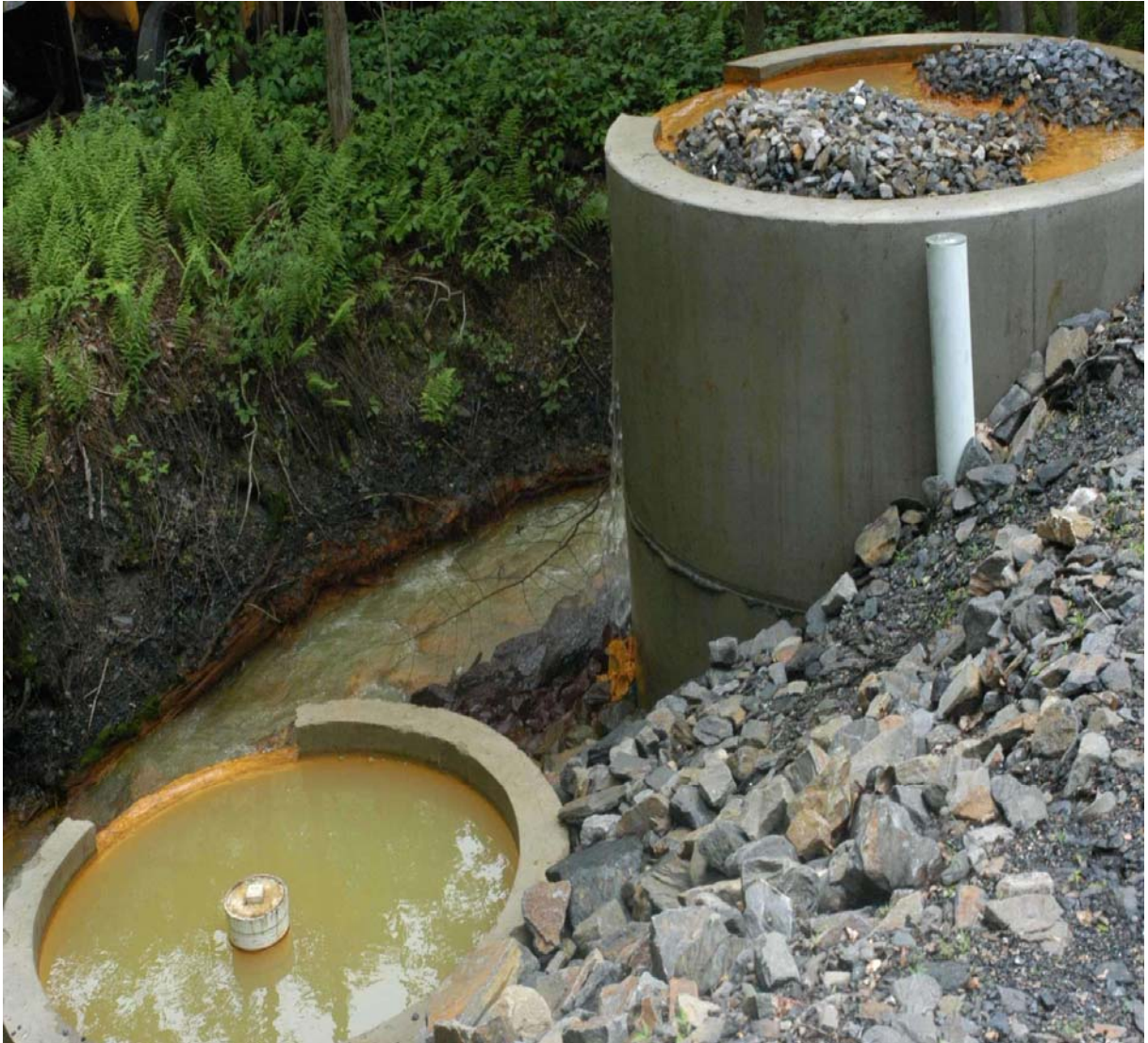
Figura A.15: Vista real de un Pozo bifurcado
