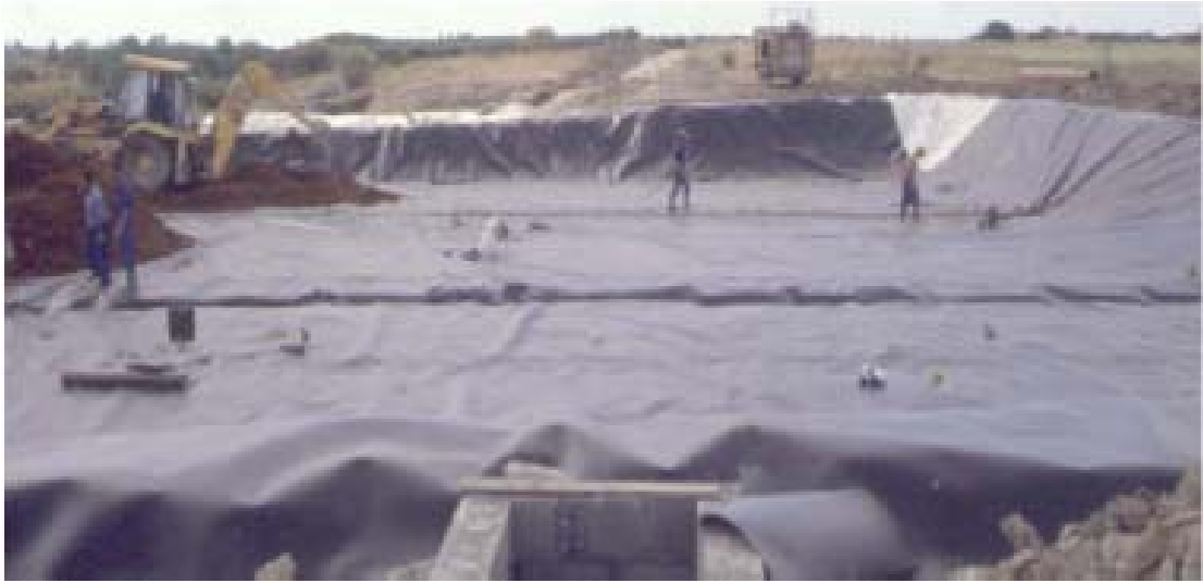
Figura 18: Detalle del Relleno e Impermeabilización de un Humedal
