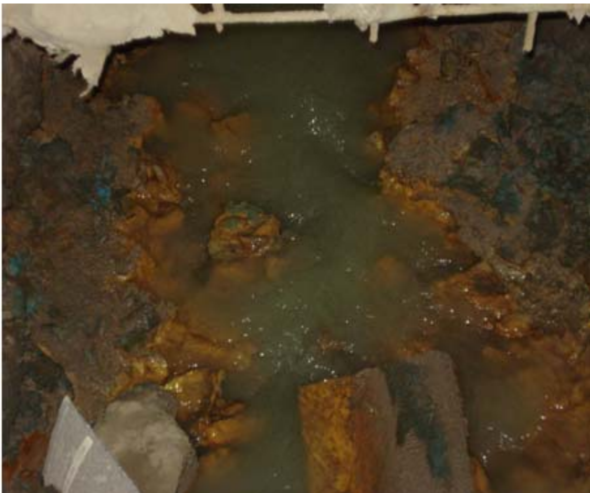
Figura D.2: Fotografía drenaje de El Teniente
