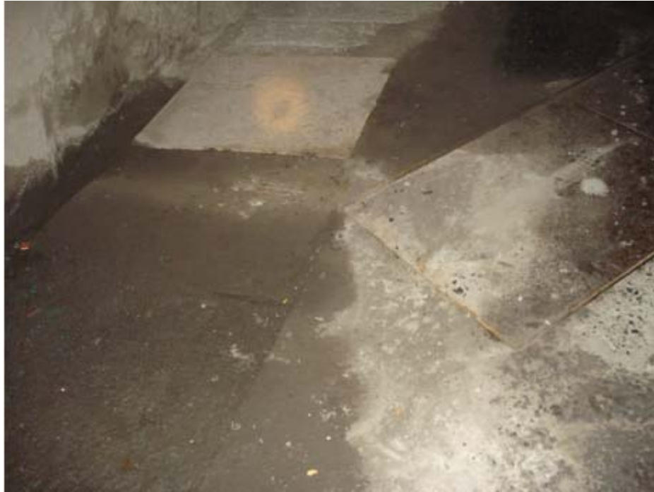
Figura 10: Zona de Unión Drenaje Nivel de Ventilación Sub-6 con Drenaje Teniente 7 Esmeralda
