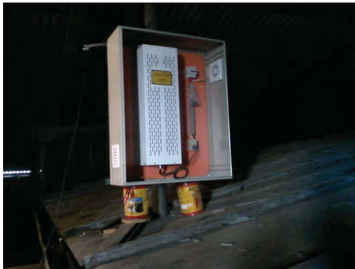
Figura 2-23: Gabinete con las cargas de rebalse
