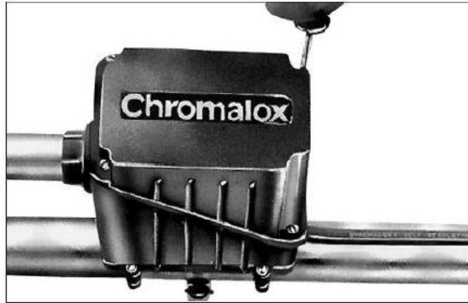
Figura 3-35: Montaje de tapa superior.
