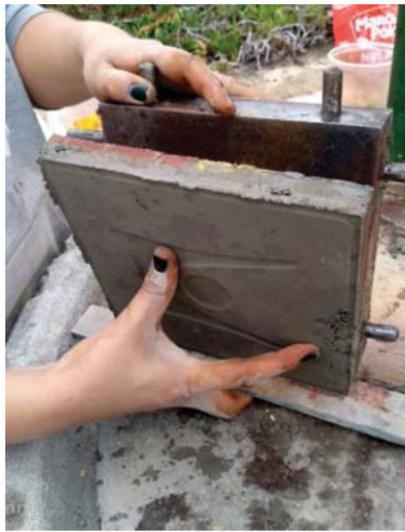
Se observa en las imágenes el proceso prensado y obtención de la baldosa.
