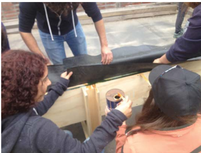
Armazón tela para vigas.
