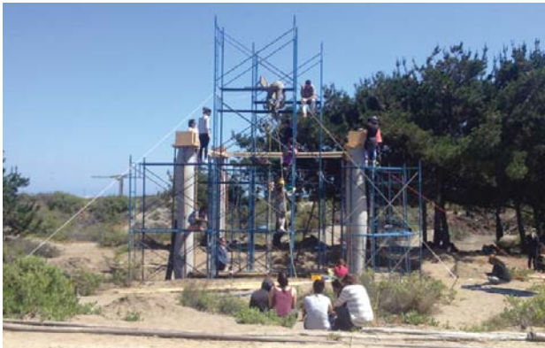
Subida de encofrado de vigas
