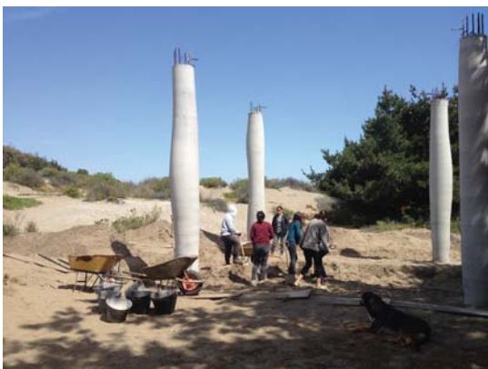
Pilares pre desarrollo de vigas
