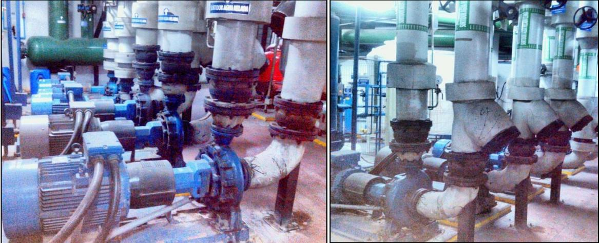
Fig. 2.13: Bombas de impulsión, son 3 bombas que suministran agua helada para los equipos de climatización (circuito secundario).
