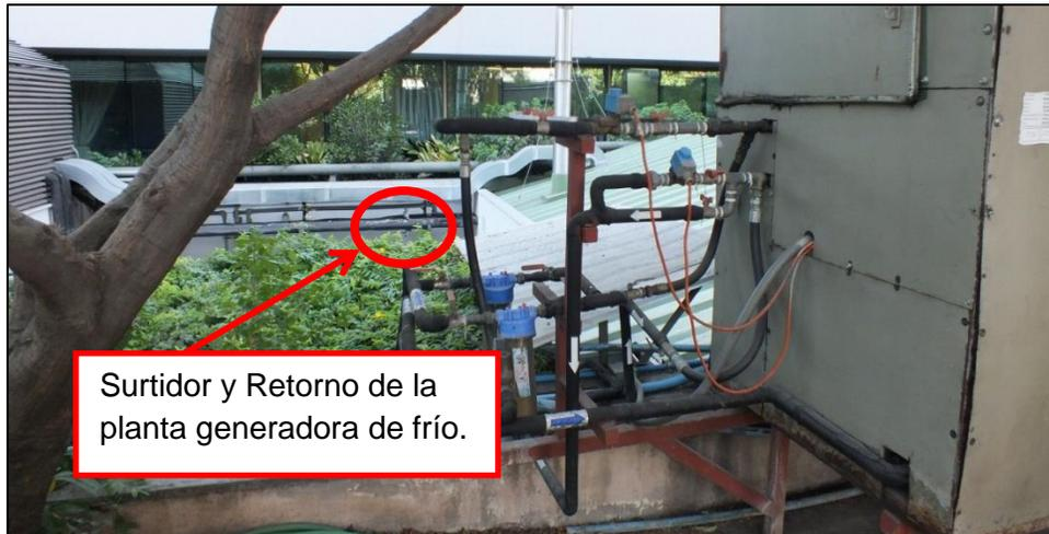
Fig. 2.2 a: Ubicación del surtidor y retorno de la planta generadora de frío.
