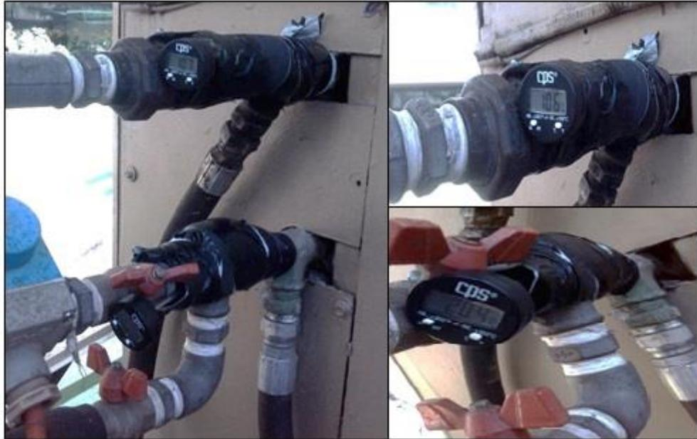
Fig. 3.3: Termómetros de contacto.
