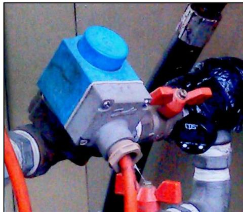
Fig. 2.5: Válvula Solenoide, normalmente abierta.
