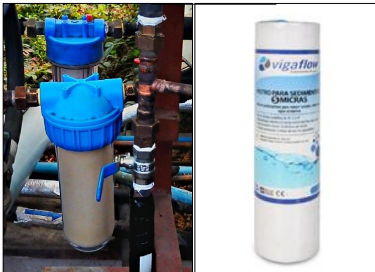
Fig. 2.6: Filtro de Sedimento 5 micras.
