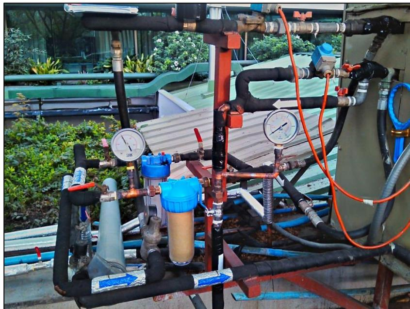
Fig. 3.2: Manómetros que se instalaron en el chiller Filtrine.
