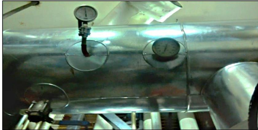
Fig. 2.15: Manifold de acumulación para el retorno.
