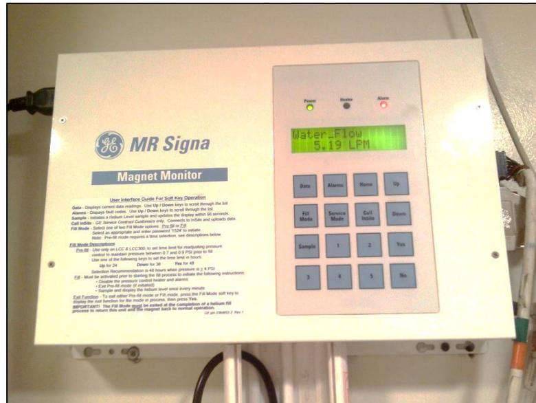
Fig. 3.1: Panel del resonador magnético, en el que se lee el caudal que suministra el chiller Filtrine.
