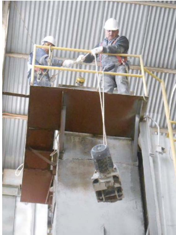
Fig. 80: Descendiendo motor.
