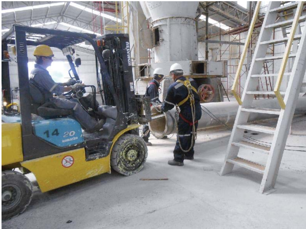
Fig. 63: Grúa horquilla izando ducto.
