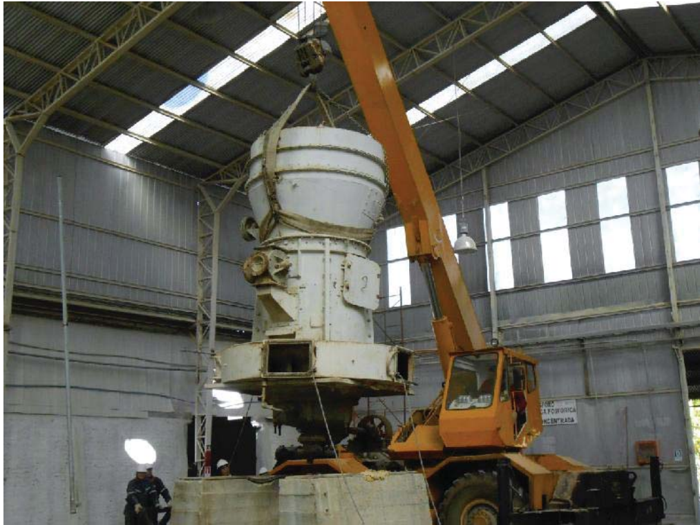
Fig. 104: Izaje del molino.
