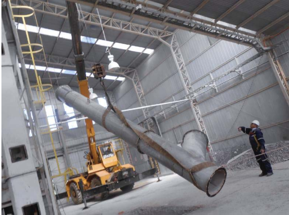
Fig. 72: Maniobrando y direccionando ducto.
