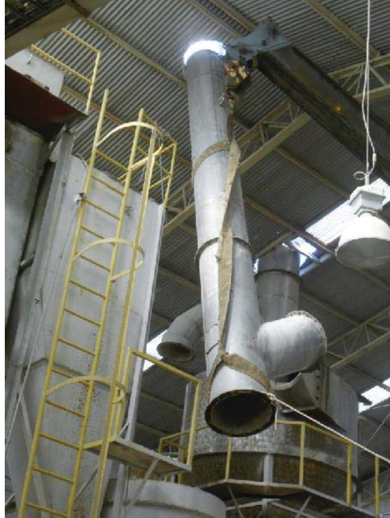
Fig. 70: Desmontaje ducto de seguridad.
