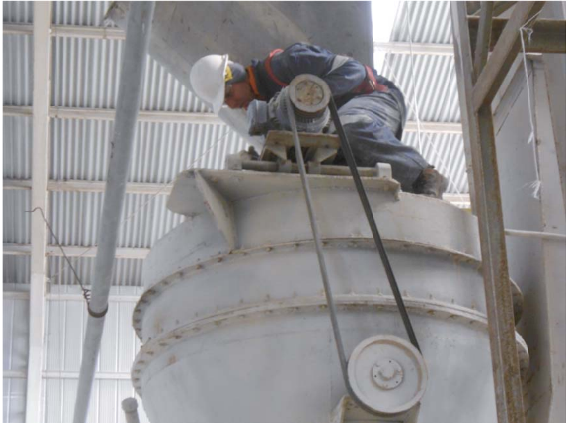
Fig. 17: Personal retirando pernos que fijan el motor eléctrico del Separador de Partículas.
