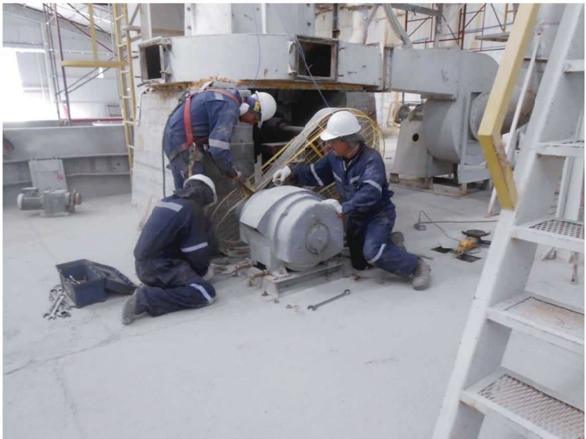
Fig. 16: Personal de Metalnet, realizando desmontaje de motor eléctrico.
