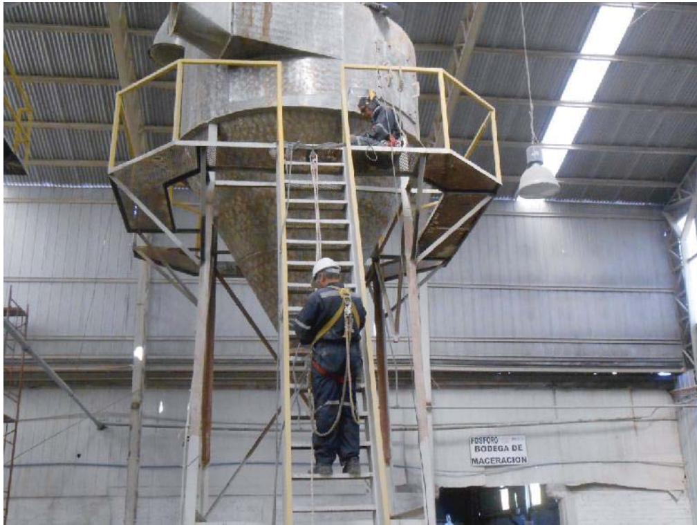
Fig. 88 Actividades para retirar escalera metálica.
