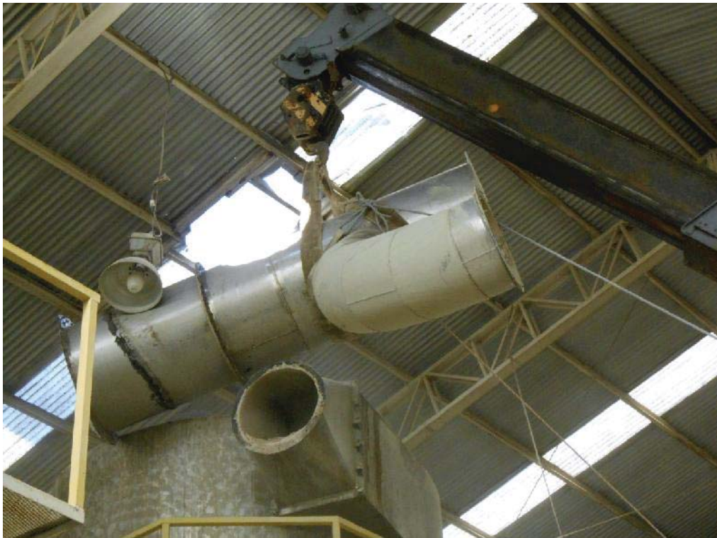
Fig. 77: Descendiendo segundo ducto de seguridad.
