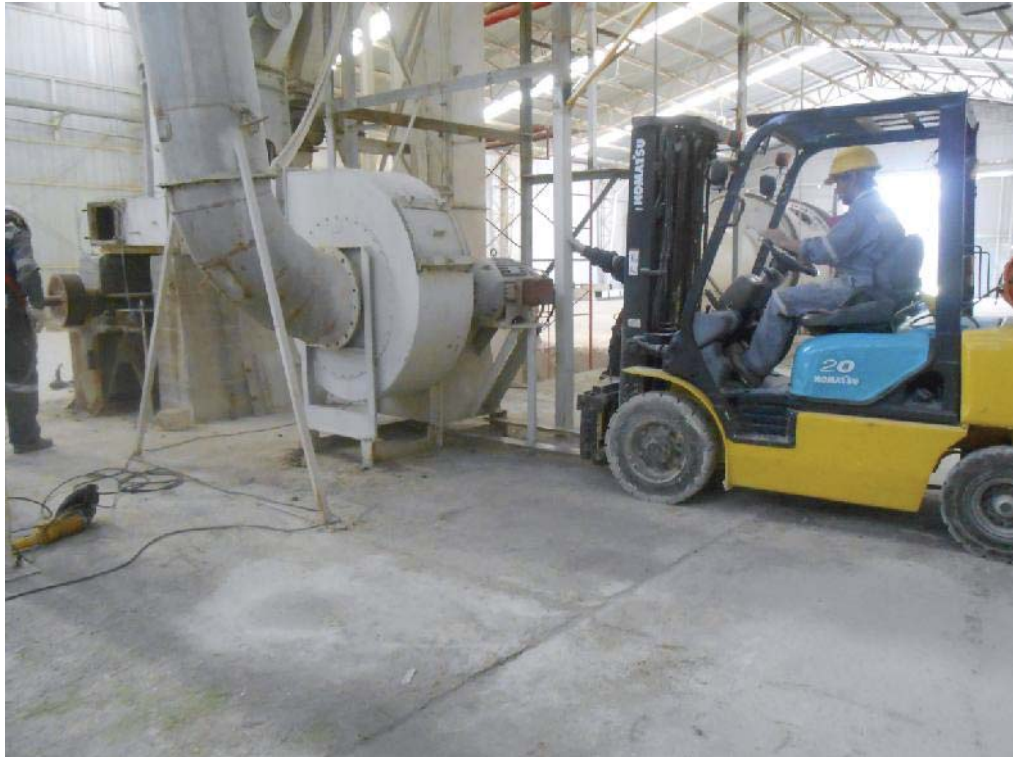
Fig. 56: Ubicando la grúa horquilla para trasladar ventilador.
