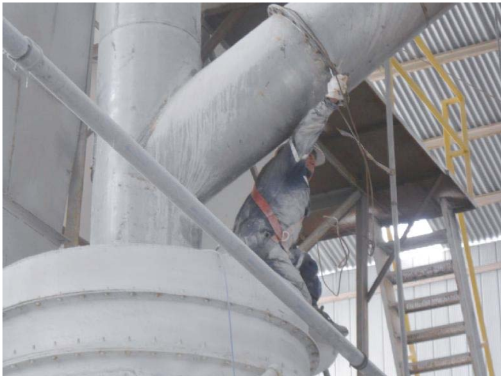
Fig. 61: Retiro de pernos que unen ductos.
