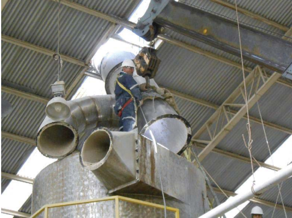
Fig. 76: Desmontaje segundo ducto de seguridad.
