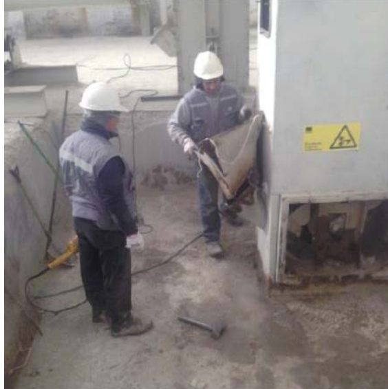
Fig. 82: Desmontaje de la tolva de alimentación
