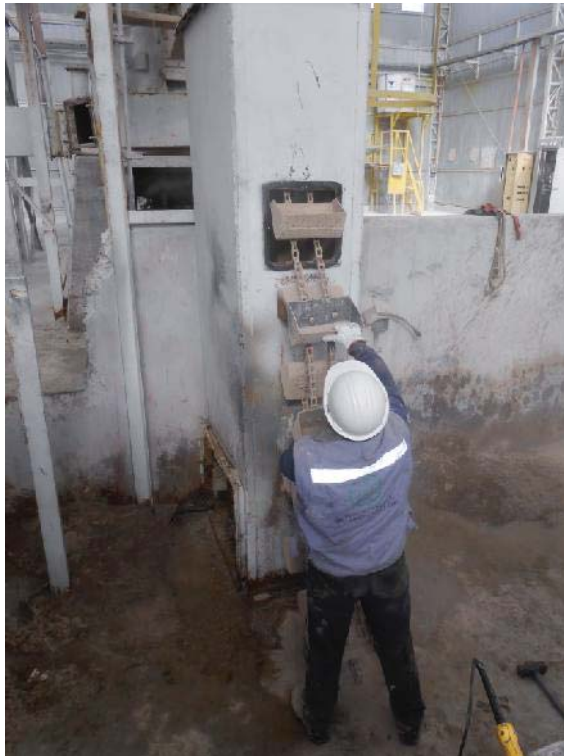
Fig. 83: Retirando cadena del interior del elevador.
