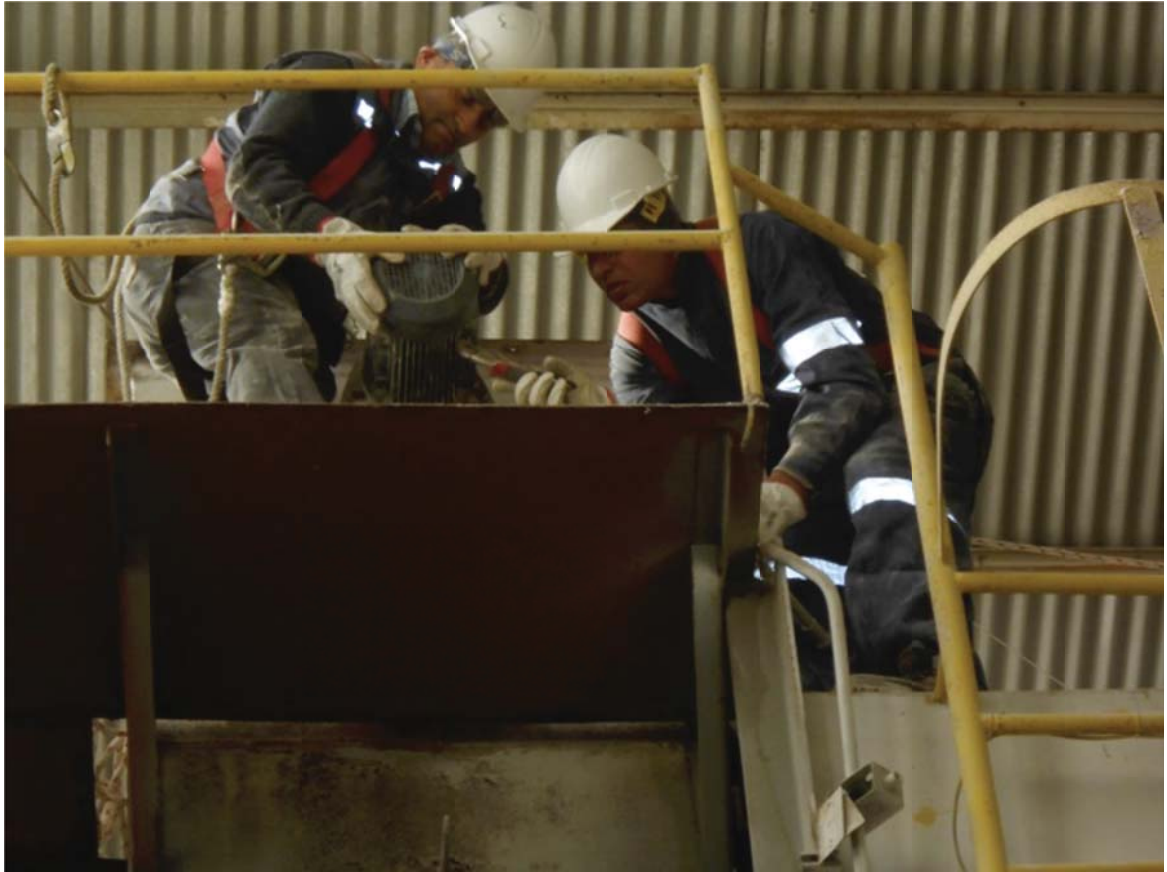
Fig. 20: Desmontaje de motor eléctrico del elevador de capachos.
