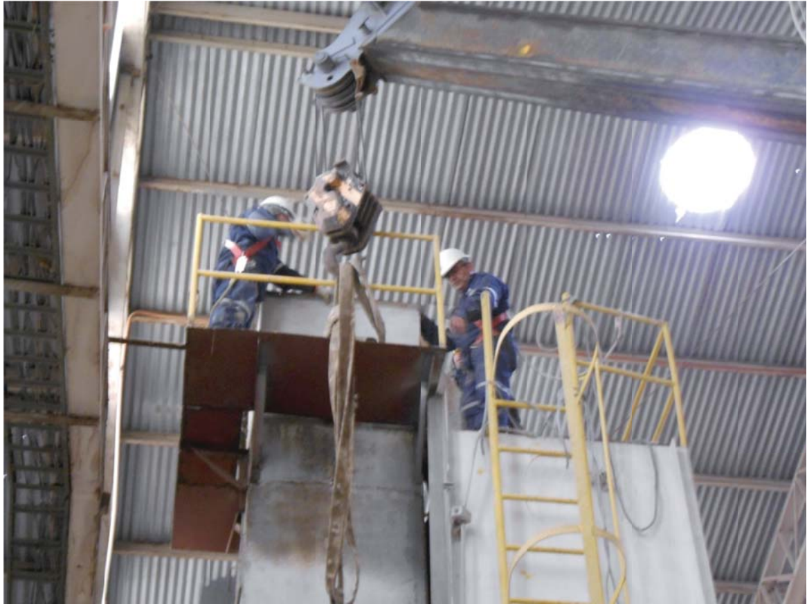
Fig. 23: Tensionado de eslingas para izar el elevador de capachos.
