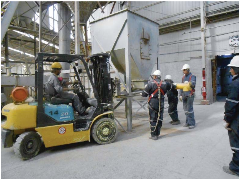
Fig. 85: Grúa horquilla se posiciona para hacer el transporte del equipo.
