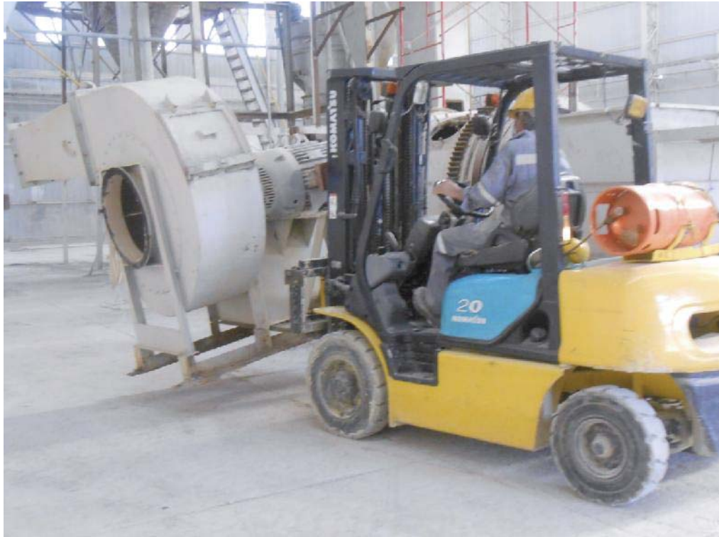
Fig. 58: Grúa horquilla transporta el ventilador a lugar de acopio.
