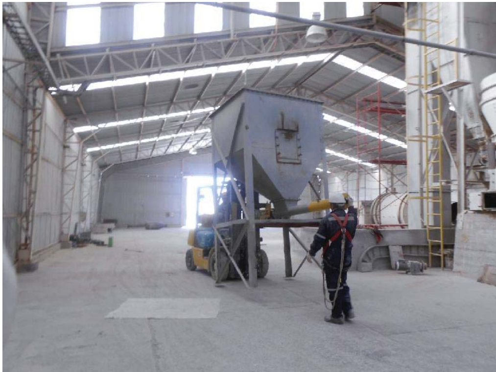
Fig. 87: Transporte del acumulador a lugar de acopio.
