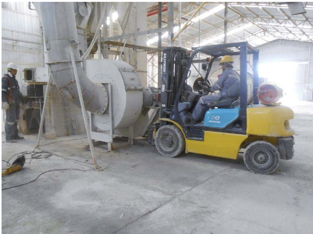
Fig. 57: Grúa horquilla iniciando transporte del ventilador.
