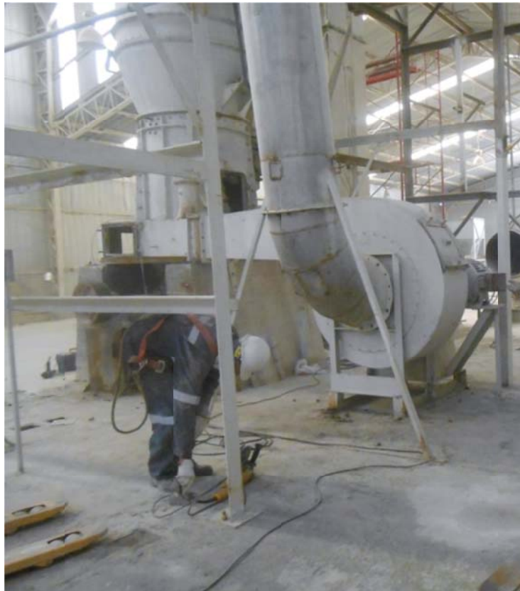
Fig. 18: Trabajos de corte en el ventilador centrífugo.
