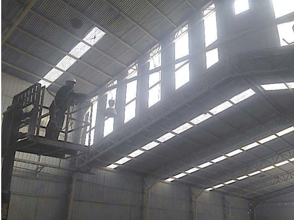
Fig. 106: Personal conectando red húmeda.
