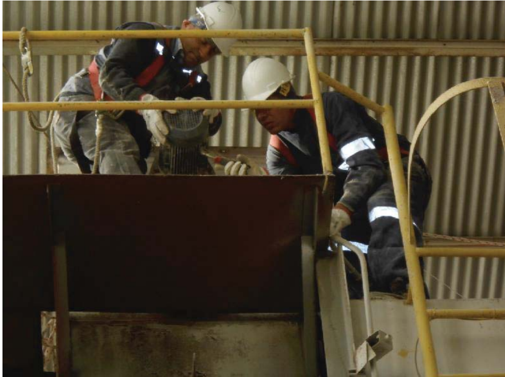
Fig. 78: Desinstalando motor.
