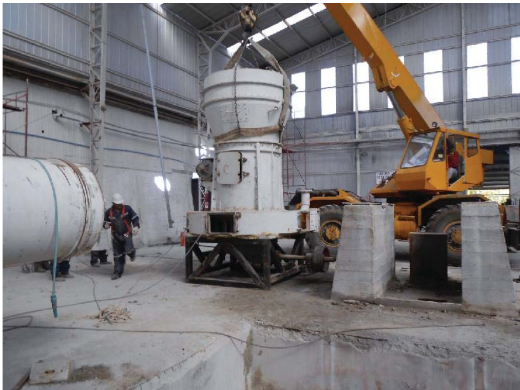
Fig. 105: Alojando el molino en base metálica.
