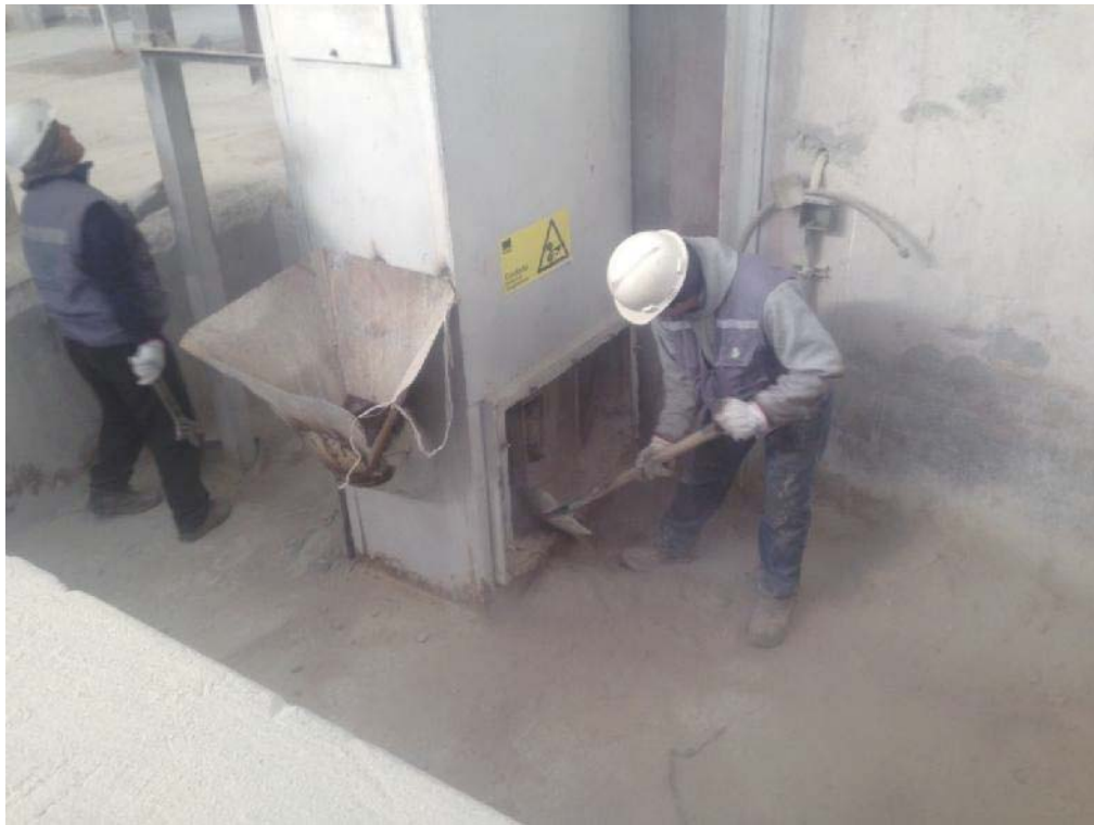
Fig. 81: Retiro de tapas laterales inferiores.
