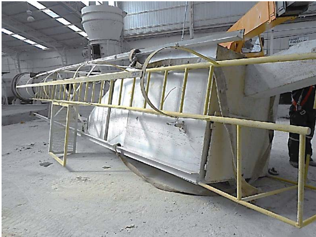
Fig. 99: Buzón de alimentación en nivel del piso.
