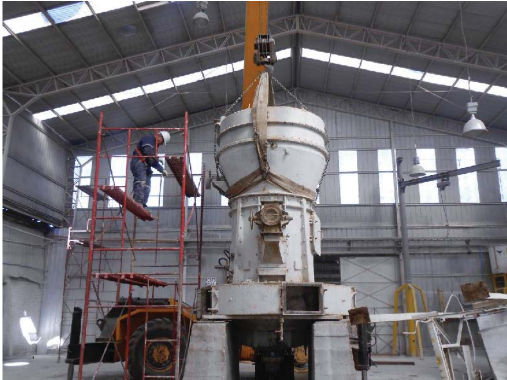
Fig. 102: Grúa tensionando eslingas y cadenas.
