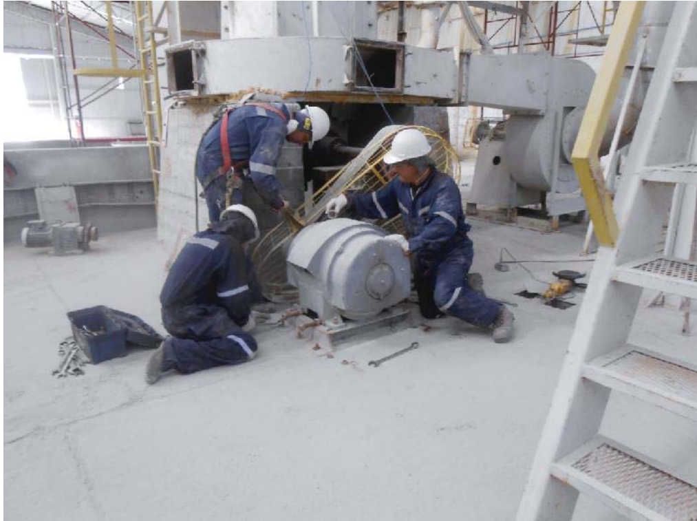
Fig. 52: Personal de Metalnet, realizando desmontaje de motor eléctrico.
