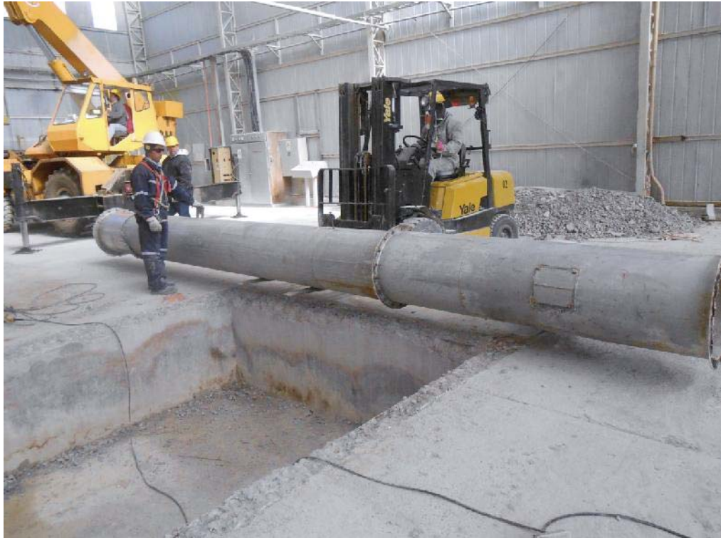
Fig. 74: Grúa horquilla transporta el ducto a lugar de acopio.
