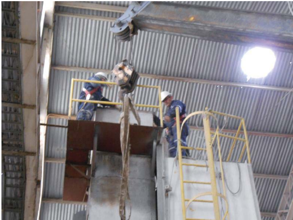
Fig. 93: Grúa tensionando eslingas.
