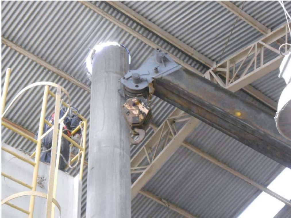
Fig. 68: Grúa posicionando gancho.
