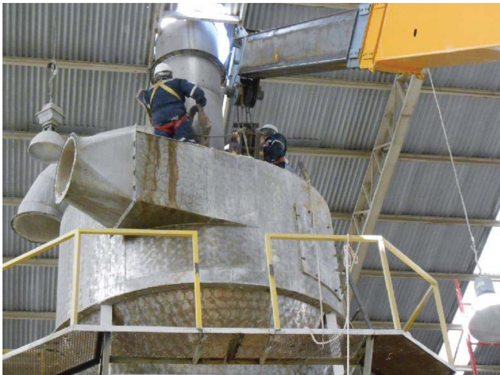
Fig. 75: Posicionamiento del gancho en el segundo ducto de seguridad.
