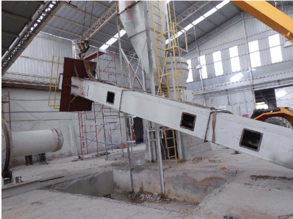
Fig. 96: Inclinación del elevador de capachos.
