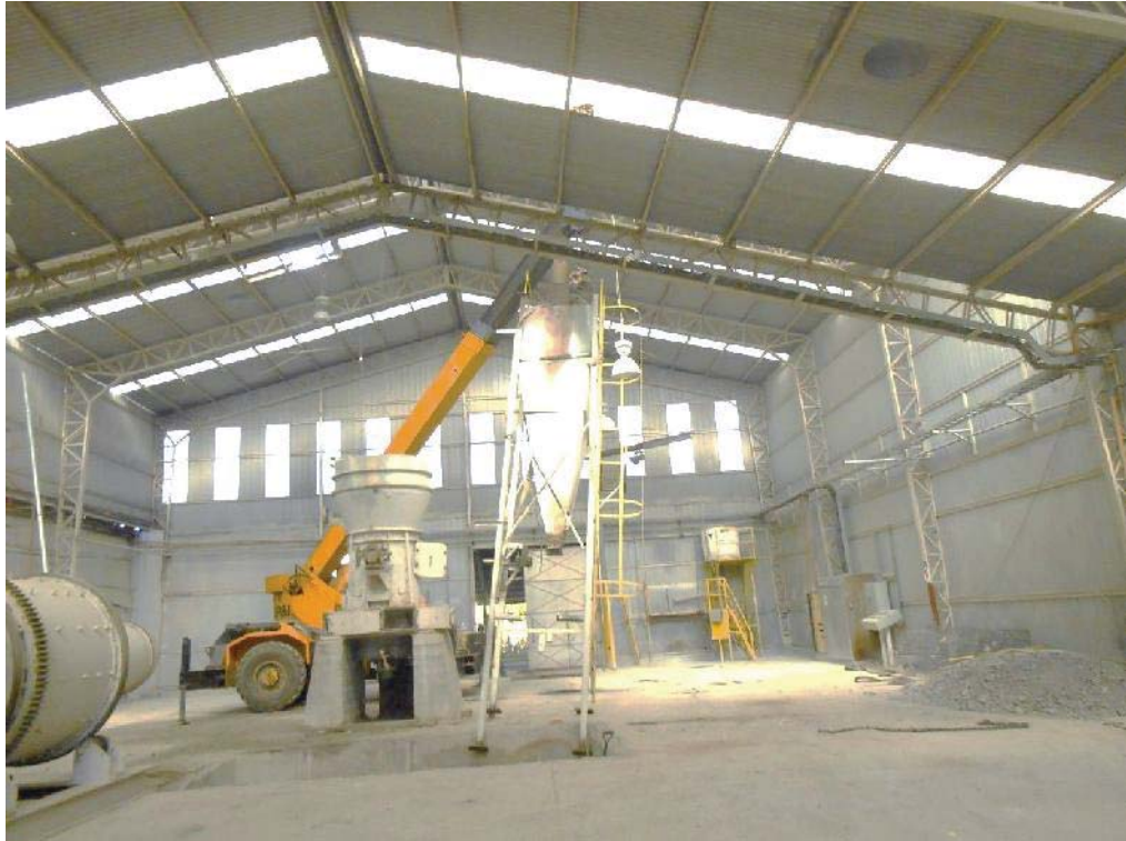
Fig. 98: Izaje del buzón de alimentación.
