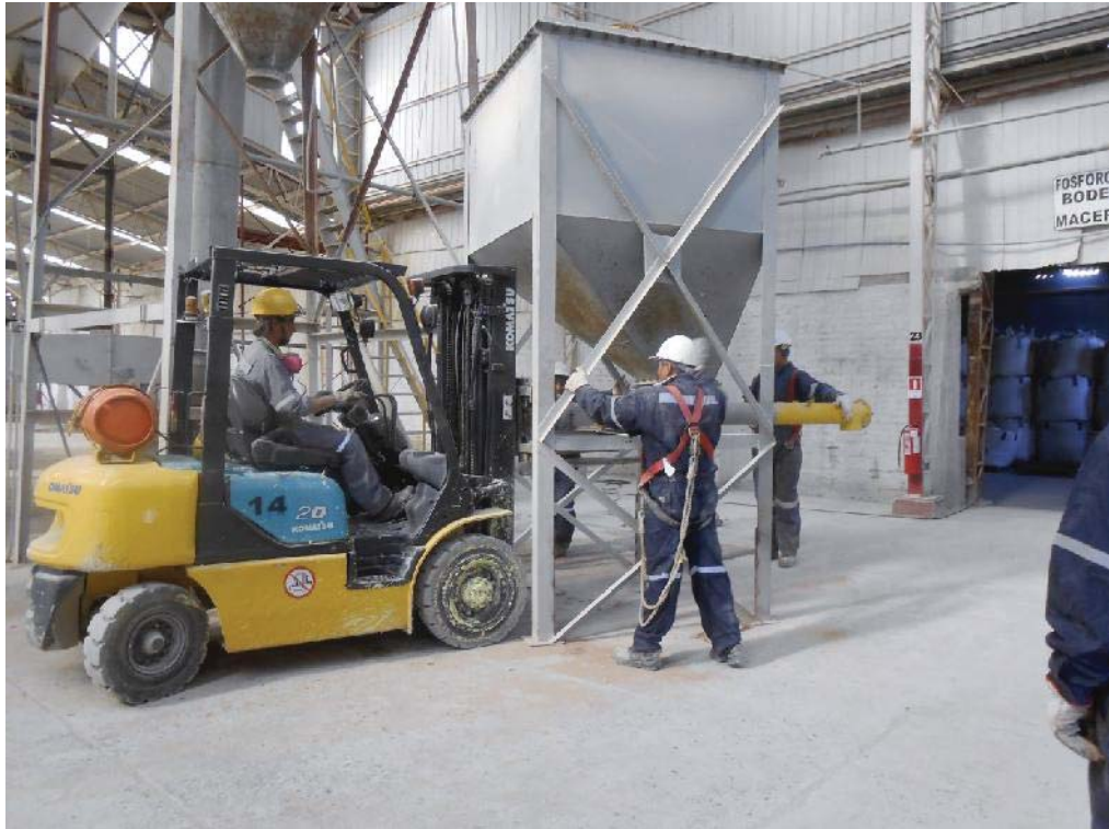
Fig. 86: Grúa horquilla izando el acumulador.
