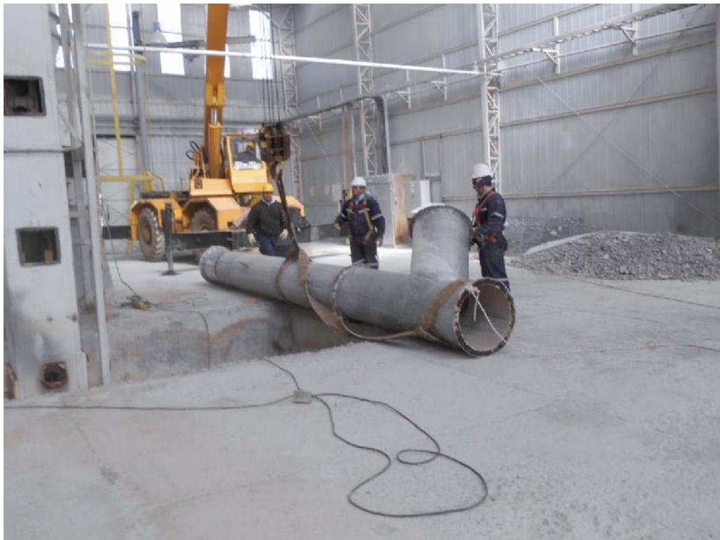
Fig. 73: Ubicando a nivel del piso el ducto.
