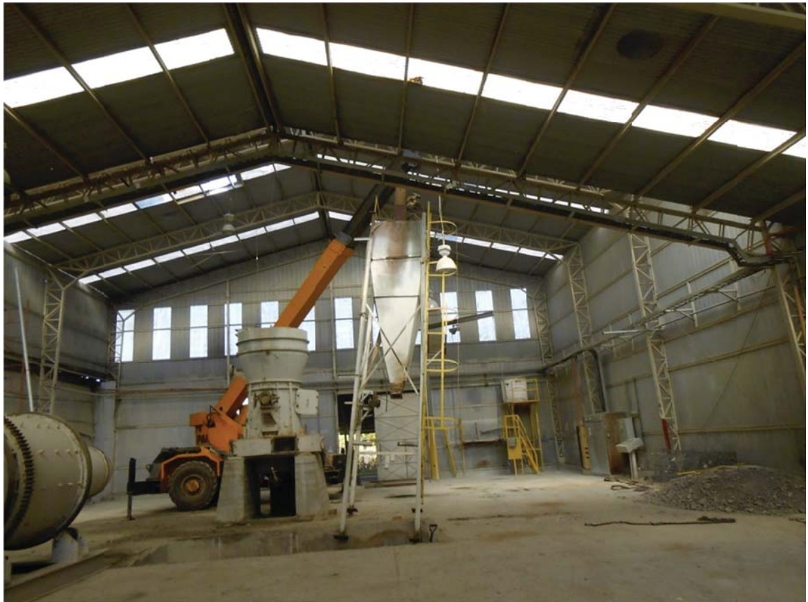
Fig. 24: Izaje buzón de alimentación.
