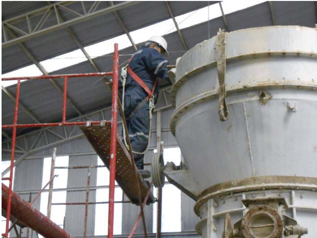
Fig. 100: Instalación de cadenas y eslingas en el molino.
