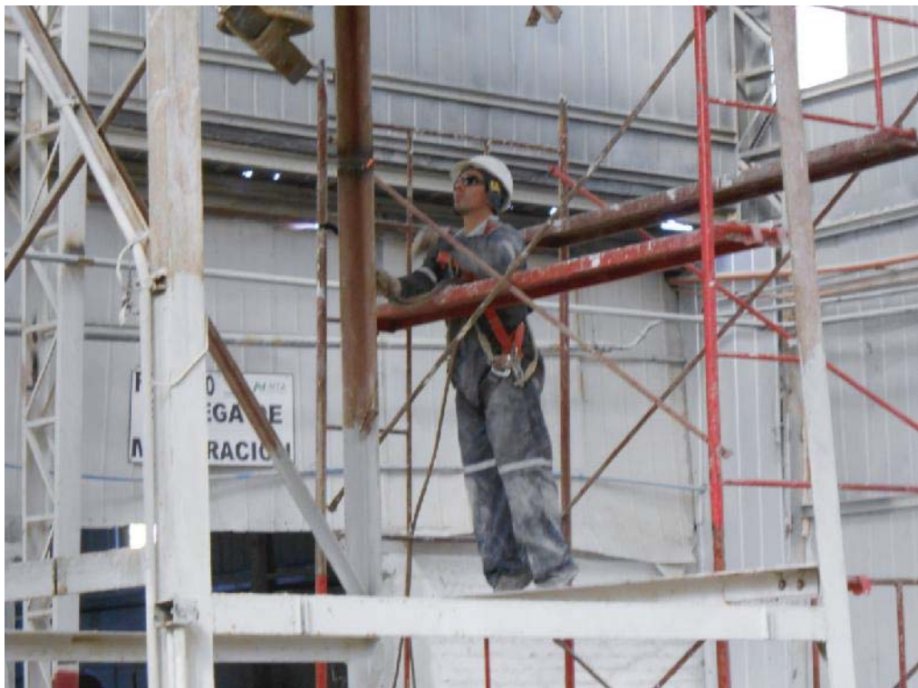
Fig. 91: Personal realizando cortes en estructura del ciclón.
