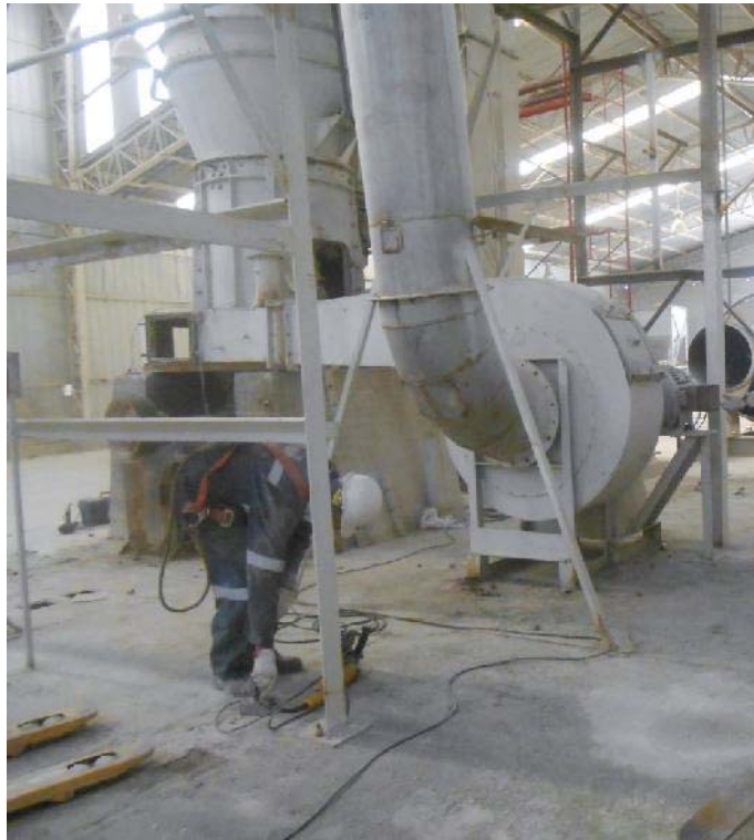
Fig.55: Trabajos de corte en el ventilador.
