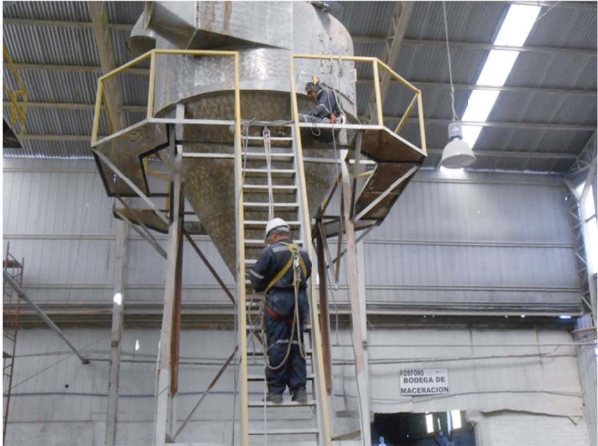
Fig. 22: Desinstalando la escalera del ciclón.
