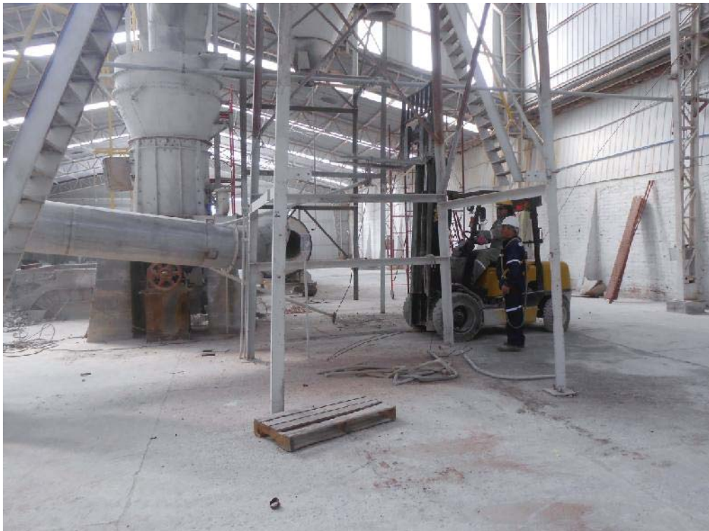
Fig. 65: Grúa horquilla transporte de ducto (extremo contrario).
