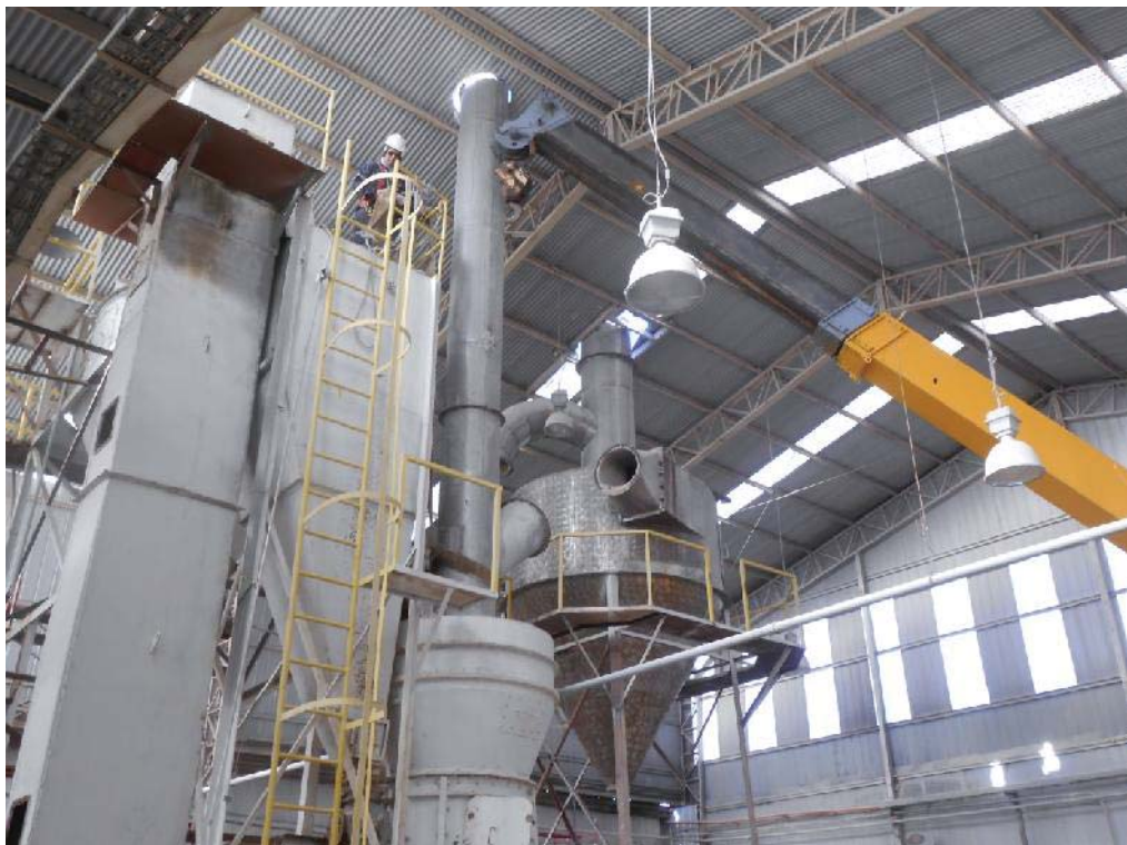
Fig. 69: Grúa tensando eslingas.
