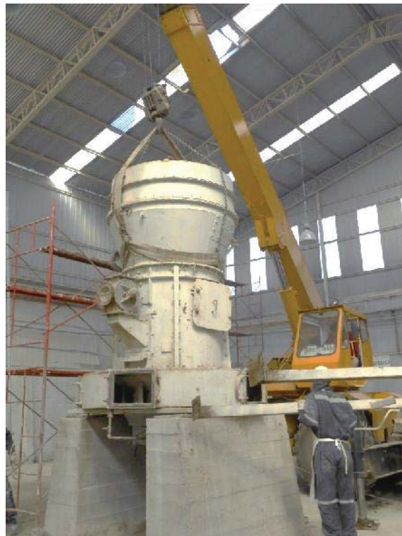
Fig. 103: Personal retirando andamios para realizar maniobra de izaje.
