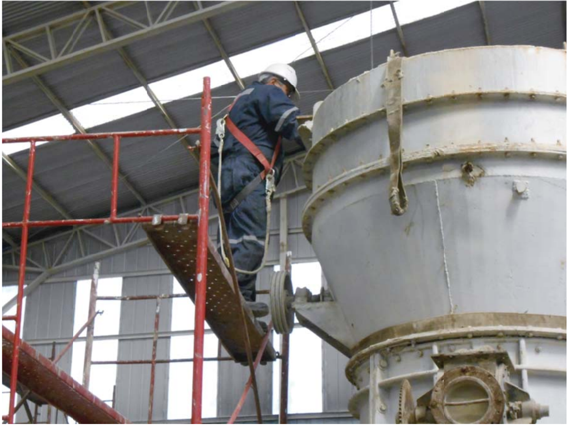
Fig. 25: Instalación de eslingas y cadenas en el molino Raymond 4237.
