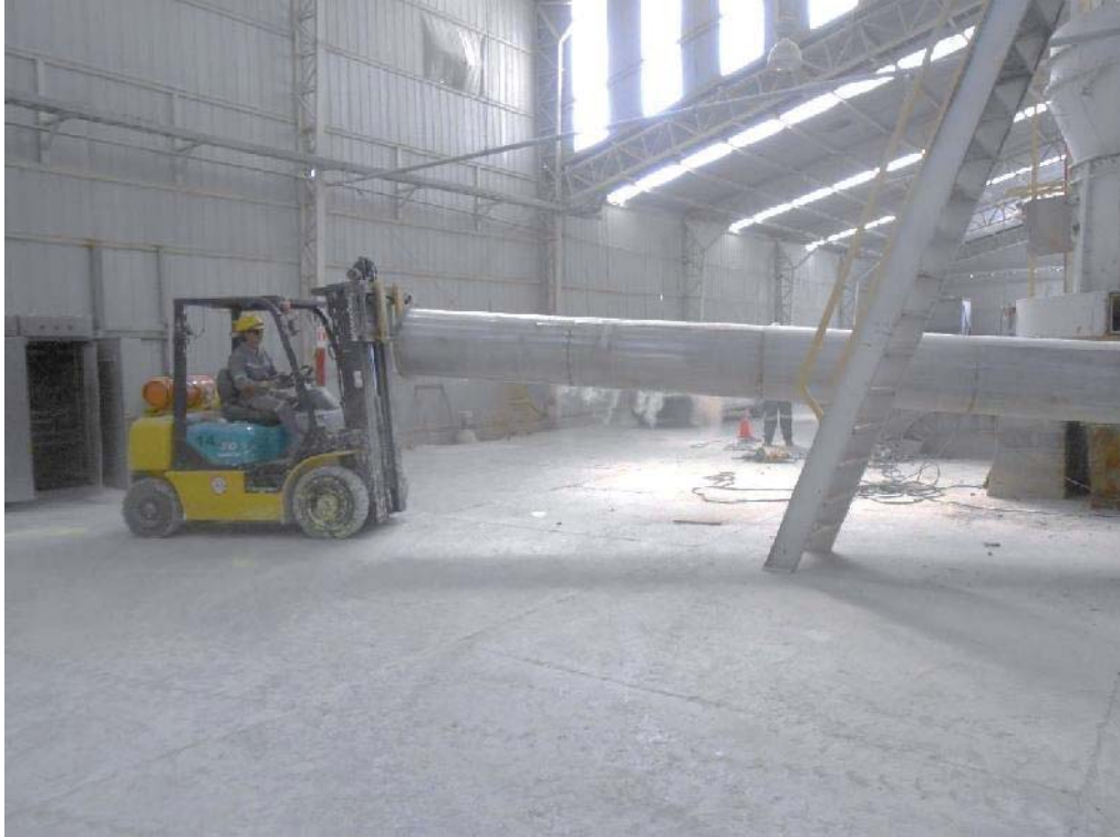
Fig. 64: Transporte de ducto.
