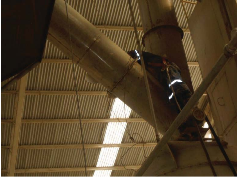
Fig. 60: Personal retirando pernos de los flanges.
