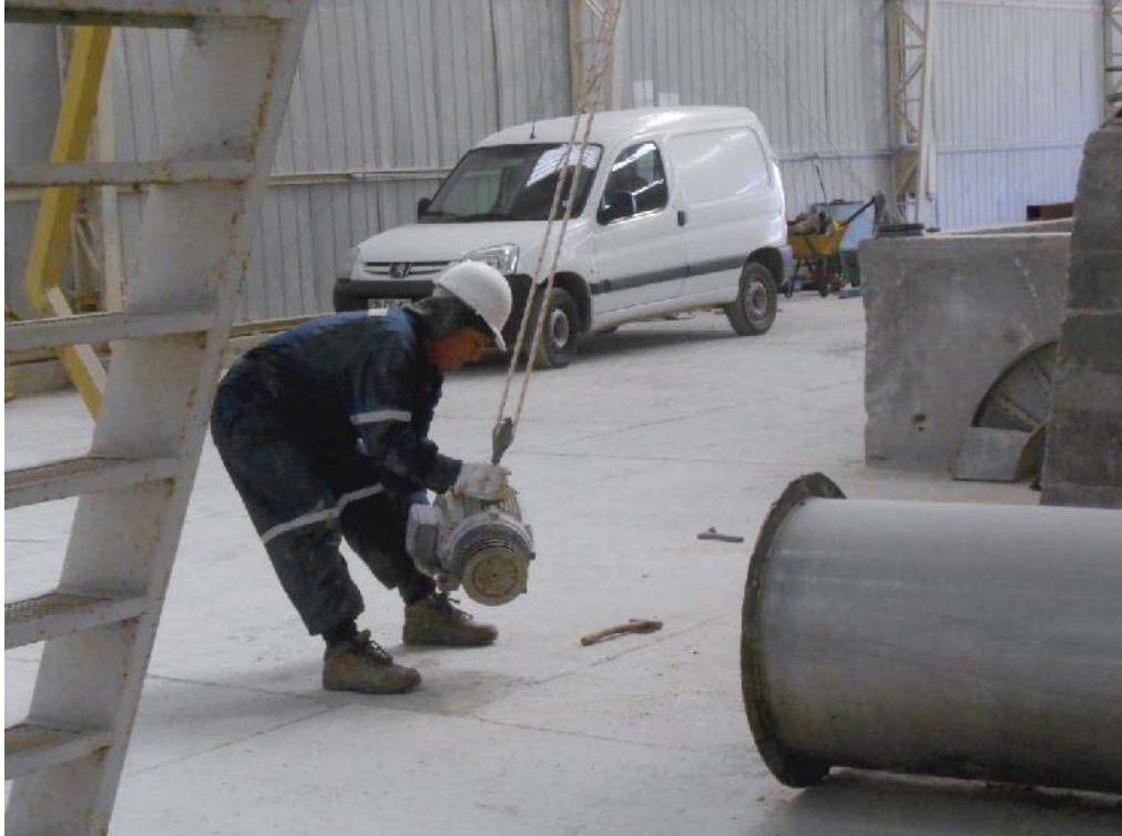
Fig. 54: Recibiendo motor eléctrico del separador de partículas a nivel del piso.
