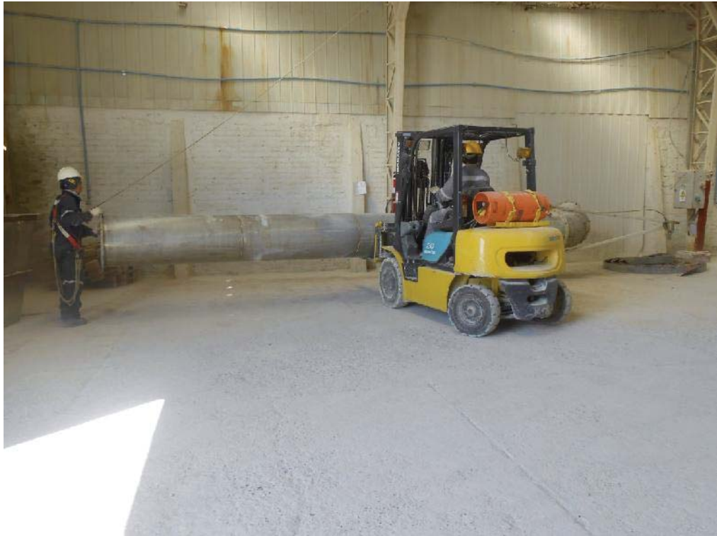
Fig. 66: Ubicando el ducto en zona de acopio.
