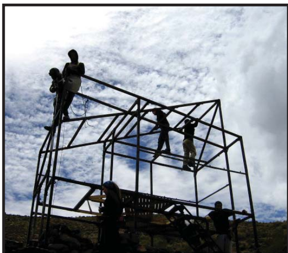
Limpieza y revestimiento de la estructura
