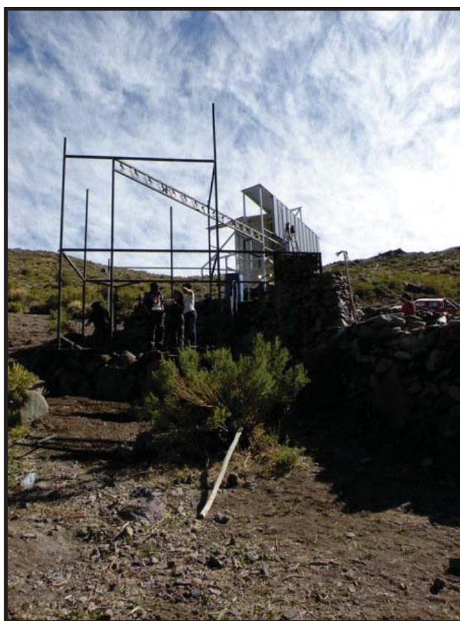
Construcción de la extensión del refugio
