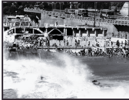
Ex piscina funcionando.
