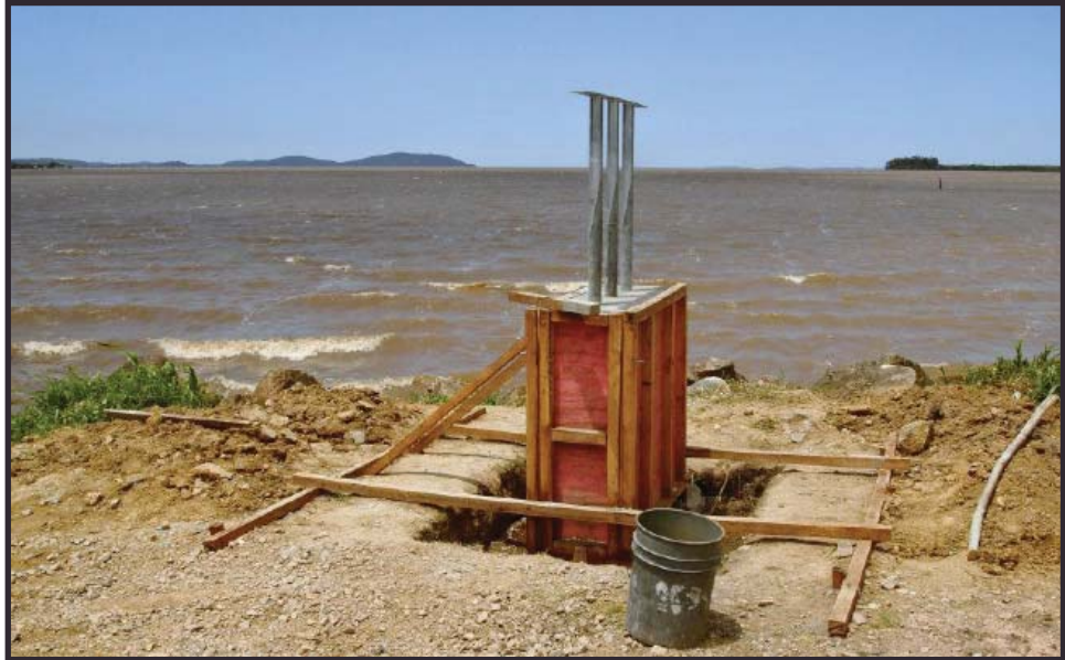
Encofrado pedestal
