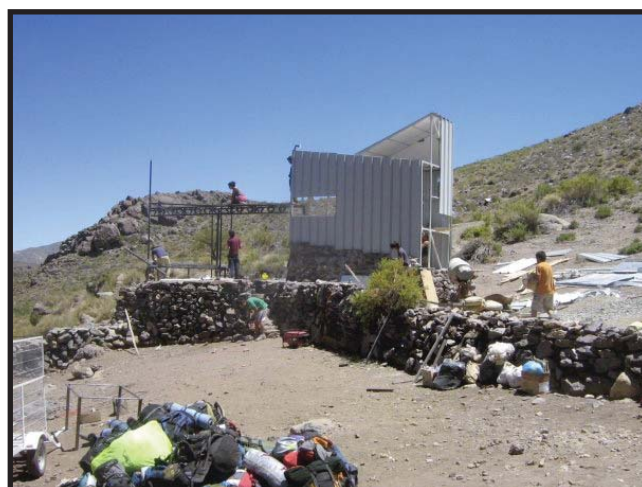
Las pircas como la base de la estructura
