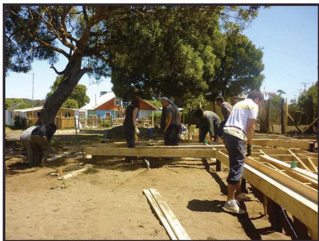
Construcción estructura del paseo
