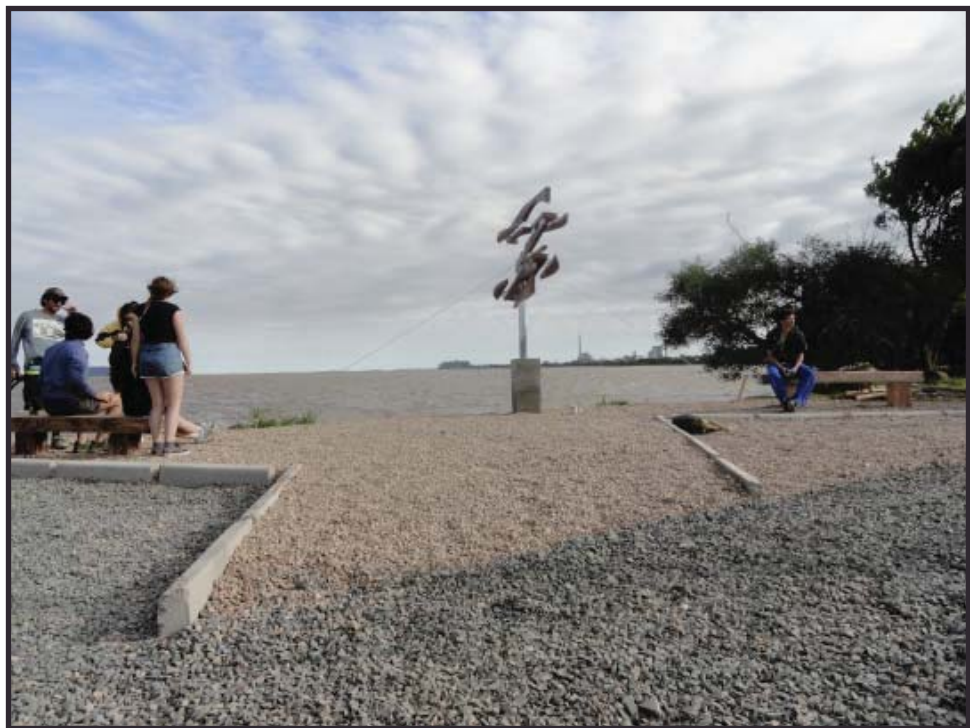
Construcción de la plaza con ripio
