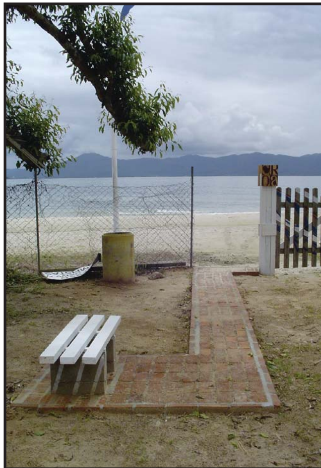
Construcción del espesor de la entrada
