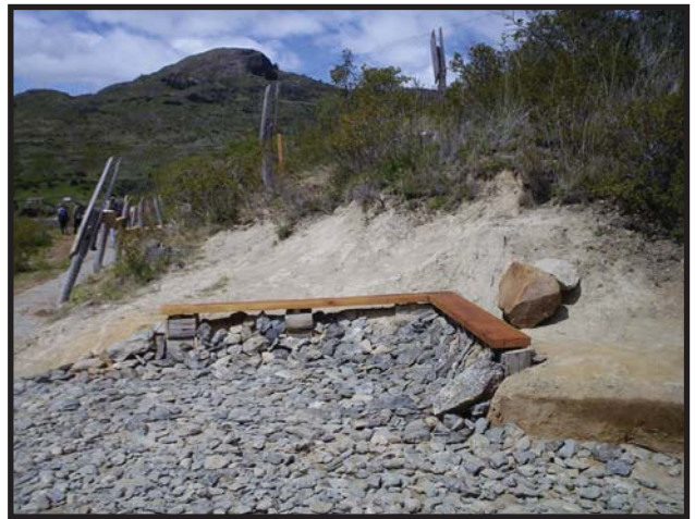
Construcción de banca en la curva del sendero
