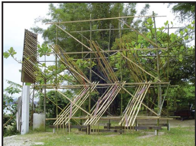
Estructura soporte del cartel
