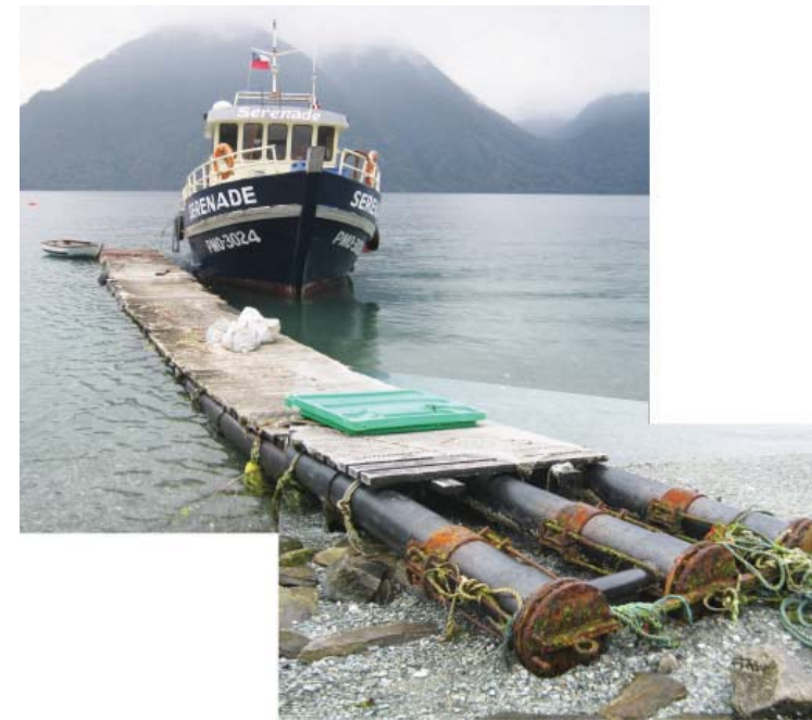
Figura 26. Muelle flotante con superficie de madera y flotabilidad de tubos de pvc de alta densidad. Fuente: L.Krebs, travesía 2011.
