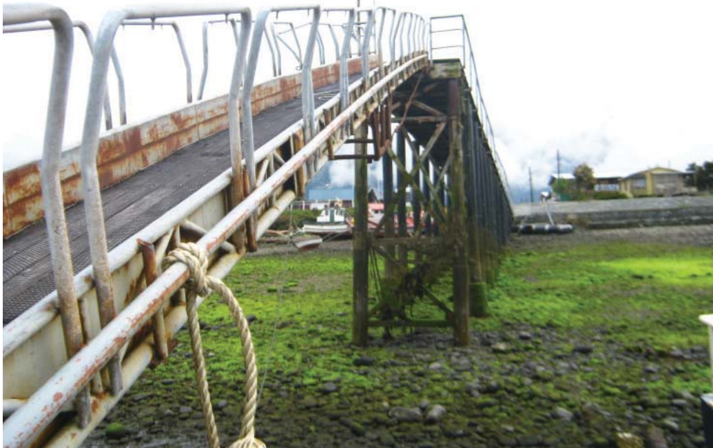
Figura 16. Muelle, Pasarela pivotante con extremo de plataforma flotante de Hornopirén. Fuente: L.Krebs, travesía 2011.
