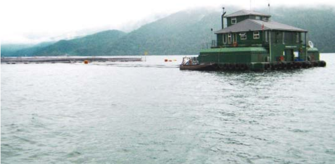
Figura 10. Casa flotante de la salmonera, uso como oficina y bodega guardado alimentos salmones. Fuente: L.Krebs, travesía 2011
