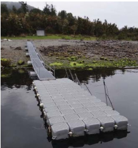
Figura 19. Pasarela metálica y plataforma flotante en Quiaca. Fuente: L.Krebs , travesía 2011.
