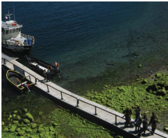
Figura 38. Fotografías del muelle flotante de 2,5 mts de ancho de Huinay. Se puede observar cómo parte del muelle se posa en la orilla al bajar la marea.Fuente: L.Krebs, travesía 2011.
