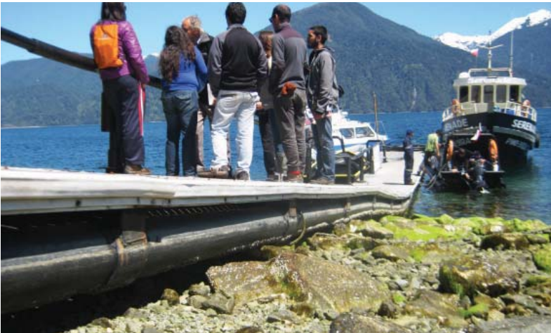
Figura 38. Fotografías del muelle flotante de 2,5 mts de ancho de Huinay. Se puede observar cómo parte del muelle se posa en la orilla al bajar la marea.Fuente: L.Krebs, travesía 2011.
