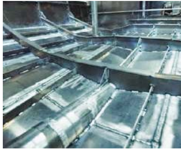
Figura 113. Estructura interior casco aluminio. Fuente: propia del autor, empresa Sitecna S.A.
