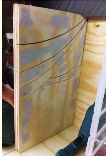
4. Terminaciones con masilla mágica sobre tornillos.
