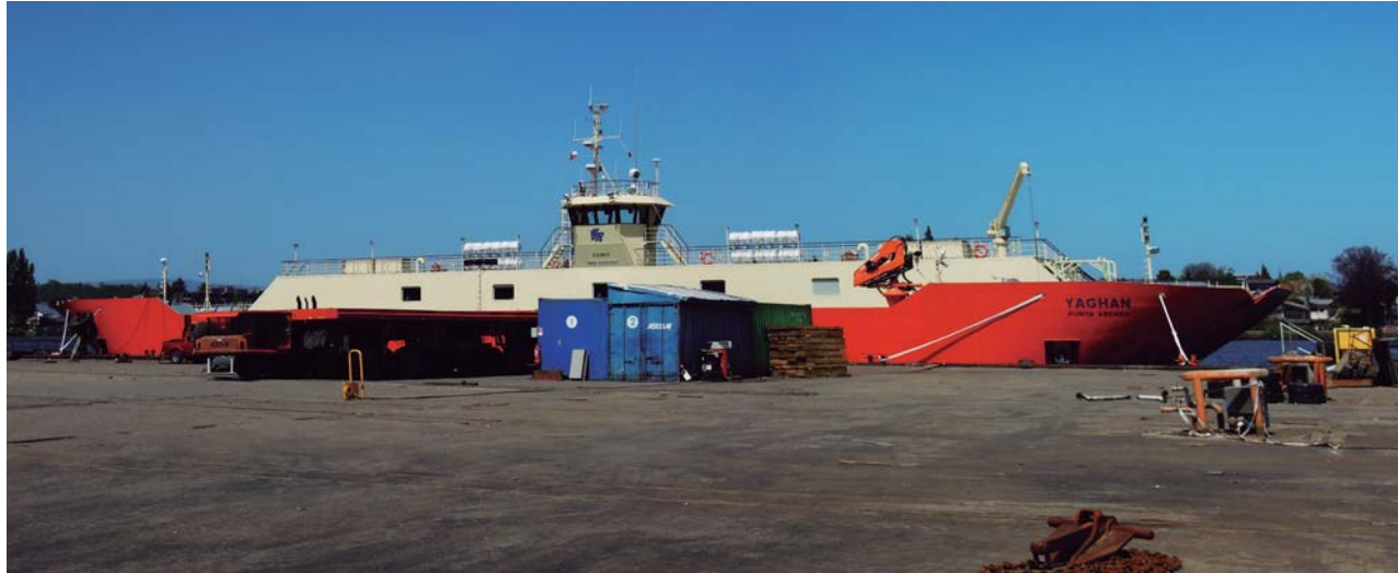
fig 98 Terminaciones y pintura FERRY, en el agua.
