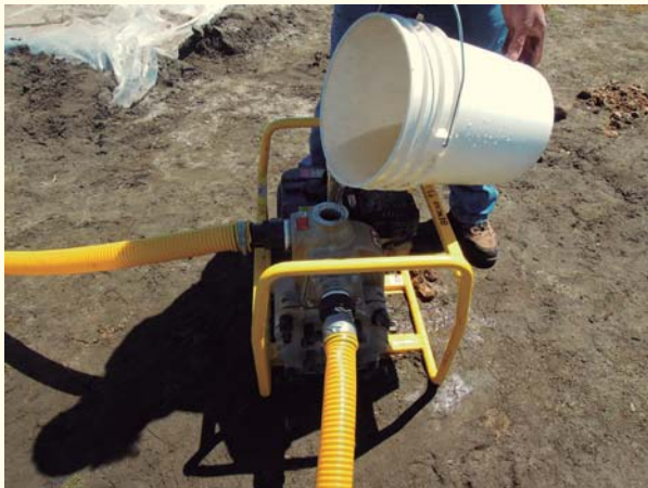
Cebar de agua bomba Hidráulica
