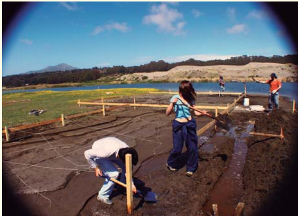
Construcción del canal para la paleta de olas
