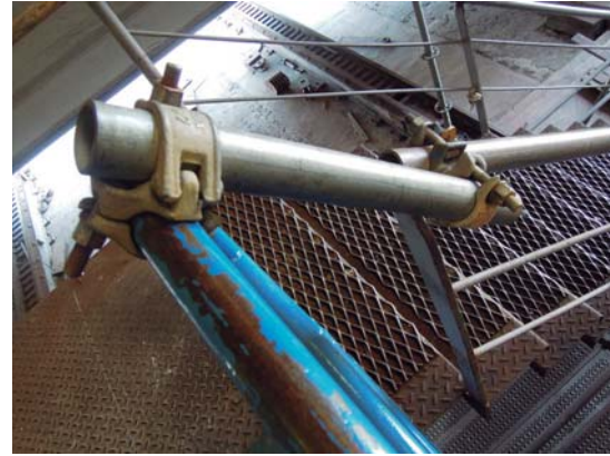
fig70-74.Detalles de seguridad barandas y escaleras.
