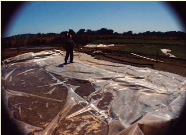
Colocación de polietileno (previamente unido)
