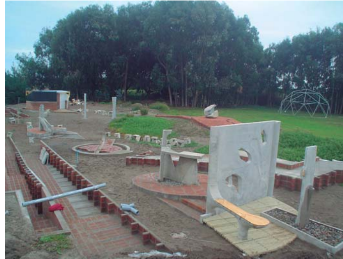
Fig. 73-75 Fotografías Calzada de la Aguas, 2008. archivo histórico e.[ad].
