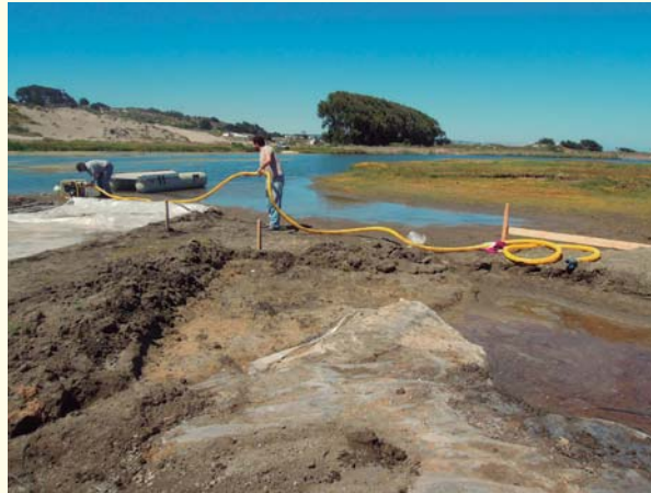
Preparación de la manguera de la bomba hidráulica
