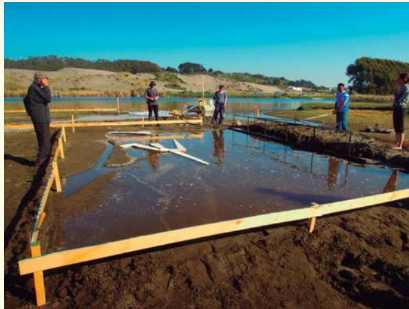
Llenado de agua mediante bomba hidráulica
