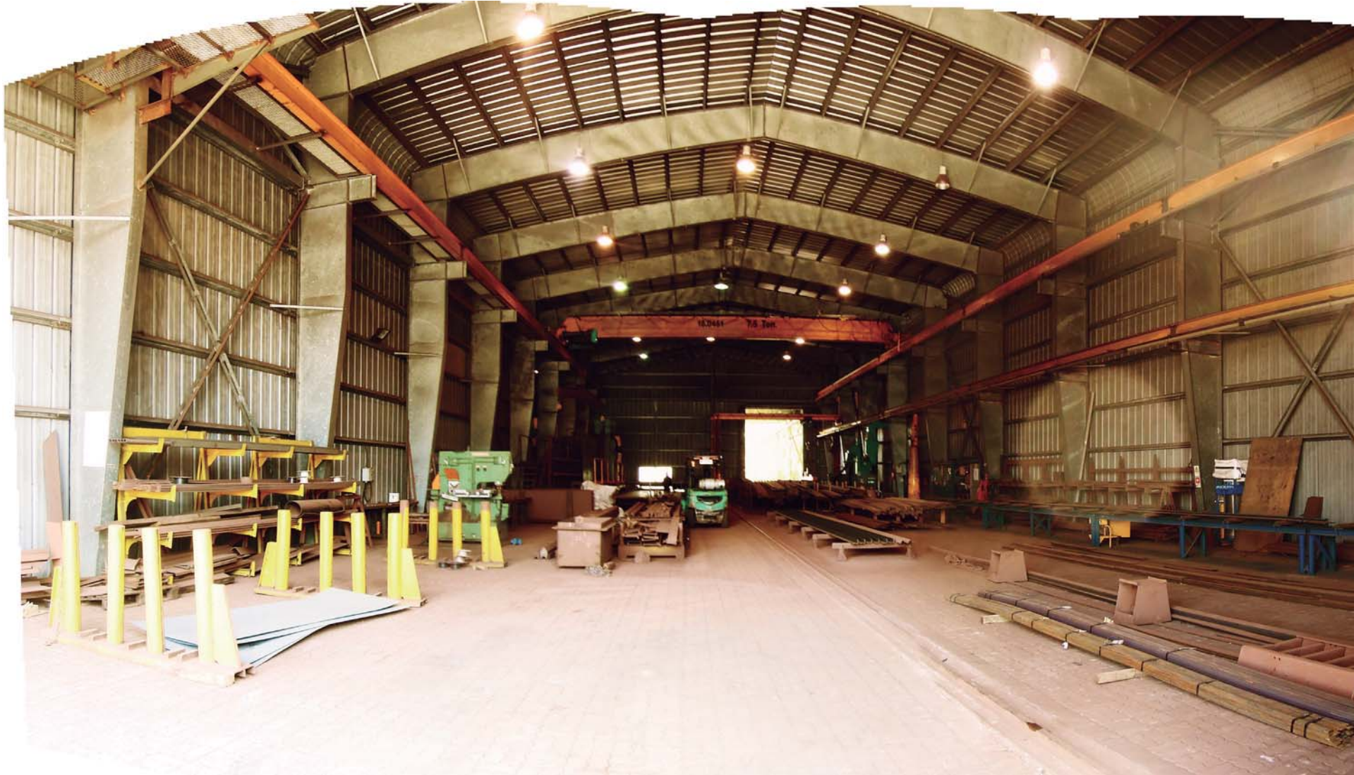
fig 43. Astillero ASENAV, Chile, galpón almacenamiento, arenado y primera pintura anticorrosiva.
