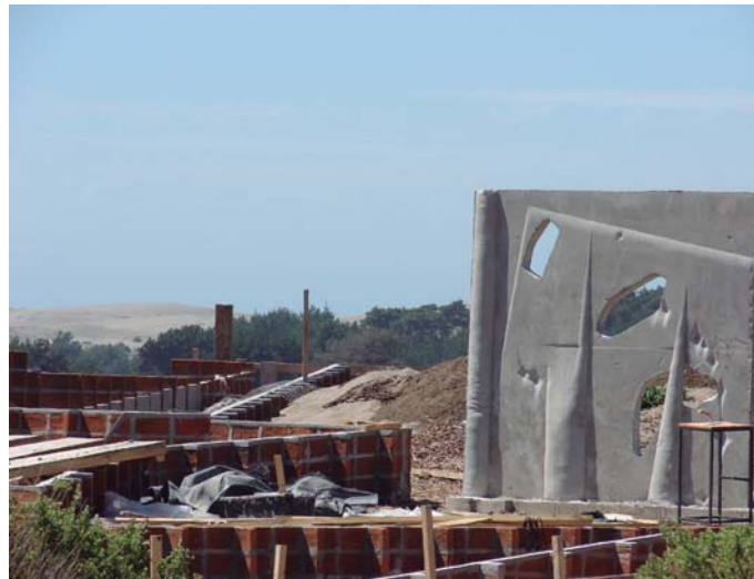
Fig. 76-77 Fotografía del autor, muro construido bajo la tecnología de los Moldajes Flexibles, 2006.
