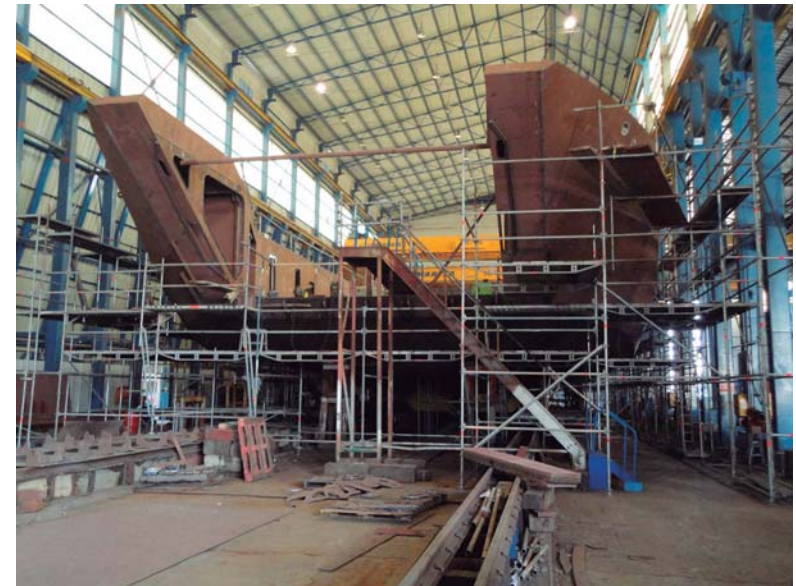
fig 56-60. Galpón de ensamblaje y soldadura.
