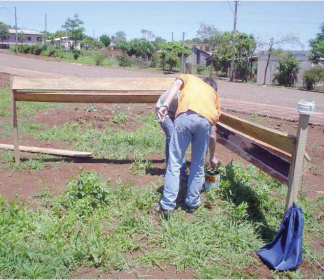
Construcción de Bastidores se da en dos largos quebrados, y en ellos se sostienen los mastiles que llevan los Parapetos. En las tablas interiores se pintan de negro, dejando un friso para que los habitantes del lugar pongan su nombre.
