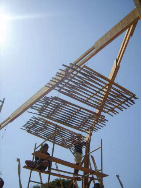
1.3 Entramados. Este elemento viene a cerrar el coreto, volviendose en el "cielo" de este.
