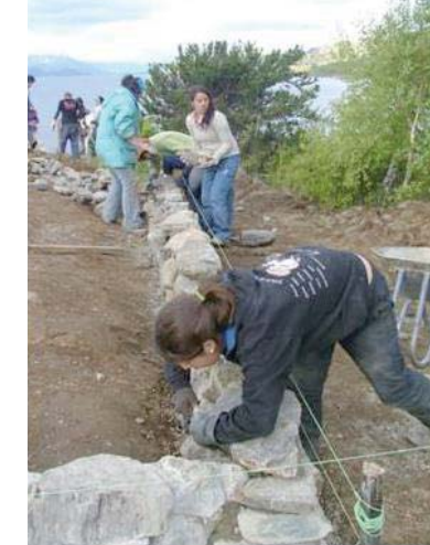
Se aplana el terreno dejando dos terrazas contenidas por pircas, dibujando así espacios para permanecer y circular. A la vez en estas terrazas se instala la escultura de Balcells.
