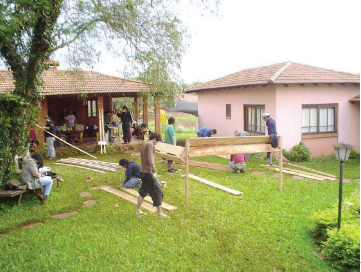
Construcción de Bastidores se da en dos largos quebrados, y en ellos se sostienen los mastiles que llevan los Parapetos. En las tablas interiores se pintan de negro, dejando un friso para que los habitantes del lugar pongan su nombre.
