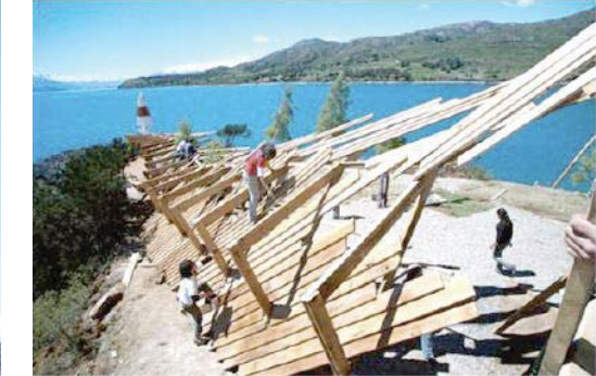
Se reviste con tablas, construyendo una manta que protege a los habitantes del viento que se produce en la plaza. A la vez dejan las tablas descalzadas construyendo ventanas para tener una mirada total del lugar.
