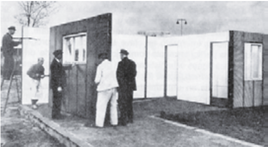
17. Fase de montaje de las partes prefabricadas
