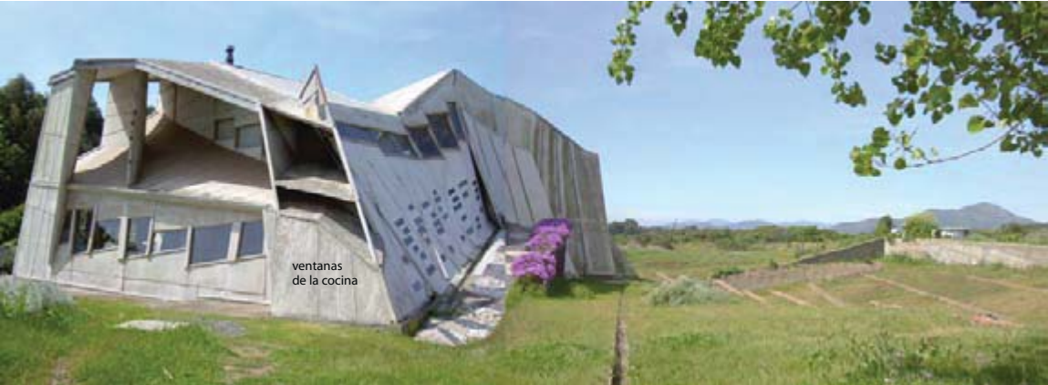
Observación: La holgura de los exteriores de la Hospedería del Errante invita a conocer las fachadas de la obra: el pudor de aproximarse a la cocina para rodear la obra es una posibilidad, no una obligación.
