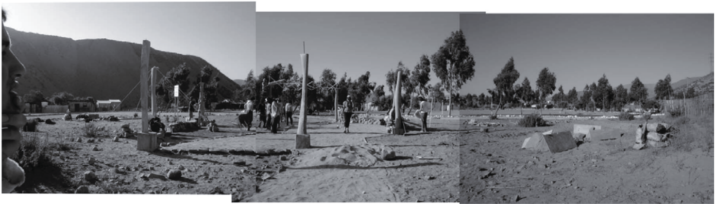
d Límites de la obra confinados por los pilares, realizados con moldaje flexible.
