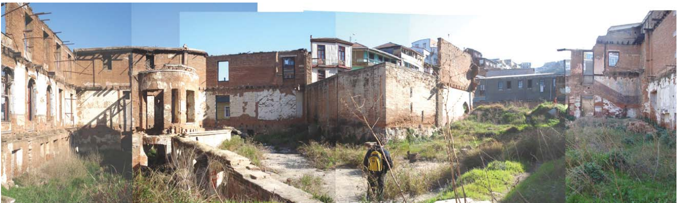
interior del terreno, vista desde calle Severin
