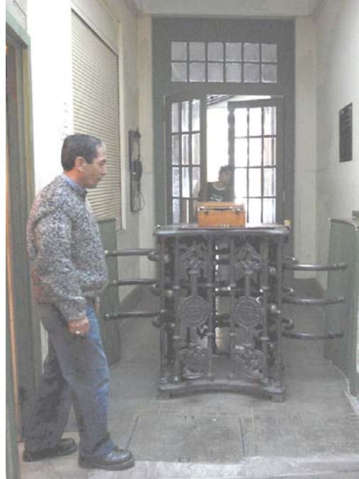
interior estación Plaza Justicia, vista desde la zona del ascensor
