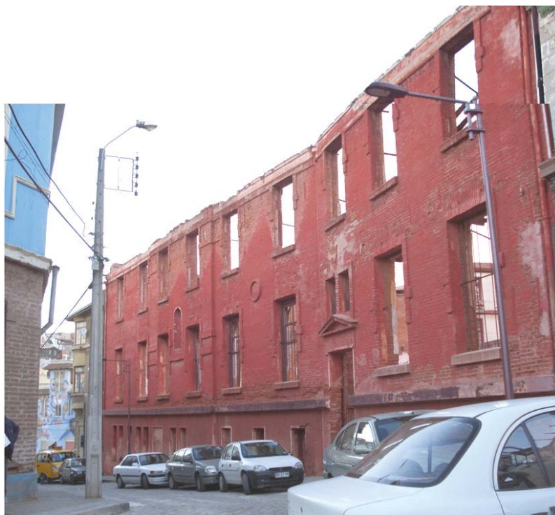
muro perimetral calle Severin
