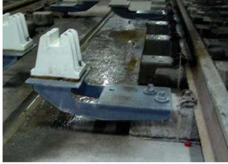
Figura 2-10 Aislador y zapata de sujeción del tercer riel
