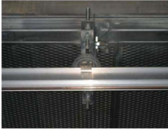
Figura 2-12 Catenaria rígida compuesta por el perfil de aluminio el conductor de cobre y el aislador de sujeción (Fuente: *Electrificación y estudios ferroviarios e2f*)
