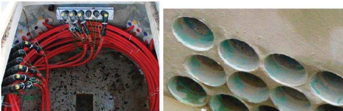
Figura 5-8 Detalle terminación de ductos con campanas, cámara de registro (Fuente: *Redes de media tensión Duván*)
