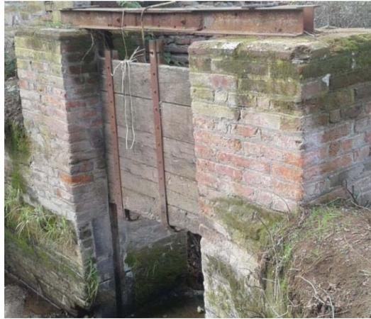
Figura 6-1: Compuerta en mal estado (fuente: terreno de análisis del proyecto)
