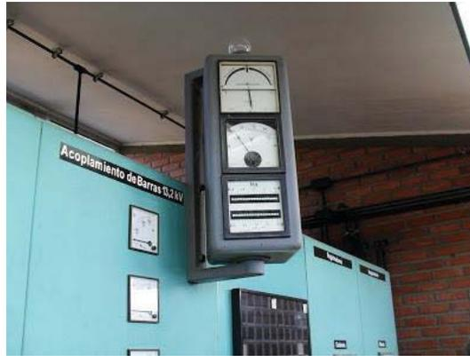
Figura 4-2: Equipo de sincronización para el acoplamiento a la red (fuente: <http://ingenieriaelectricaexplicada.blogspot.com>)
