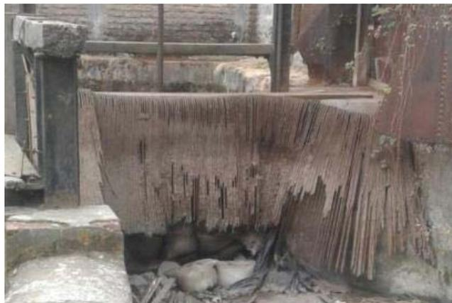
Figura 6-2: Reja anti-residuos en mal estado (fuente: terreno de análisis del proyecto)
