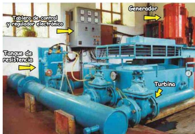
Figura 6-5: Componentes de la sala de máquinas de una central hidroeléctrica (fuente: <http://cef.uca.edu.sv>)
