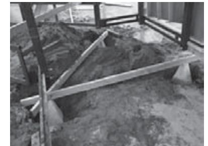
instalación de apoyos definitivos: vibrados Aconcret + viguetas pino impregnado 2 x 4".
