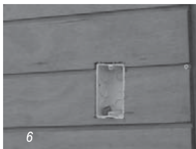
1.- máquina retroexcavadora y sus trabajos para la instalación de las redes de agua y electricidad 2.- red de agua desde empalme a cubícula locanda 3.- surco para la implementación de la red eléctrica 4.- empalme de inspección red eléctrica 5,6.- tomas de electricidad al interior de la cubícula... autosuficiencia
