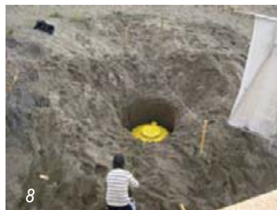
6.- tabique desde el interior del sector íntimo de la Cubícula 7.- interior baño, abertura luminosa en la unión entre baño y muro curvo 8.- dren de desagüe
