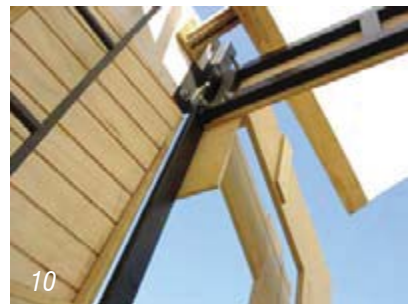
6.- Llegada de parantes a viga adicional superior 7.- Llegada de parantes a viga adicional superior 8, 9.-parantes fijados a estructura primaria 10.- viga adicional superior fijada a viga de cajón estructura primaria
